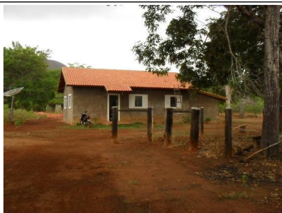
Foto 3.6.5.11-18 - Padrão construtivo das habitações do assentamento Santa Helena.
