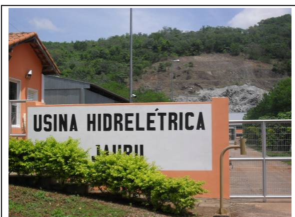
Foto 3.6.5.11 – 202 - Portaria da UHE Jauru
