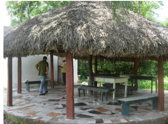
Foto 3.6.5.11-52 - Instalações do pesqueiro Santa Fé.
