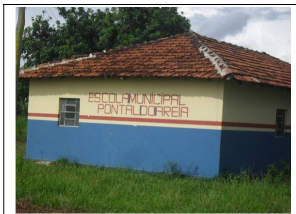
Foto 3.6.5.11-93 - Escola municipal de ensino fundamental;
