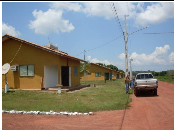
Foto 3.6.5.11-16 - Vila de Trabalhadores - Fazenda Fortaleza do Guaporé – Nova Lacerda (MT)
