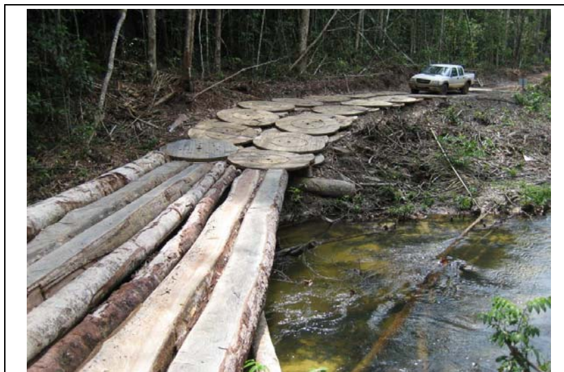
Figura 3.2.13-2 – Utilização da madeira da supressão de vegetação da faixa para acessos propostos para a LT 600kV CC Coletora Porto Velho – Araraquara 2 Nº 01.
