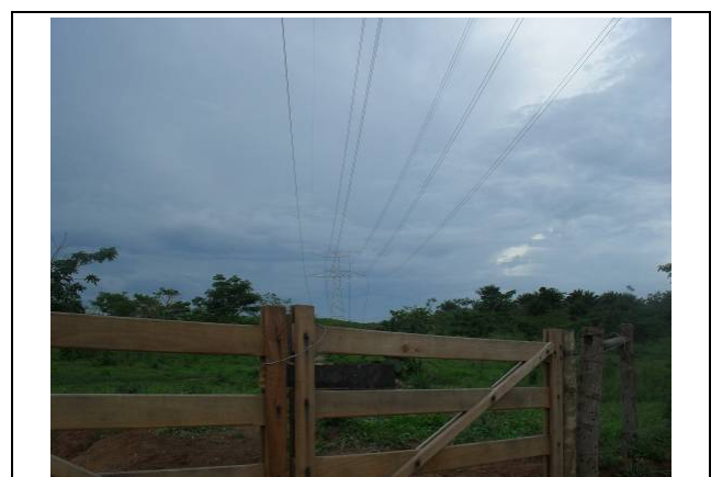
Foto 3.6.5.11 - 203- Passagem de linha de transmissão em área de pasto
