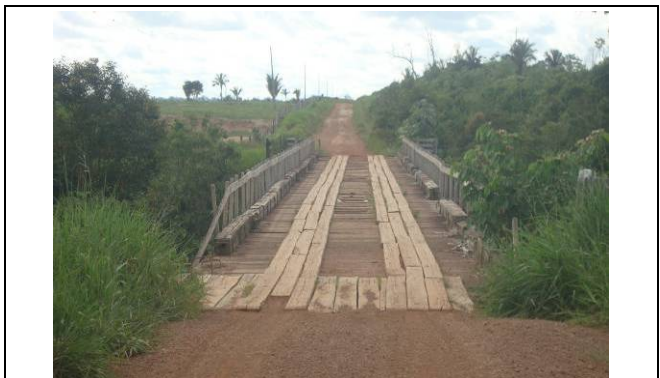
Foto 3.6.5.11 - 197 - Ponte sobre o Rio Cavallo “Véio” Porto Velho (RO)
