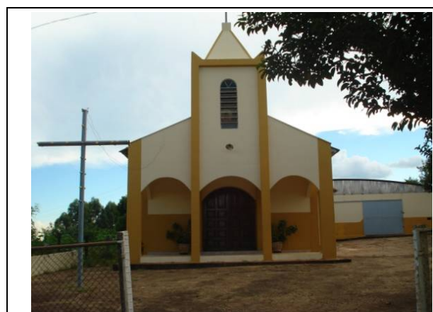
Foto 3.6.5.11-158 - Capela e Barracão em Córrego do Meio
