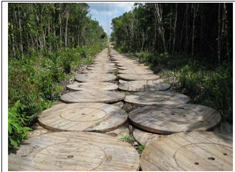
Figura 3.2.13-1 – Uso de estivas em áreas alagadas propostos para a LT 600 kV CC Coletora Porto Velho – Araraquara 2 IE Madeira.
