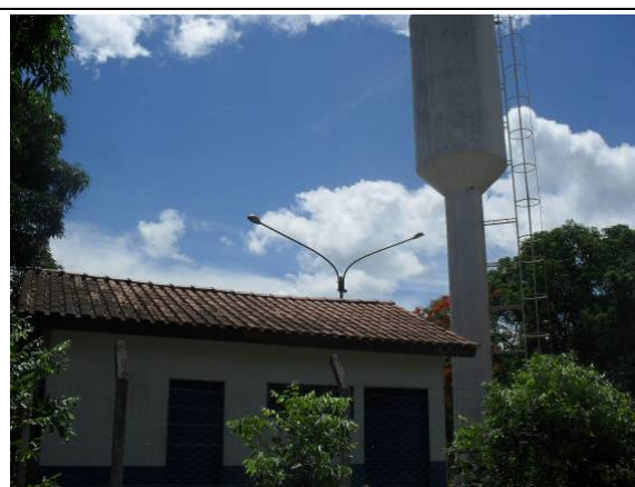
Foto 3.6.5.11-69 - Estação de Tratamento de Água e poço artesiano localizados no distrito
