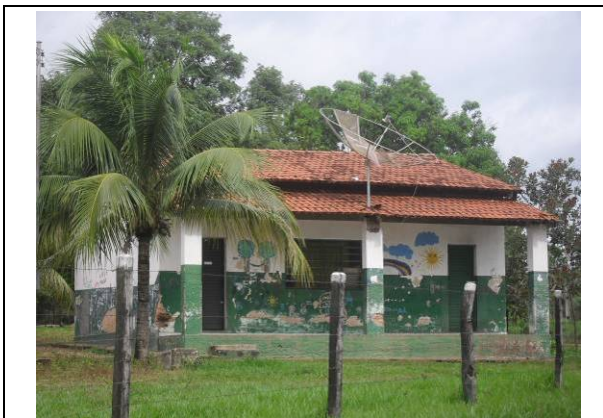
Foto 3.6.5.11-75 - Escola municipal de ensino fundamental da comunidade Água Limpa
