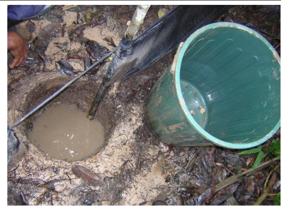
Foto 3.6.4.4-28: Devido às intensas chuvas no período, alguns baldes do Módulo 2 foram desativados. Coordenada X 702.252,023 / Y 8.648.269,900
