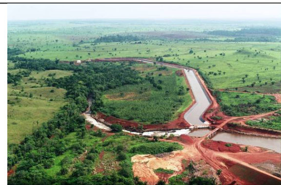
Foto 3.6.3.2-48 - Ponto 206: tomada d'água de PCH em terrenos com solos vermelhos espessos oriundos de basaltos da Formação Anari; não foram observados afloramentos e tampouco blocos de rocha.
