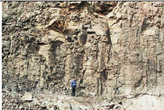
Foto 3.6.3.2-39 - Ponto 065: basalto são na parede direita da saída do vertedouro da barragem Foz do Rio Claro.
