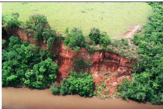
Foto 3.6.3.2-41 - Ponto 086: Barranco do Rio Verde sustentado por arenito Botucatu com visível estratificação cruzada denotando escorregamento no talude verticalizado.
