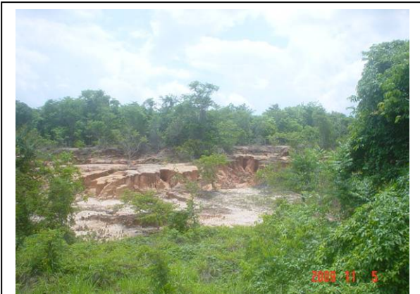
Foto 3.6.3.6-21 – Incidência de erosão em voçoroca sobre NEOSSOLO QUARTZARÊNICO Órtico, relevo suave ondulado, próximo ao trevo de Chupinguaia.
