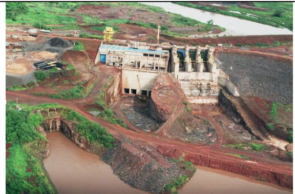
Foto 3.6.3.2-38 - Ponto 064: barragem Foz do Rio Claro, em construção, próxima à desembocadura desse rio no Rio Paranaíba, na divisa dos estados de Minas Gerais e Goiás; as obras de concreto estão assentadas em basaltos da Formação Serra Geral.
