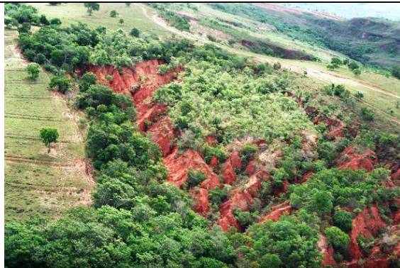
Foto 3.6.3.2-43 - Ponto 88: grande erosão em arenito da Formação Botucatu, na borda de patamar de relevo.
