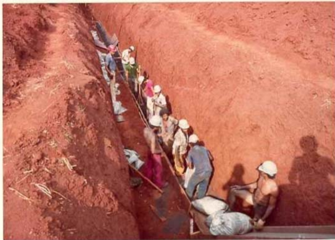
FOTO Nº 5 - Eltrodo sendo instalado a uma profundidade de 3 metros, e envolvido por uma camada de carvão (coque granulado) com seção transversal de 0,5 x 0,5m.
