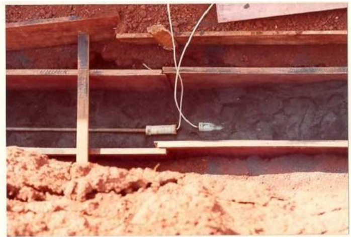
FOTO Nº 8 - Detalhe da confecção do envoltório de carvão, vendo-se as extremidades de duas hastes que serão conectadas entre si na superfície, através dos cabos soldados à sua extremidade.
