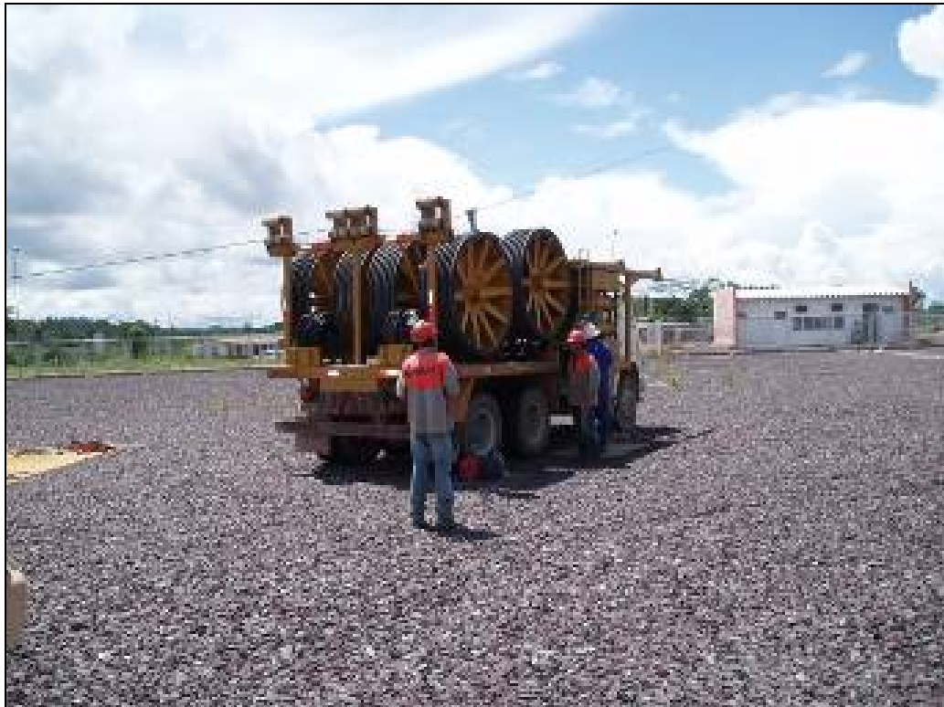
Figura 3.4-27 – Exemplo de praça de lançamento
