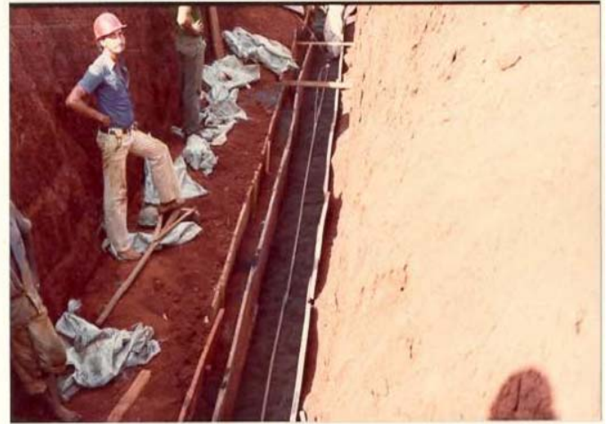
FOTO Nº 6 - Detalhe da confecção do envoltório de carvão.
