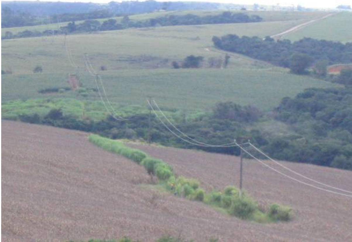
Figura 3.4-24 – Linha de eletrodo instalada nas proximidades da Estação Conversora de Ibiúna - SP
