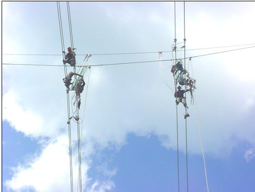
Figura 3.4-29 – Trabalhos de grampeamento
