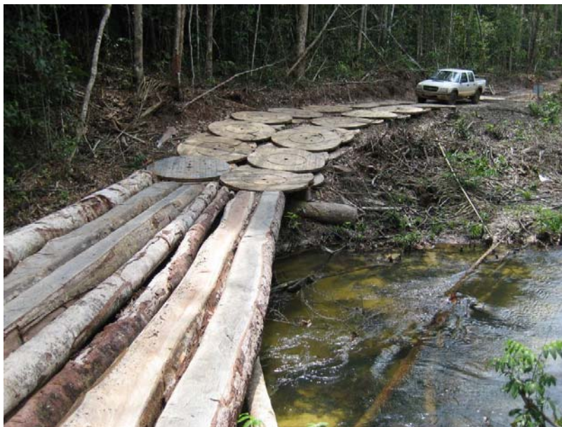
Figura 3.4-31 – Utilização da madeira da supressão de vegetação da faixa para acessos
