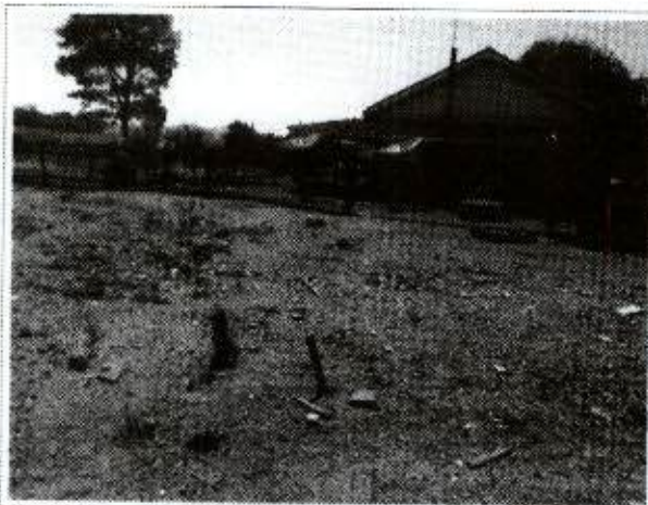
Foto 27 – Residência a ser demolida para a passagem da LT 2
