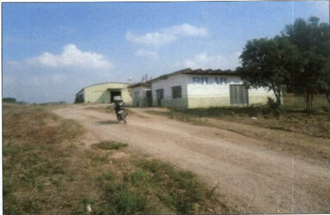
FIGURA 3 – VISTA FRONTAL DO CANTEIRO (ACESSO)
