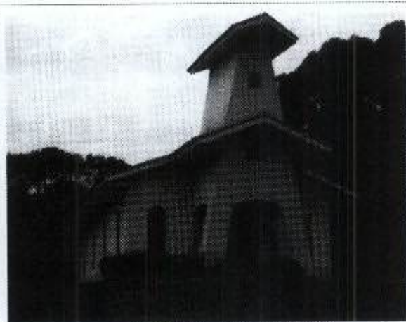
Foto 6 – Igreja da comunidade
