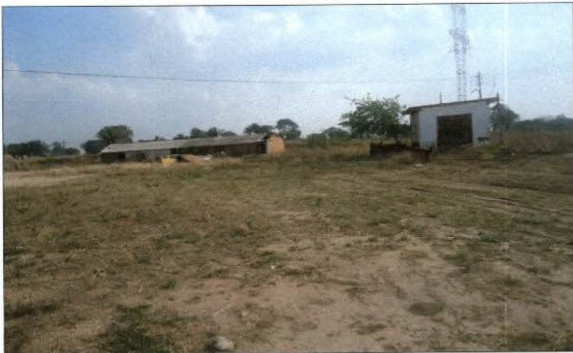
FIGURA 4 – VISTA DO INTERIOR DO CANTEIRO (CONSTRUÇÕES EXISTENTES)
