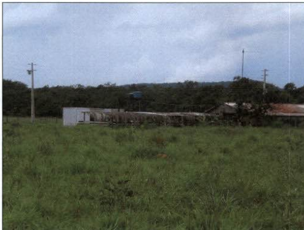
FIGURA 3. VISTA DO TERRENO DO CANTEIRO DE OBRAS.
