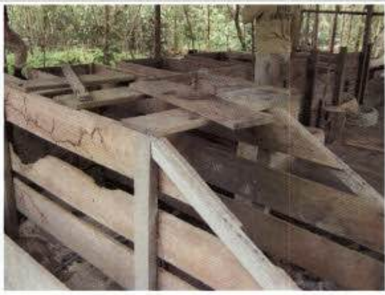
Ilustração 12: Benfeitoria da Fazenda Vó Helena nas proximidades do módulo MN1 – chiqueiro em construção.
