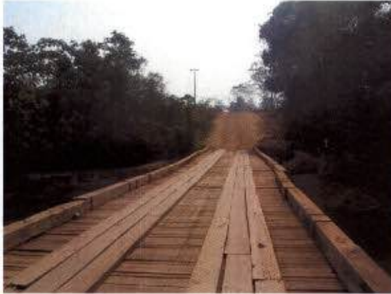
Ilustração 179: Ponte sobre o rio Cabixi.
