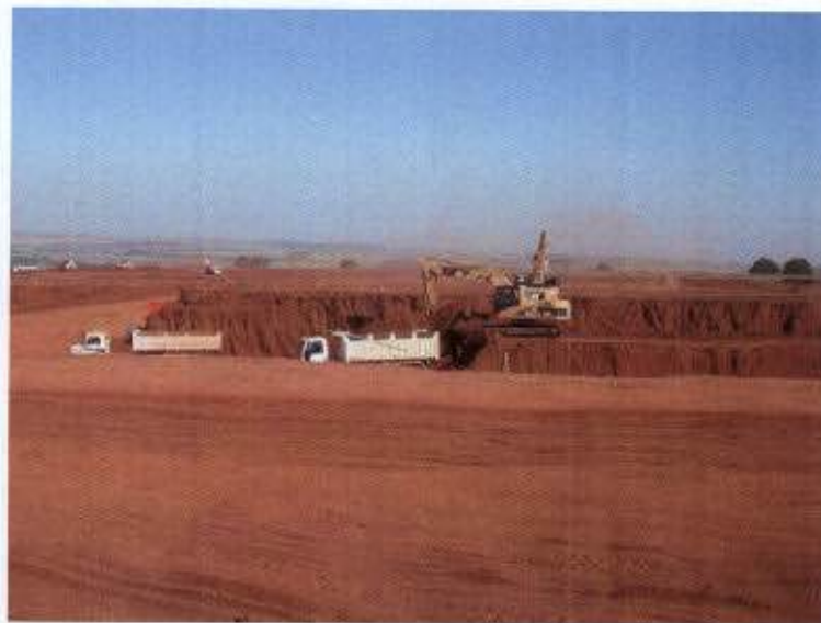
Ilustração 57: Subestação em Araraquara - SP.
