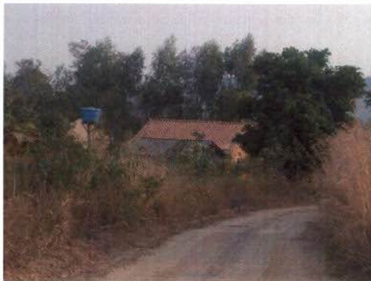
Ilustração 25: Casa que será demolida em Salto das Nuvens.
