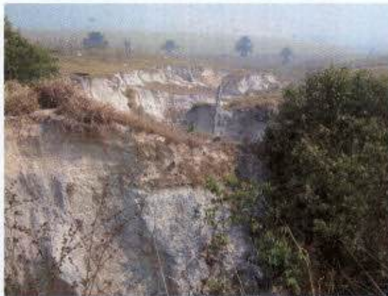
Ilustração 177: Processo erosivo acentuado ao lado da estrada de acesso ao fragmento florestal (Ponto VT1c).
