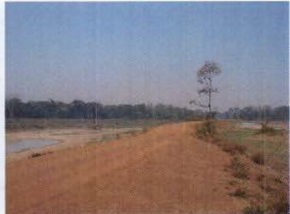
Ilustração 117: Estrada aterrada na planície de inundação do rio Cabixi.
