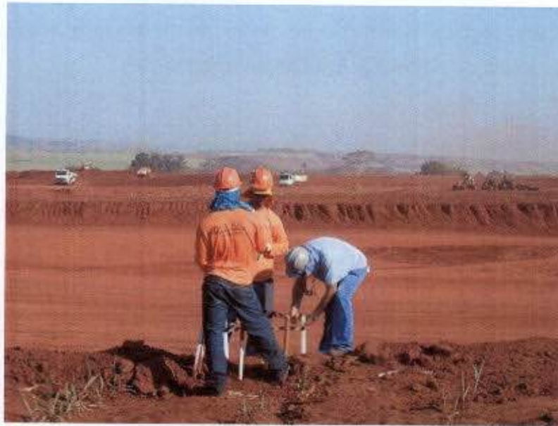
Ilustração 56: Subestação em Araraquara - SP.
