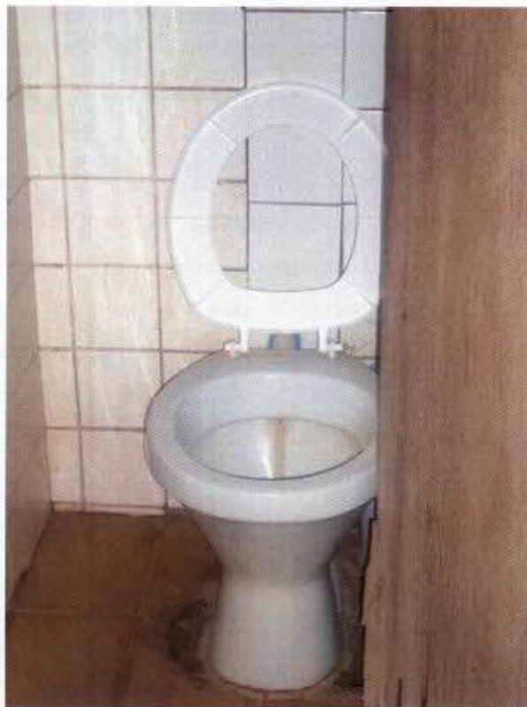
Ilustração 41: Banheiro da escola da comunidade Abolição.
