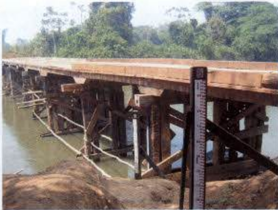
Ilustração 116: Ponte sobre o rio Cabixi e réguas limnimétricas da ANA.
