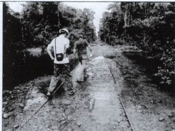
Ilustração 7: Acesso às torres 793-1 e 793-2 – Aterro não autorizado construído na área de inundação do rio Piolhinho, afluente do rio Guaporé. Apresenta 16 pontos submersos, deflagrando processos erosivos e assoreamento do rio.
