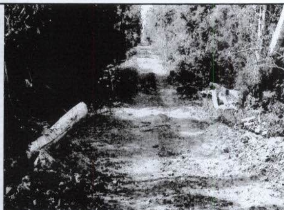
Ilustração 16: Acesso à torre 961-1 – Aterro não autorizado em área sujeita à inundação com pontos submersos, deflagrando processos erosivos e assoreamento do rio.
