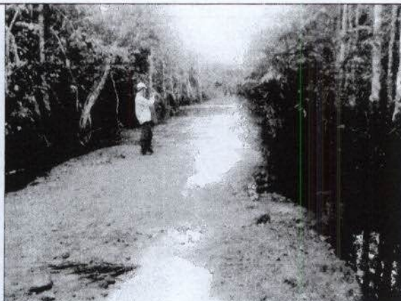
Ilustração 16: Acesso à torre 961-1 – Aterro não autorizado em área sujeita à inundação com pontos submersos, deflagrando processos erosivos e assoreamento do rio.
