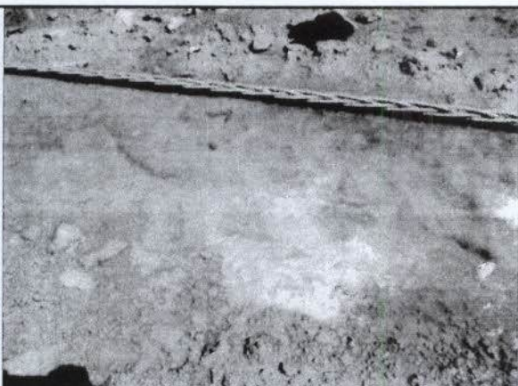
Ilustração 10: Acesso às torres 793-1 e 793-2 – Manchas de óleo sob a água, proveniente de óleo e graxa impregnados nos cabos-guia utilizados no lançamento de cabos condutores.
