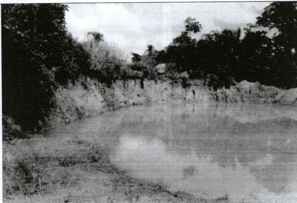
Ilustração 4: Área de empréstimo, sem prévia anuência deste Ibama, utilizada para construção do aterro no trecho entre as torres 961/1 e 961/2.
