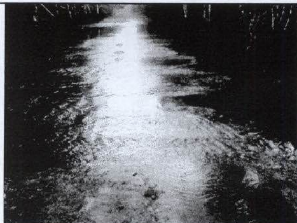
Ilustração 15: Acesso à torre 961-1 – Aterro não autorizado em área sujeita à inundação com pontos submersos, deflagrando processos erosivos e assoreamento do rio.
