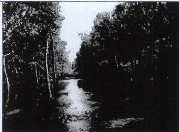
Ilustração 15: Acesso à torre 961-1 – Aterro não autorizado em área sujeita à inundação com pontos submersos, deflagrando processos erosivos e assoreamento do rio.
