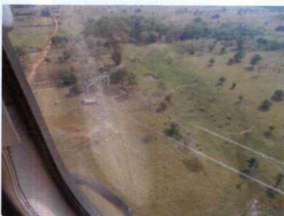
Figura 53: Benfeitoria próxima a torre 320/1. Coord. (11° 6'35.67"S 62° 9'17.20"O)
