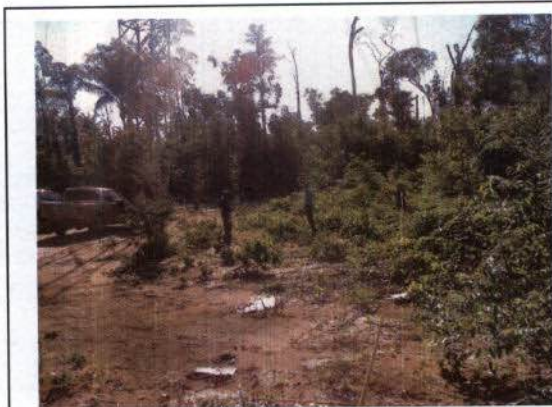
Ilustração 31: Registro de Não Conformidade Ambiental (RNC) n° 07 – Aferição da área de supressão a corte raso na torre estaiada 786-2, cuja área da base apresentava cerca de 1400 m 2 (42 x 33 m)
