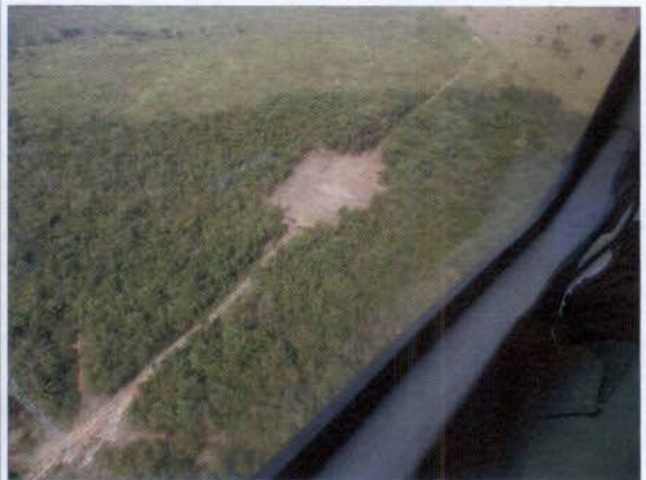
Figura 58: Praça de lançamento de cabos no interior de fragmento florestal no vão entre as torres 482/1 e 482/2. Coord. (12°13'16.73"S 61°13'59.46"O)
