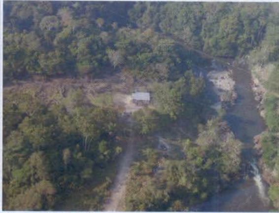
Figura 39: Benfeitoria no vão entre torres 3/1 e 4/1. Coord. (8°56'47.37"S 63°56'6.63"O)
