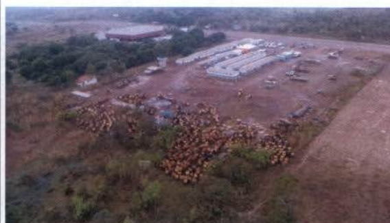
Figura 38: Bobinas vazias estocadas no canteiro de Cuiabá/MT. Empreendedor deverá providenciar destinação adequada. Coord. (15°29'52.14"S 56°3'48.95"O)
