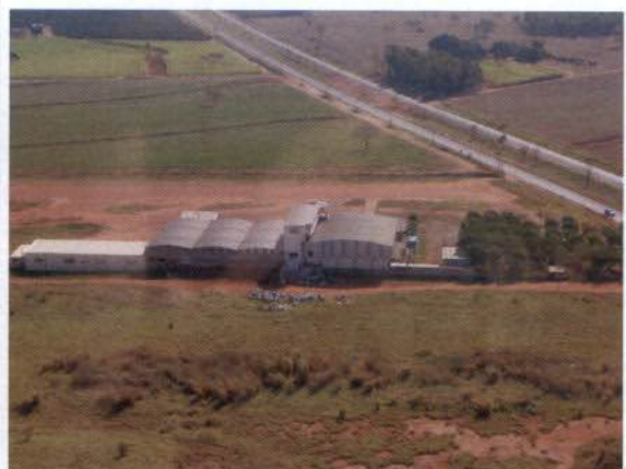
Figura 8: Resíduos no terreno próximo ao canteiro de Itápolis/SP. Coord. (21°33'45.67"S 48°47'47.94"O)
