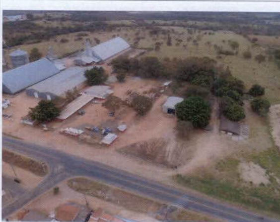
Figura 24: Bobinas vazias estocadas no canteiro de Mineiros/GO. Empreendedor deverá providenciar destinação adequada. Coord. (17°34'59.85"S 52°32'49.86"O)
