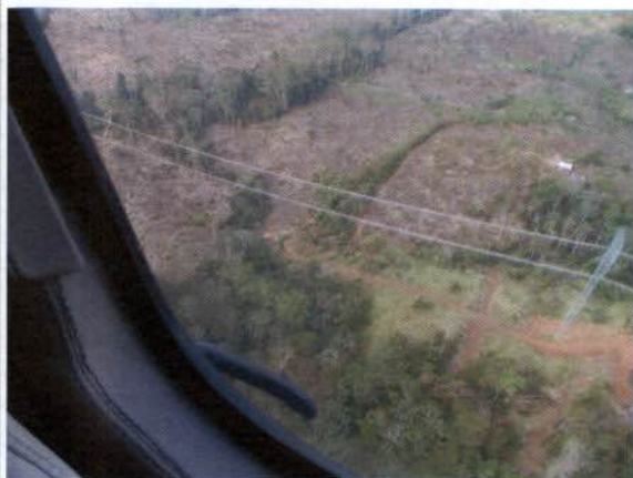
Figura 59: Benfeitorias no vão entre torres 566/1 e 567/1. Coordenada não registrada.
