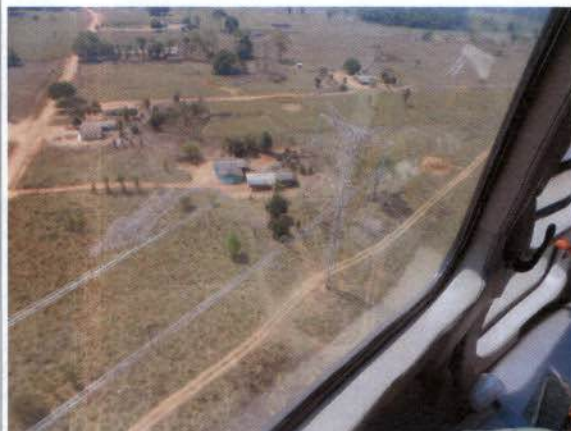
Figura 43: Benfeitoria no vão entre torres 101/2 e 102/1. Coord. (9°37'9.25"S 63°25'11.28"O)
