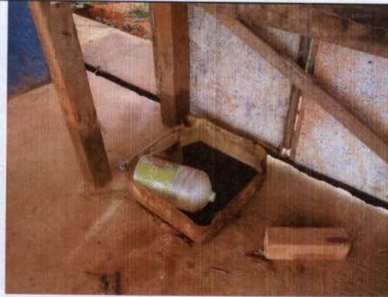
Ilustração 5: Canteiro Cabixi/ RO – Resíduos de substâncias tóxicas e contaminantes sem destinação final e armazenados de forma inadequada.
