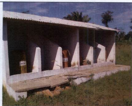
Ilustração 13: Canteiro Santa Amélia (Nova Lacerda/MT) - Tanque de diesel sobre o solo sem as devidas medidas preventivas para evitar contaminação.
