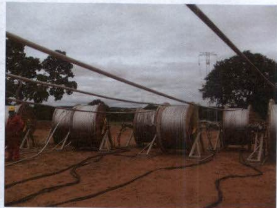
Foto 10 - Lançamento de cabos
