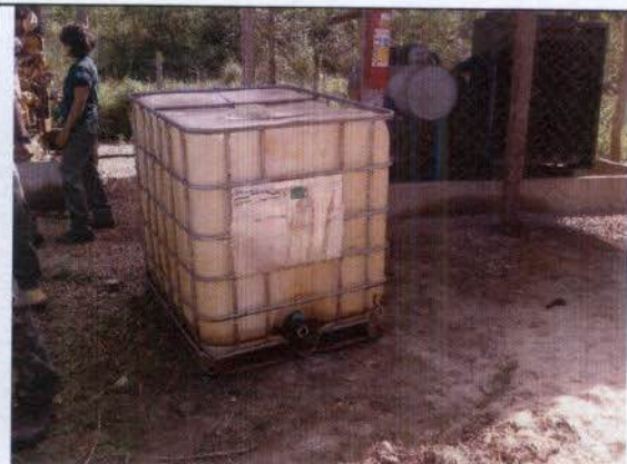
Ilustração 13: Canteiro Santa Amélia (Nova Lacerda/MT) - Tanque de diesel sobre o solo sem as devidas medidas preventivas para evitar contaminação.
