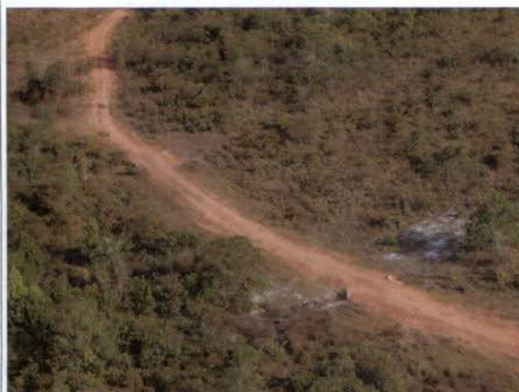
Figura 22: RNC 7-005. Relata aterramento de área alagada em 14/09/2013 para acesso a torre 1980/1. Foi possível verificar a construção de 2 bueiros. Coord. (18°13'51.27"S 51°59'4.59"O)
