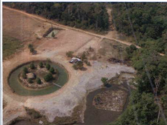
Figura 45: Benfeitorias no vão entre torres 121/2 e 122/1. Coord. (9°46'48.47"S 63°19'29.08"O)
