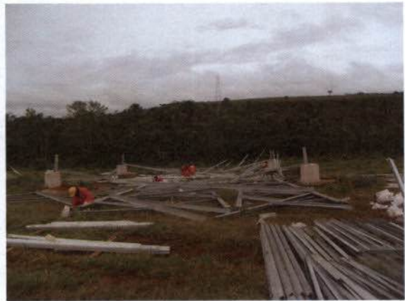
Foto 8 - Equipe em montagem de torre
