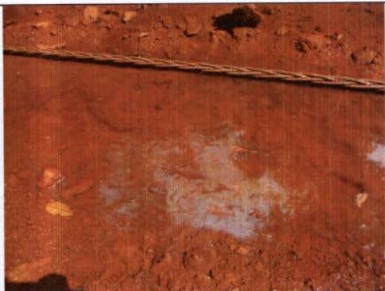
Ilustração 23: Acesso às torres 793-1 e 793-2 – Manchas de óleo sob a água, proveniente de óleo e graxa impregnados nos cabos-guia utilizados no lançamento de cabos condutores.
