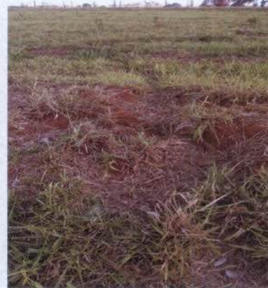
Figura 10: Necessidade de manutenção nas curvas de nível da área de reposição em Minas Gerais. Coord. (19°32'33.97"S 50°33'13.44"O)
