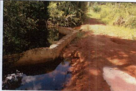
Ilustração 35: Acesso à torre 961-1 – Bueiro com armação danificada e buraco na parte superior, demonstrando o caráter precário dos aterros construídos e a celeridade do processo erosivo sobre a estrutura.
