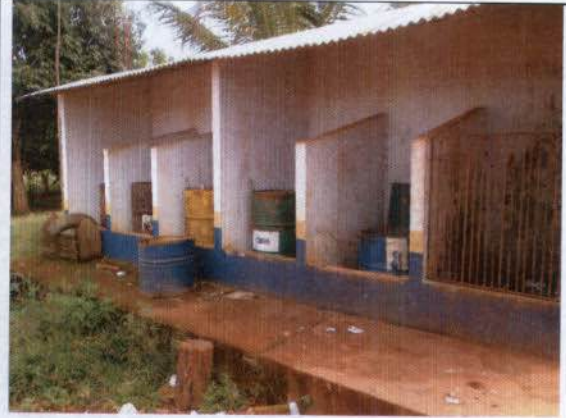
Ilustração 6: Canteiro Cabixi/RO - Baia de resíduos sem isolamento. Foi encontrado fezes de animais junto aos resíduos.
