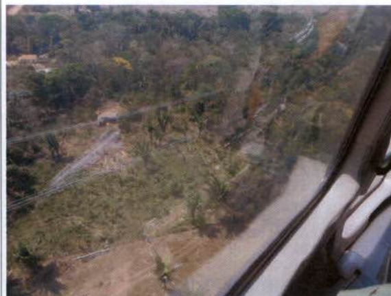
Figura 44: Possibilidade de benfeitoria no vão entre torres 113/2 e 114/1. Coordenada não registrada.
