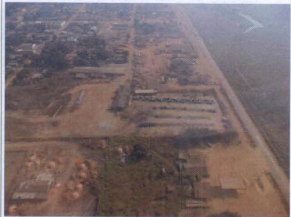
Figura 40: Bobinas estocadas no canteiro de Triunfo/RO. Empreendedor deverá providenciar destinação adequada. Coord. (9°17'6.24"S 63°27'46.35"O)
