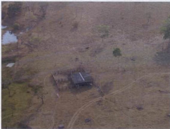
Figura 49: Benfeitorias no vão entre torres 239/1 e 240/1. Coordenada não registrada.
