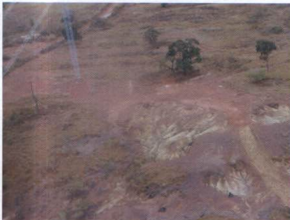
Figura 30: Processos erosivos preexistentes próximos ao acesso e base da torre 1635/1. Coord. (16°27'56.20"S 54°17'53.45"O)
