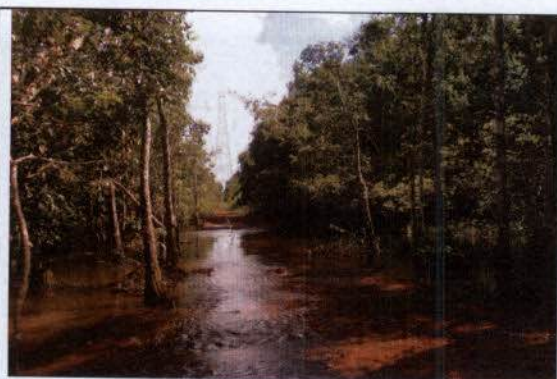
Ilustração 36: Acesso à torre 961-1 – Aterro não autorizado em área sujeita à inundação com pontos submersos, deslagando processos erosivos e assoreamento do rio.
