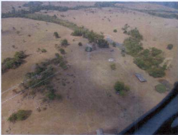
Figura 57: Benfeitorias no vão entre torres 448/1 e 449/1. Coord. (11°59'31.55"S 61°26'18.55"O e 11°59'31.90"S 61°26'16.92"O)
