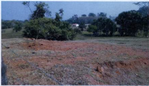
Figura 55: RNC 2-002. Relata, entre outros, área de empréstimo não autorizada em 19/02/2013. Foi verificado abandono da área sem execução de PRAD. Coord. (11° 8'21.38"S 62° 7'34.72"O)
