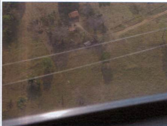
Figura 51: Benfeitorias no vão entre torres 273/1 e 274/1. Coordenada não registrada.
