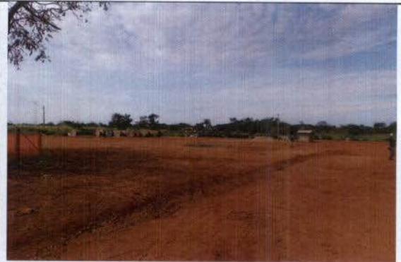
Ilustração 8: Canteiro Cabixi/RO – Ausência de processos erosivos. Sistema de drenagem do canteiro.
