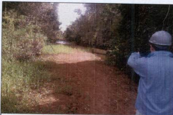
Ilustração 34: Acesso à torre 961-1 – Aterro não autorizado em área sujeita à inundação, para possibilitar o trânsito de maquinário e veículos neste local.
