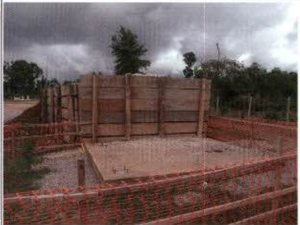
Ilustração 34: Instalação do sistema de tratamento de efluente sanitário no canteiro da Norte Brasil.
