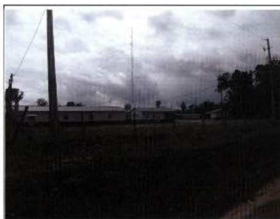
Ilustração 27: A área destinada ao canteiro da Norte Brasil na comunidade de Santa Amélia, Nova Lacerda/MT, evidenciando a instalação de alojamentos.
