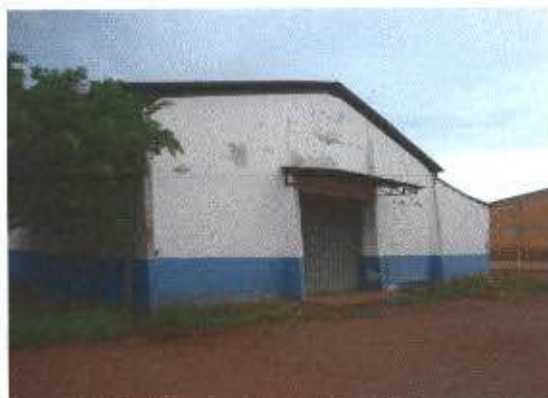
Foto-003- Barracão fechado, tamanho 17,00m x 24,50m
