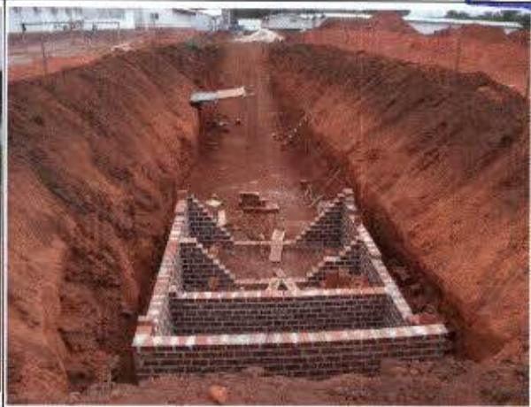
Ilustração 34: Instalação do sistema de tratamento de efluente sanitário no canteiro da Norte Brasil.
