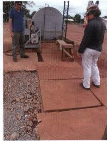
Ilustração 30: Caixa separadora de água e óleo (SAO) para tratamento do efluente proveniente de eventuais vazamentos na área de abastecimento de veículos.
