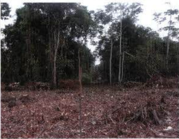
Ilustração 15: Faixa de serviço com largura de 7 m no vão entre as torres 726-2 e 726-3, demonstrando o fechamento das copas e a provável necessidade de realização de corte seletivo para passagem dos cabos.
