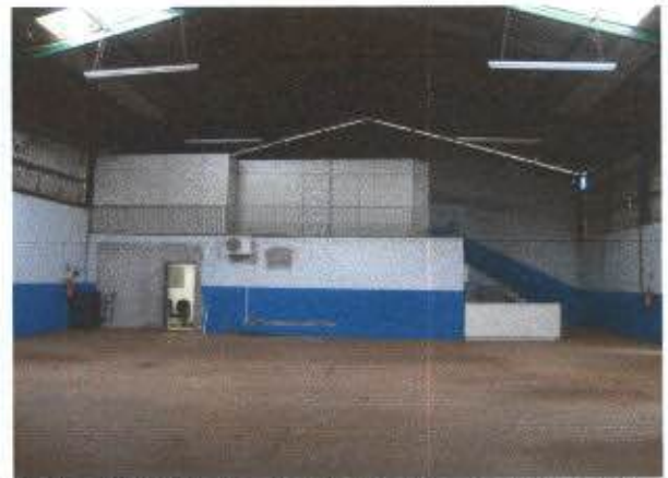
Foto-009-Parte do Barracão, construção de 01 piso- área de 6,00m x 17,00m
