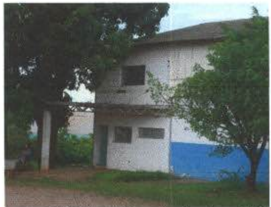
Foto-002-Vista da entrada do prédio. Edificado na área proposta.
