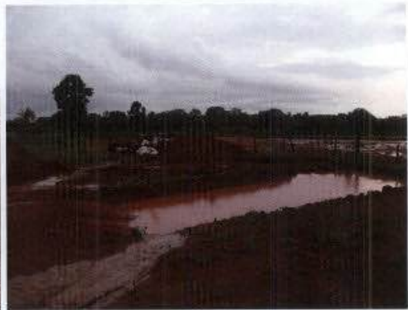
Ilustração 6: Área de produção de concreto em caminhões betoneira no canteiro da IE Madeira.
