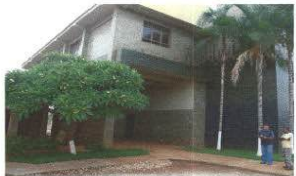
Foto-013- Construção de 02 pisos
