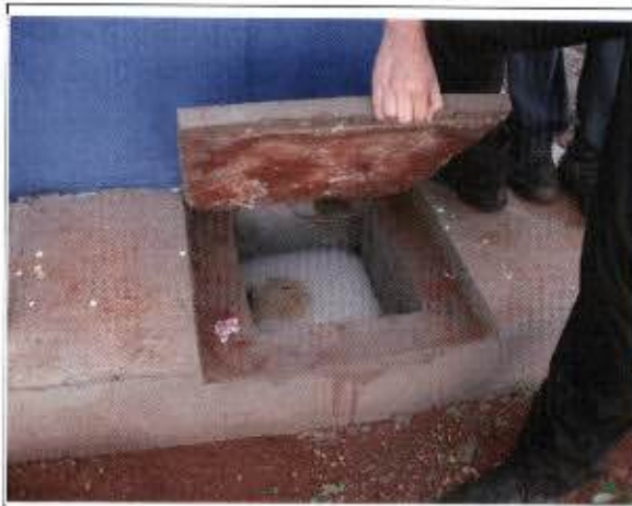
Ilustração 11: Área de armazenamento de óleo e substâncias perigosas no canteiro da IE Madeira, evidenciando a inadequação da caixa separadora de água e óleo (SAO).
