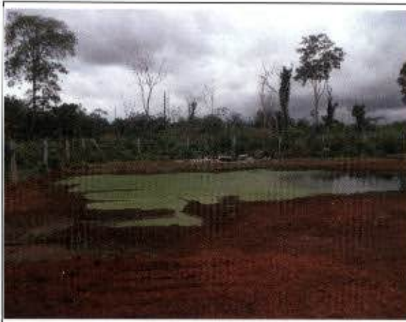
Ilustração 33: Poça de efluente sanitário formada pelo vazamento do efluente do sumidouro no canteiro da IE Madeira.
