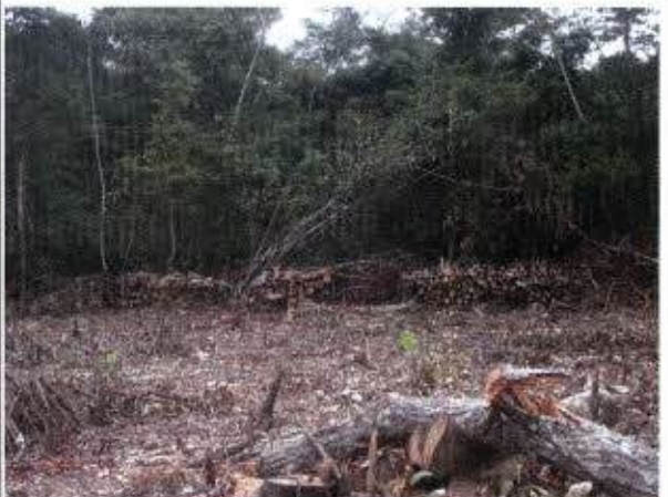
Ilustração 16: Faixa de serviço com largura de 7 m no vão entre as torres 726-2 e 726-3, demonstrando uma situação de menor necessidade de realização de corte seletivo devido ao baixo grau de fechamento de copas.
