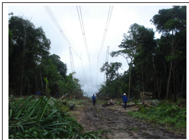
Foto 2.5-6 – Utilização de gabarito, em outra LT, para verificar a distância de segurança entre a copa das árvores e o cabo condutor. Fonte: ATE III/BIODINÂMICA, 2007
