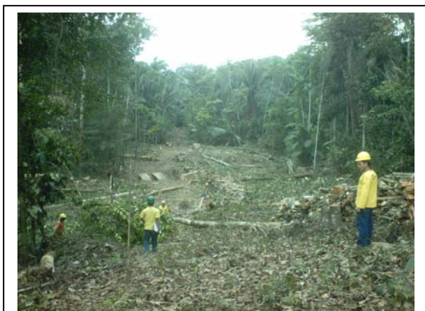
Foto 2.5-5 – Faixa de serviço sendo aberta (em outra obra). Fonte: ATE III/BIODINÂMICA, 2007
