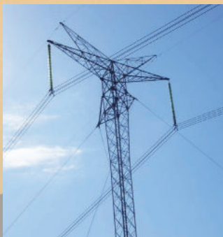
Torre do tipo estaiada
