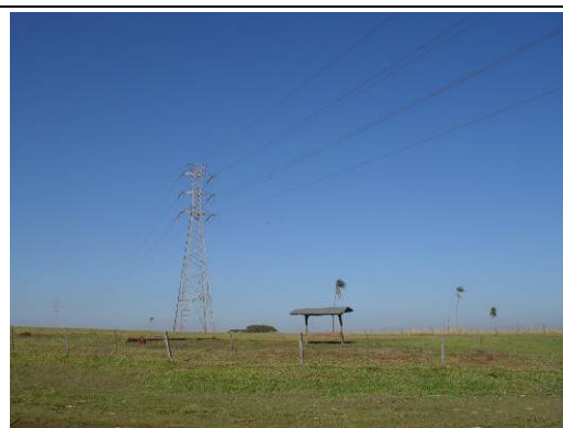
Foto 3.6.5.11-68 - LT já instalada em área de pastagem.
