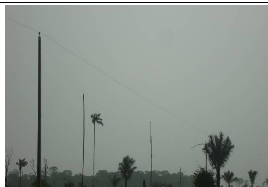
Foto 3.6.5.3-7 - Rede elétrica – Linha 37 – Porto Velho/RO
