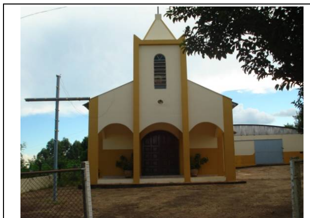
Foto 3.6.5.11-144 - Capela e Barracão em Córrego do Meio
