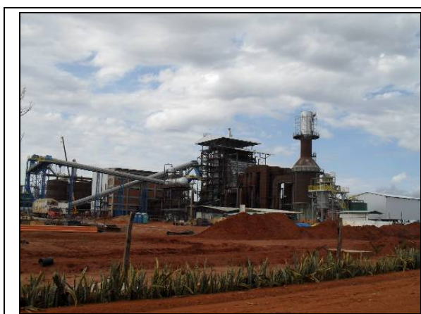
Foto 3.6.5.11-189 - Construção de usina de açúcar e Alcool no município de Limeira do Oeste – MG
