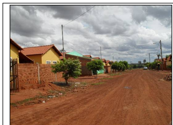
Foto 3.6.5.11-49 - Ruas do Conjunto habitacional Paraíso. No município de Limeira do Oeste-MG.
