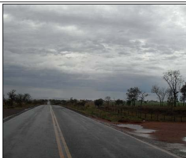
Foto 3.6.5.11-22 - Rodovia estadual que liga o município de Itarumã com o município de Caçu, cortada pela LT 600kV CC Coletora Porto Velho – Araraquara 2, Nº 02.
