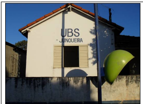
Foto 3.6.5.4-2 - Unidade Básica da Saúde no distrito de Junqueira- Monte Aprazível-SP
