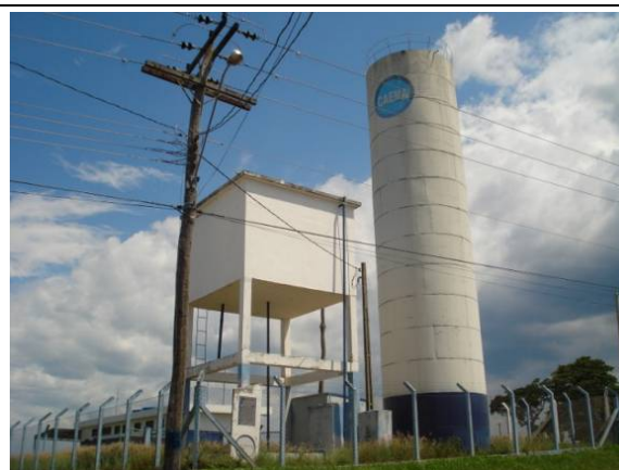
Foto 3.6.5.11-159 - Distrito de São Lourenço do Turvo – caixa d'água
