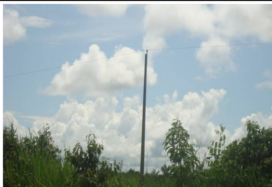
Foto 3.6.5.3-6 - Rede elétrica a 10 metros da área de instalação do eletrodo de terra Nº 02 – Linha 53 – Porto Velho/RO
