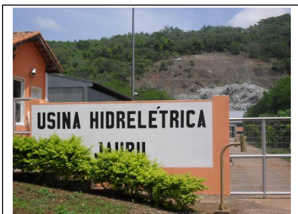
Foto 3.6.5.11 - 226 - Portaria da UHE Jauru
