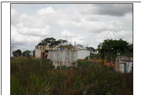
Foto 3.6.5.11-46 - Estação de tratamento da COPASA no município de Limeira do Oeste-MG.
