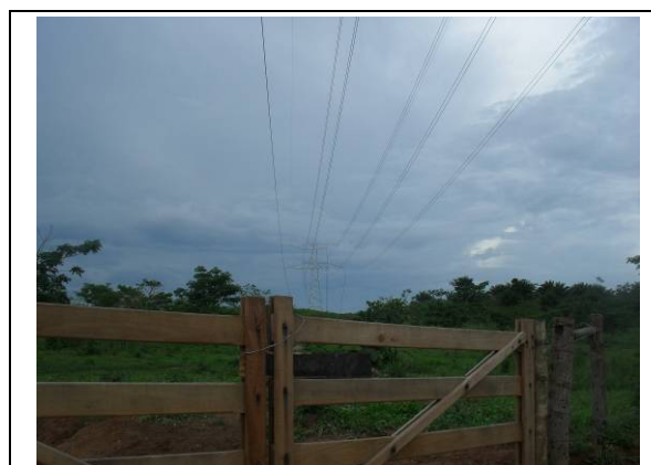
Foto 3.6.5.11 - 227 - Passagem de linha de transmissão em área de pasto
