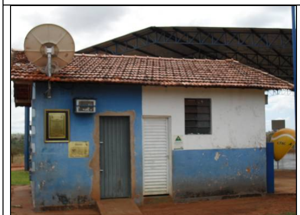
Foto 3.6.5.5 - 7 - Núcleo do projeto estruturador de inclusão digital da Escola Municipal Cachoeiras
