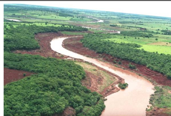
Foto 3.6.3.2-40 - Ponto 075: rio Verde, com as margens desmatadas devido a formação de reservatório de barragem em construção, expondo solos vermelhos argilosos de composição de basaltos da Formação Serra Geral.
