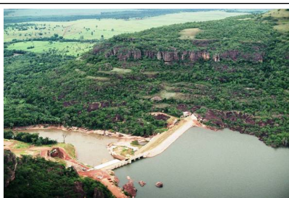
Foto 3.6.3.2-77 - Ponto 379: escarpas de arenitos da Formação Furnas; barragem de PCH no rio São Lourenço, vendo-se ao fundo área de terrenos rebaixados que se desenvolvem para o sul a partir do sopé das escarpas.
