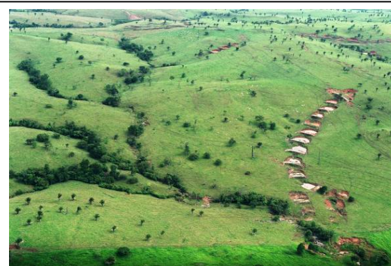
Foto 3.6.3.2-124 - Ponto 344: área de domínio do Grupo Alto Jauru, vendo-se pequenos tanques construídos em cascata em terrenos com espessas coberturas de solo, denotando pequenas erosões na saída do último tanque.
