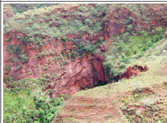
Foto 3.6.3.5-11 – Movimentos de massa: escorregamento planar e queda de blocos ocasionais na Formação Aquidauana, do relevo de Morros e Morrotes Alcantilados no Planalto Central da Bacia do Paraná.
