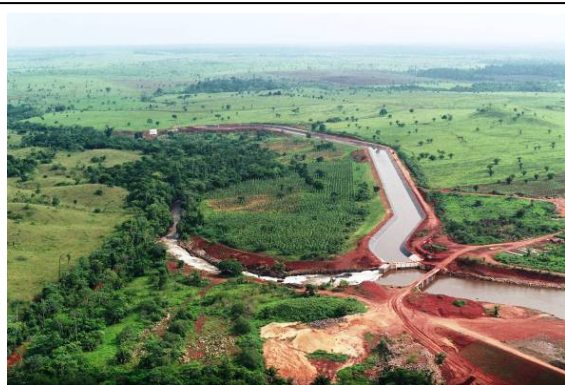
Foto 3.6.3.2-51 - Ponto 206: tomada d'água de PCH em terrenos com solos vermelhos espessos, não tendo sido observados afloramentos ou blocos de rocha. Formação Anari (basalto).
