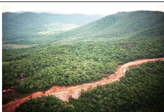
Foto 3.6.3.2-89 - Ponto 373: duplicação de rodovia em trecho serrano florestado, expondo rochas graníticas com cobertura de solos pouco espessos, no domínio do Granito São Vicente.
