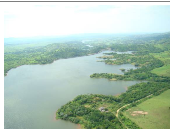
Foto 3.6.3.9-18 – Reservatório no rio Jauru.
