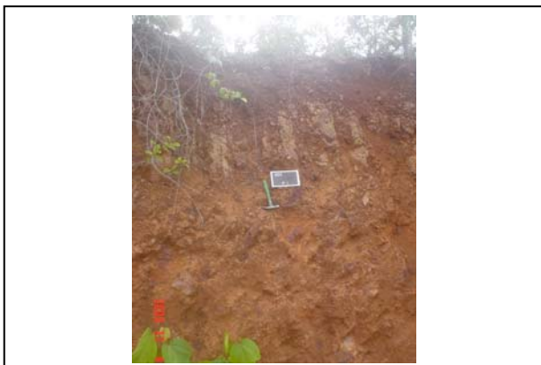
Foto 3.6.3.6-1 – Perfil de PLINTOSSOLO PÉTRICO Litoplíntico êndico, textura argilosa, sob floresta. Ocorrência significativa nas proximidades de Porto Velho junto a LATOSSOLOS AMARELOS. Coordenadas E9.018.058 e N395.368.
