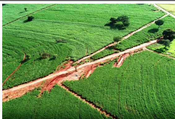
Foto 3.6.3.2-39 - Ponto 436: canais laterais de estrada vicinal para escoamento e retenção de água de chuva; extensos canaviais em área de contato entre arenitos finos e muito finos da Formação São José do Rio Preto e arenitos, muitas vezes argilosos, da Formação Vale do Rio do Peixe.
