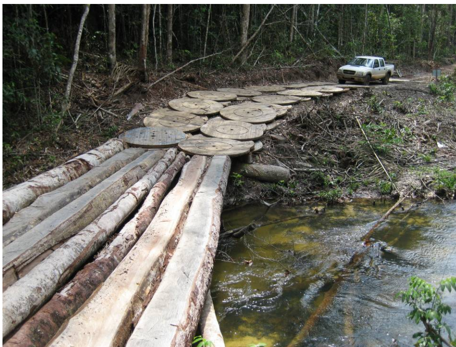
Figura 3.4-32 – Utilização da madeira da supressão de vegetação da faixa para acessos
