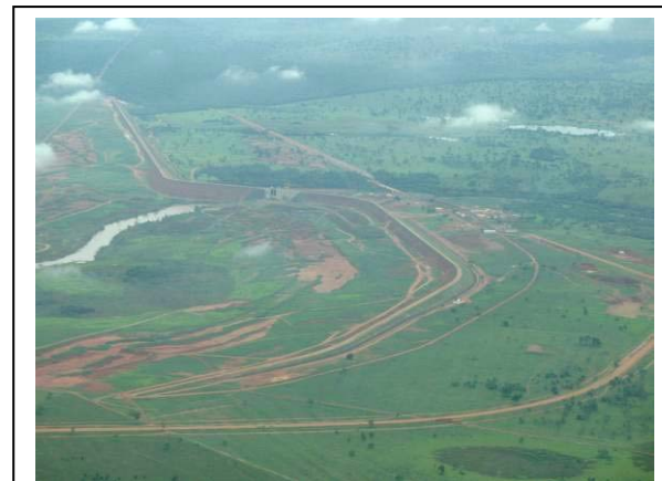
Foto 3.5.2-58 – Obras da UHE Salto do Rio Verdinho (rio Verde), GO.
