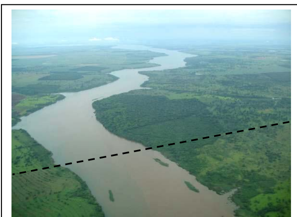
Foto 3.5.2-59 – Travessia do rio Paranaíba, na divisa entre Goiás e Minas Gerais.
