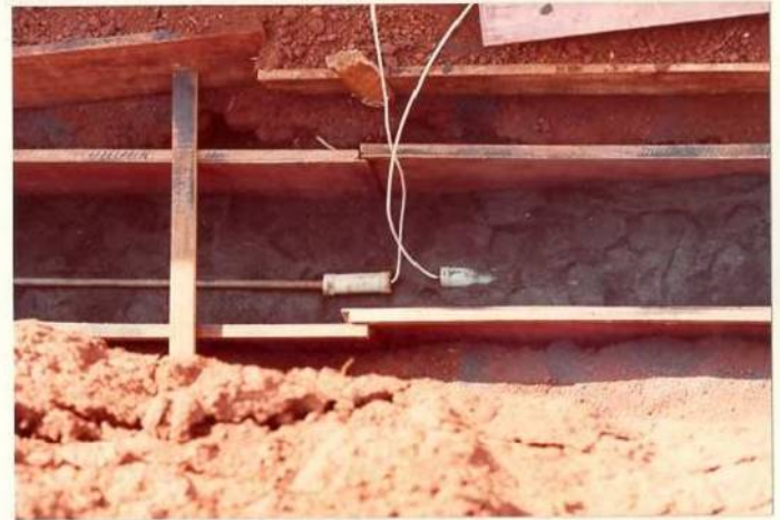
FOTO Nº 8 - Detalhe da confecção do envoltório de carvão, vendo-se as extremidades de duas hastes que serão conectadas entre si na superfície, através dos cabos soldados à sua extremidade.
