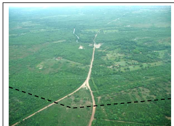
Foto 3.5.2-30 – Passagem da diretriz selecionada ao norte da área urbana de Cuiabá, sobre relevo de colinas, com acessos e ocupação por sítios.
