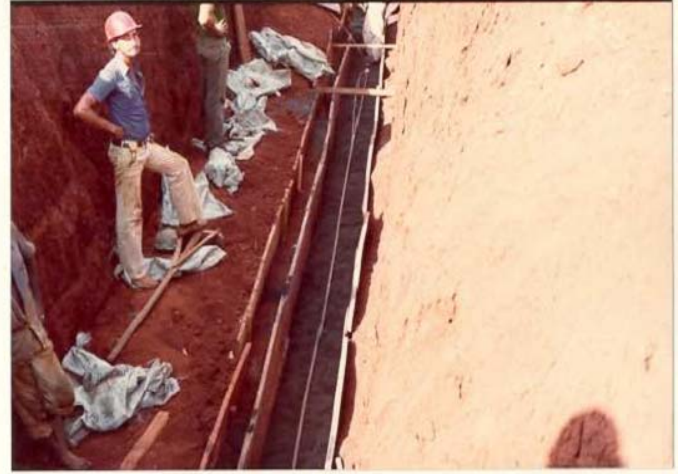
FOTO Nº 6 - Detalhe da confecção do envoltório de carvão.
