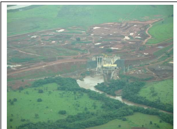
Foto 3.5.2-57 – Obras da UHE Salto no rio Verde (GO).
