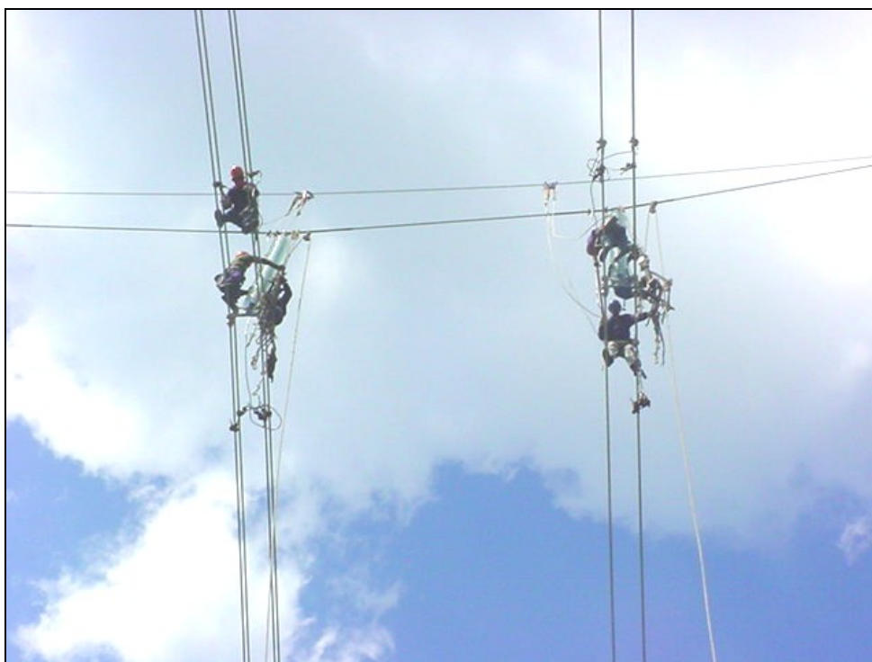
Figura 3.4-30 – Trabalhos de grampeamento
