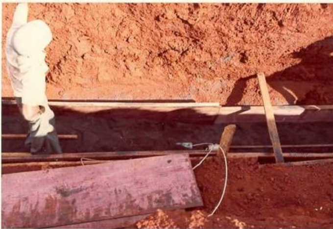
FOTO Nº 7 - Detalhe da confecção do envoltório de carvão, vendo-se as extremidades de duas hastes que serão conectadas entre si na superfície, através dos cabos soldados à sua extremidade.
