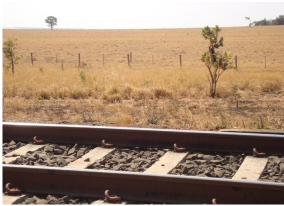
Ferrovia Ferronorte S/A Coordenadas: 0354045/7913119
