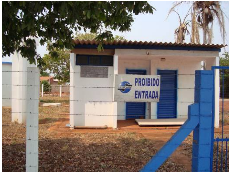
Foto 4. 21 - Sistema de Abastecimento de Água / Aporeé.
