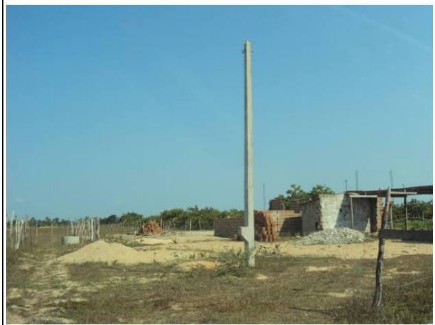
Foto 8.3.3-6 – Casas em construção no PA São Sebastião
