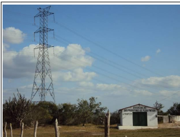
Foto 8.3.3-65 – Sede da Associação de Produtores Rurais de Pedra Pintada, em Esperança
