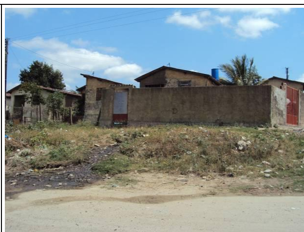
Foto 8.3.3-86 – Esgoto a céu aberto e padrão construtivo do bairro Mutirão, em Campina Grande
