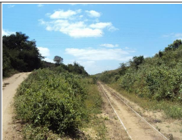
Foto 8.3.3-76 – Cruzamento com a Linha Férrea Transnordestina, na localidade de Sítio São Januário, em Campina Grande
