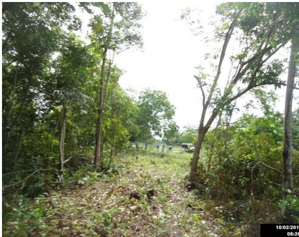
Foto 10.6.1-1 – Vista do vão aberto após a frente de supressão (exemplo de outra obra)
