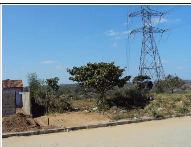
Foto 8.3.3-82 – Vista da LT existente, ao lado de casas do bairro São Januário, em Campina Grande
