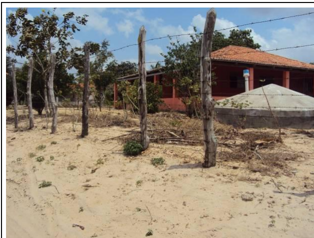
Foto 8.3.3-31 – Casa na AID, na localidade de Olho d'Água, em Lagoa de Pedras
