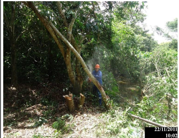
Foto 10.6.1-2 – Atividade de supressão de vegetação (outra obra)
