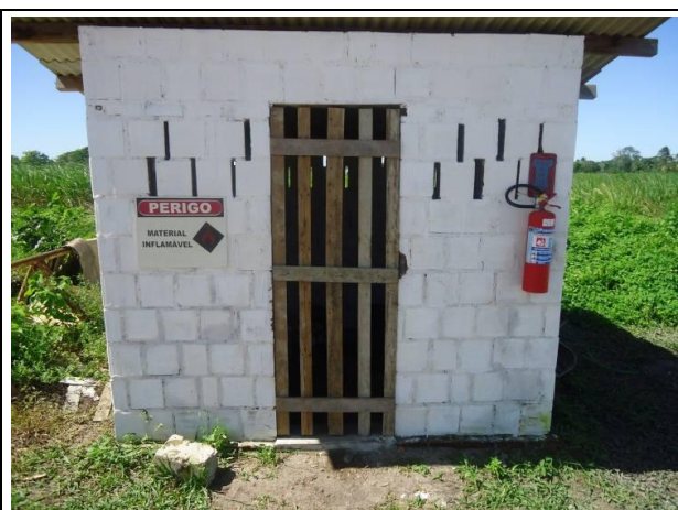
Foto 10.6.1-11 – Baía de armazenamento de produtos inflamáveis (exemplo)
