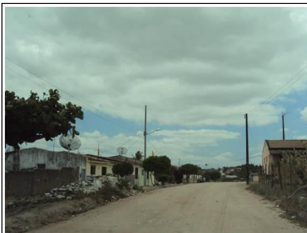
Foto 8.3.3-67 – Via principal do povoado de Lagoa de Pedra, em Esperança
