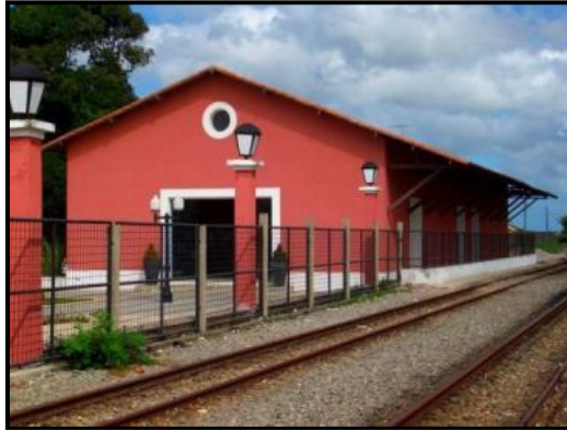
Prédio atual da Estação Ferroviária Fonte: www.estacoesferroviarias.com.br
