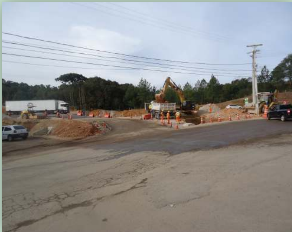
Foto 30: Obras na rodovia BR-376, em São José dos Pinhais/PR
