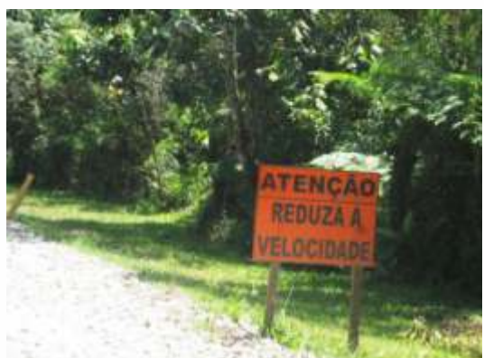
Foto 38: Exemplo de medida do PAC: controle de sinalização de obra
