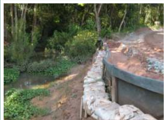
Foto 37: Exemplo de medida do PAC: contenção - controle de erosão e assoreamento
