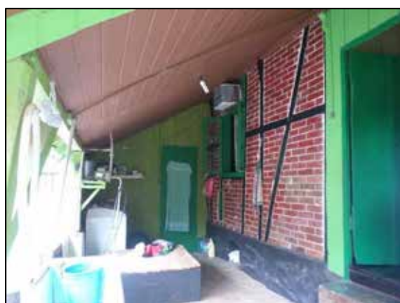
FIGURA 78: VISTA INTERNA DO ANEXO DA CASA ENXAIMEL DE RUDIMAR DREWS
