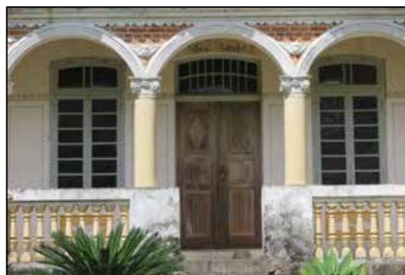
FIGURA 39: DETALHE DA VARANDA DA CASA SCHIOCKET
