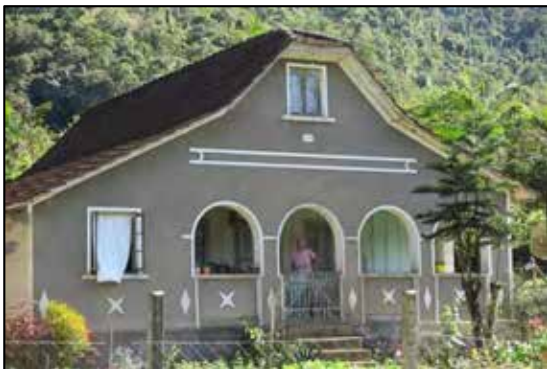
FIGURA 57: VISTA FRONTAL DA CASA ALVINO OLDENBURG. COORD. UTM 22J 681888 E/ 7059676 N
