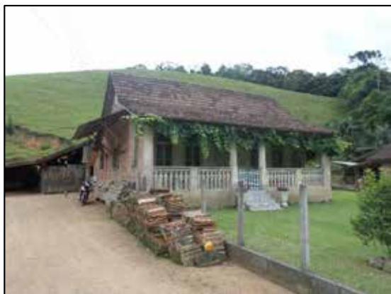
FIGURA 79: VISTA GERAL DA CASA ENXAIMEL DE ARNO JUNGGTON. COORD. UTM 22J 681569 E/ 7058340 N
