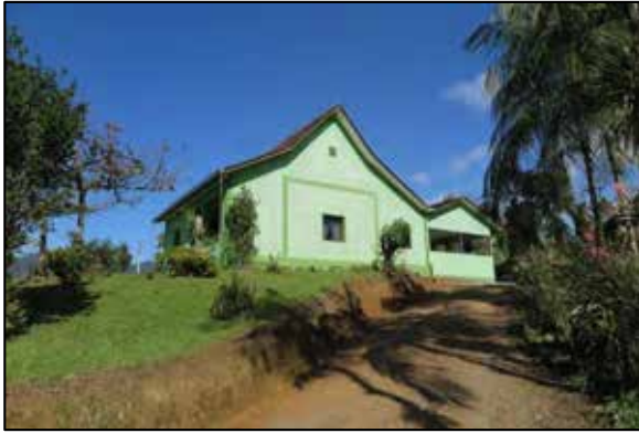
FIGURA 53: VISTA LATERAL DA CASA KRUGER. COORD. UTM 22J 681831 E/ 7059263 N
