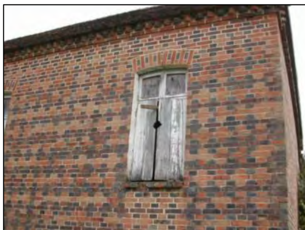
FIGURA 16: CASA DE ALVENARIA DE TIJOLOS APARENTES. FONTE: KANAN, 2008
