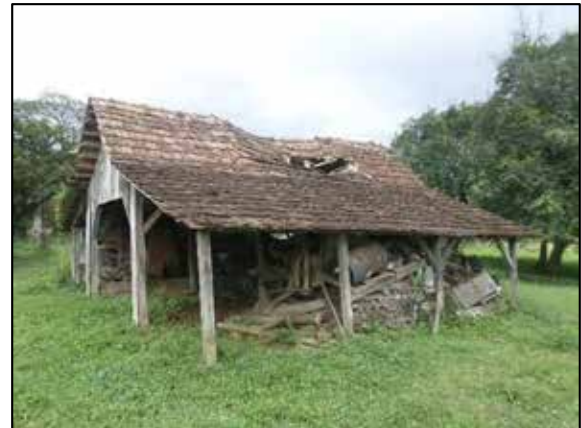
FIGURA 62: DETALHE DA ESTRUTURA EXISTENTE NA PROPRIEDADE RURAL DE ALINDO GLATZ
