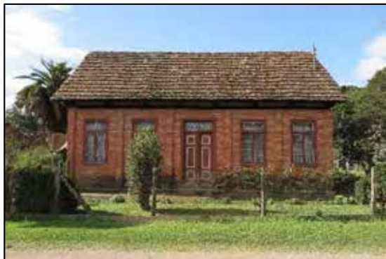
FIGURA 14: CASA DE ALVENARIA APARENTE (CASA STRUCK)
