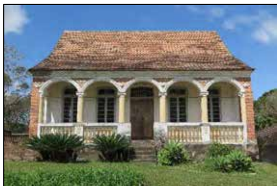
FIGURA 12: CASA DE ALVENARIA APARENTE (CASA SCHIOCKET)
