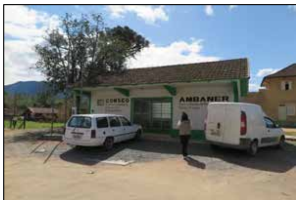
FIGURA 18: ESTAÇÃO FERROVIÁRIA NEREU RAMOS. COORD. UTM 22J 682669 E/ 7073128 N
