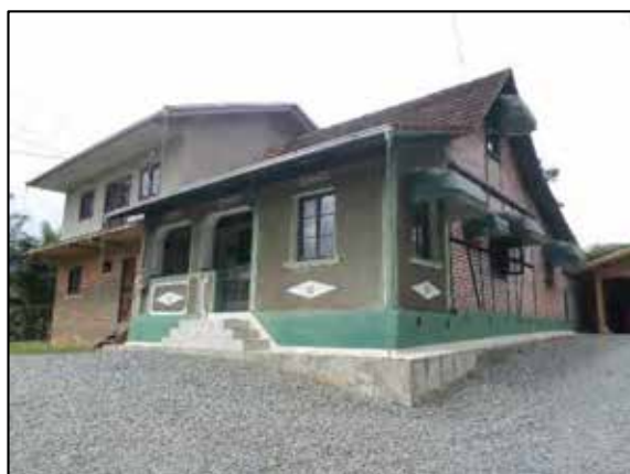
FIGURA 69: VISTA FRONTAL DA CASA ENXAIMEL DE ERNA HORNBERG. COORD. UTM 22J 680190 E/ 7059266 N
