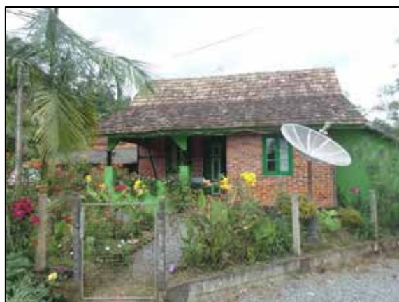
FIGURA 75: VISTA FRONTAL DA CASA ENXAIMEL DE RUDIMAR DREWS. COORD. UTM 22J 681622 E/ 7057730 N
