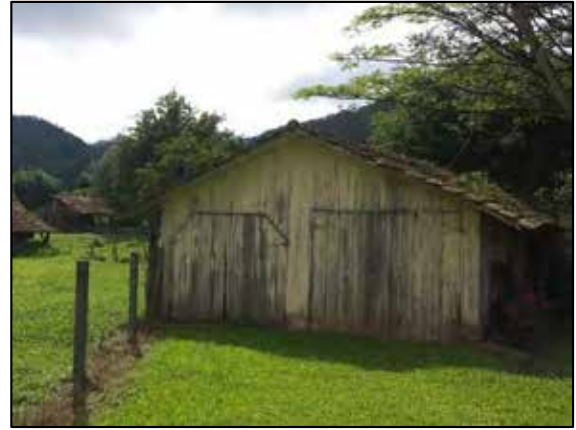
FIGURA 64: GALPÃO EXISTENTE NA PROPRIEDADE RURAL DE ALINDO GLATZ
