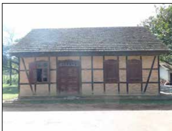
FIGURA 36: VISTA FRONTAL DA CASA WUNDERWALD. COORD. UTM 22J 684493 E/ 7042670 N
