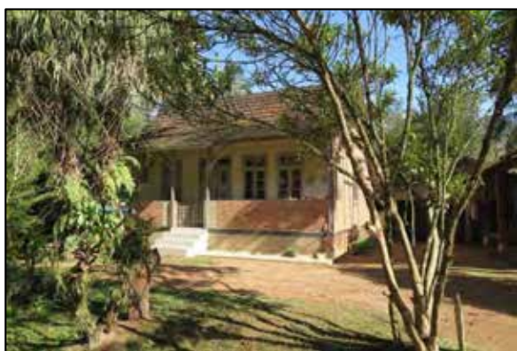
FIGURA 49: VISTA FRONTAL DA CASA ARNO KLITZKE. COORD. UTM 22J 681728 E/ 7058594 N
