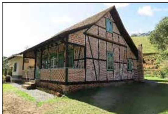
FIGURA 8: CASA ENXAIMEL COM FECHAMENTO EM TIJOLO MACIÇO (CASA RUX)
