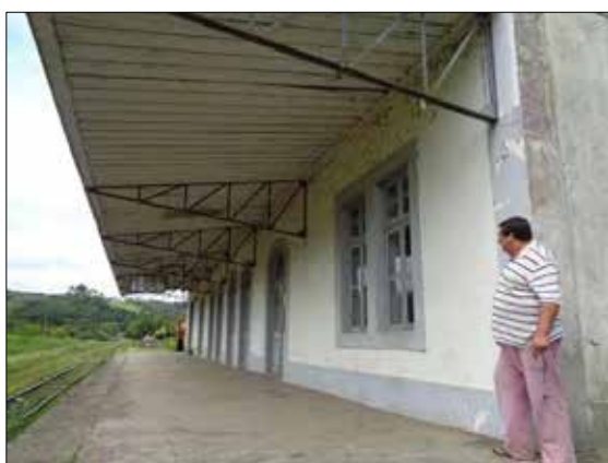
FIGURA 27: ESTAÇÃO FERROVIÁRIA RIO VERMELHO. COORD. UTM 22J 666024 E/ 7091971 N
