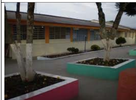
Foto 57: Prédio da EEEFM Eunice Borges Rocha, no Bairro Contenda, responsável pelo atendimento da demanda por ensino médio do Bairro Córrego Fundo, São José dos Pinhais – PR.
