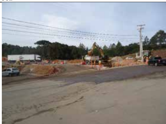
Foto 52: Obras na rodovia BR-376, para criação de acesso ao Bairro Rio de Una, município de São José dos Pinhais – PR.
