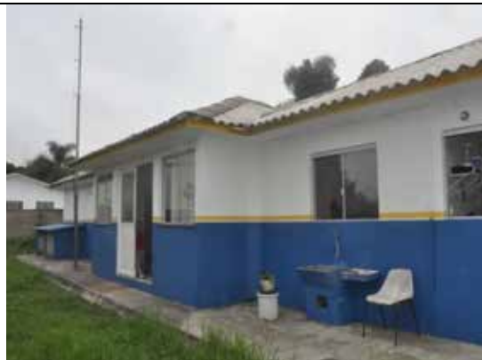
Foto 64: Vista Geral da Unidade de Saúde Malhada, uma das unidades de saúde que garantem o atendimento ao Bairro Roça Velha, São José dos Pinhais – PR.
