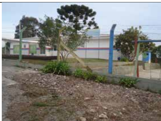
Foto 56: Prédio da EMEF Carlos Gomes, do bairro Roça Velha, responsável pelo atendimento da demanda de ensino fundamental do bairro Córrego Fundo, São José dos Pinhais – PR.
