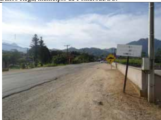
Foto 14: Aspecto geral da Rua Presidente Costa e Silva - Bairro Rega, município de Pomerode/SC.
