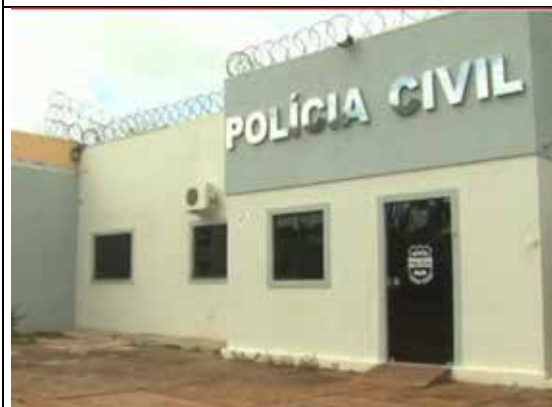
Foto 40: Prédio da Delegacia de Polícia Civil do Município de Tijucas do Sul, responsável pelo atendimento do Bairro Lagoa, Tijucas do Sul – PR.
