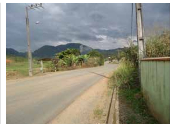
Foto 24: Aspecto geral da Estrada Francisco Greter – Bairro Braço do Ribeirão Cavallo, município de Jaraguá do Sul/SC.
