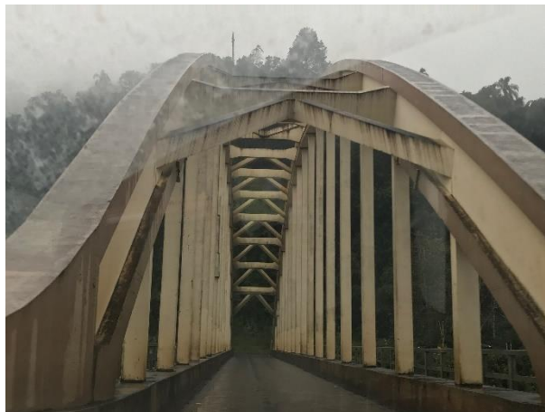
Foto 5.5.3-42 Ponte Manoel Ribas. União da Vitória (PR).
