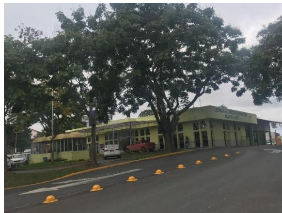
Foto 5.5.3-34: Terminal rodoviário. Mafra (SC).
