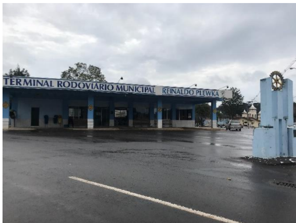
Foto 5.5.3-33: Terminal rodoviário. Cruz Machado (PR)
