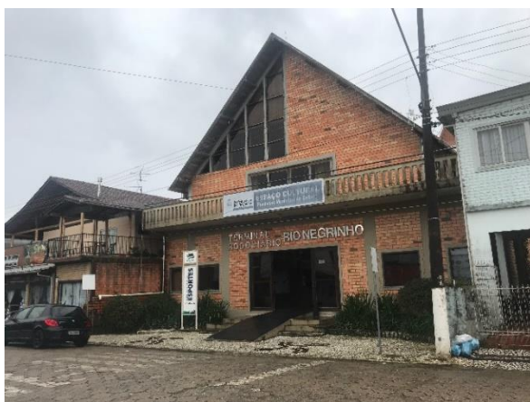
Foto 5.5.3-35: Terminal rodoviário. Rio Negrinho (SC).
