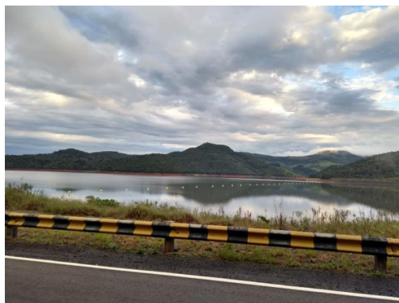
Foto 5.3 45: Vista do lago da Represa de Foz do Areia, a partir da barragem. Coord.: 22J 433315.38 m E 7123651.44 m S.
