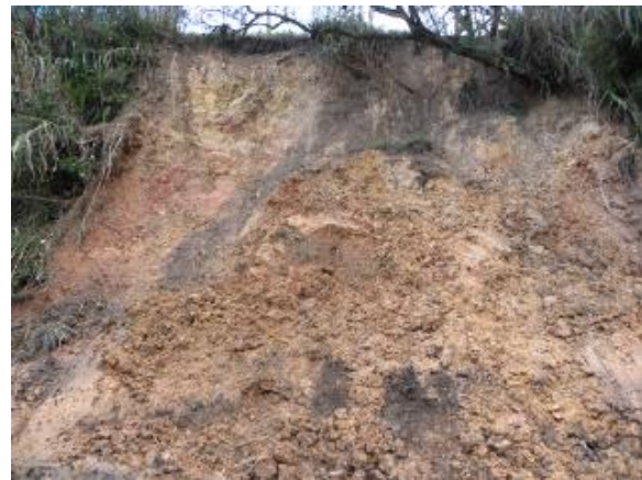
Foto 5.3-73: Caracterização de escorregamento em talude de corte, mobilizando volume de cambissolo háplico, posicionado sobre rochas pelíticas da Formação Taciba Indiviso, com volume da ordem de 6 m 3 , conforme observado em talude de corte subvertical na região de Boa Vista, município de Rio Negrinho/SC. Coord.: 22 J 640238 m E 7094408 m S.
