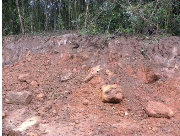
Foto 5.3-71: Detalhe de alteração de rochas basálticas, com característica heterogênea; conduzindo à formação de blocos e matacões em meio ao solo, gerando uma variação da condição de escavabilidade local e risco de instabilizações localizadas. Registro em talude lateral a via de acesso, na região de Colônia Santa Helena, município de União da Vitória/PR. Coord.: 22 J 506384 m E 7128585 m S.
