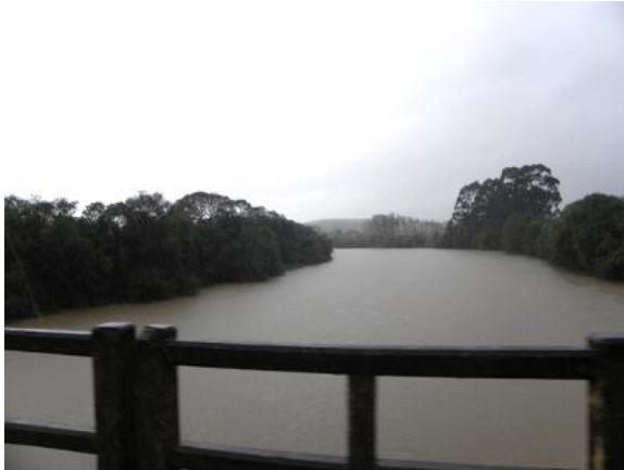
Foto 5.3-50: Definição da calha e das margens do rio Negro; feições que definem e caracterizam a unidade geomorfológica de Planícies e Terraços Fluviais conforme observado na área urbana de Três Barras/SC. Coord.: 22 J 566731 m E 7113876 m S.
