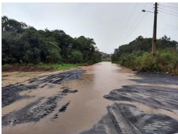
Foto 5.3 45: Área alagada próxima a drenagem contribuinte do Rio Negro, durante evento de precipitação. Registro no município de Três Barras - SC. Coord.: 22J 572173.02 m E 7112481.61 m S.
