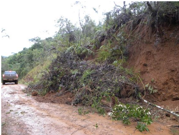
Foto 5.3-84: Detalhe do volume de material mobilizado em função de movimento de massa envolvendo solo superficial, vegetação e rocha basáltica alterada, com presença de blocos dispersos na matriz alterada, associada a talude de corte na lateral de via local, na região de Lajeado Feio, município de Pinhão/PR. Coord.: 22 J 443096 m E 7132056 m S.
