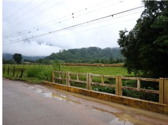
Foto 5.3-46: Planície no entorno do rio Itapocuzinho, área onde se depositam sedimentos detríticos de natureza colúvio-aluvionares típicos desta unidade geológica, evidenciados na região de Santa Luzia, zona rural de Schroeder/SC. Coord.: 22 J 686799 m E 7084223 m S.
