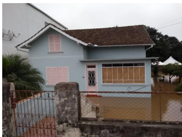
Foto 5.3 45: Casa atingida pela inundação do Rio Negrinho durante a campanha de campo. Coord.: 22J 647627.40 m E 7096258.88 m S.
