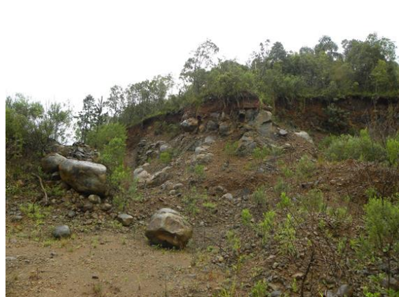
Foto 5.3-85: Blocos e matacões subarredondados, derivados da alteração de rochas basálticas, recobertas por pequena camada de nitossolo, instabilizadas em função do corte executado no terreno; condição que prejudica a escavação e a execução de serviços no local, região de Pinhalzinho, município de Pinhão/PR. Coord.: 22 J 456965 m E 7137861 m S.
