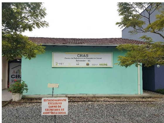
Foto 72: Centro de Referência de Assistência Social de Schroeder. 25/04/2019. UTM 22J 691815/7077060.
