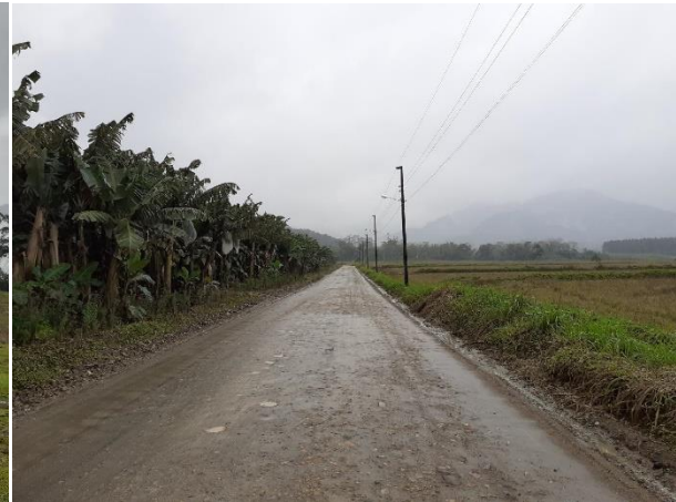
Foto 5.5.4-109: Condições da estrada em Rancho Bom.
