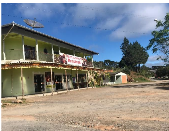
Foto 5.5.4-37: Vista de estabelecimento comercial no Distrito de Bela Vista do Sul
