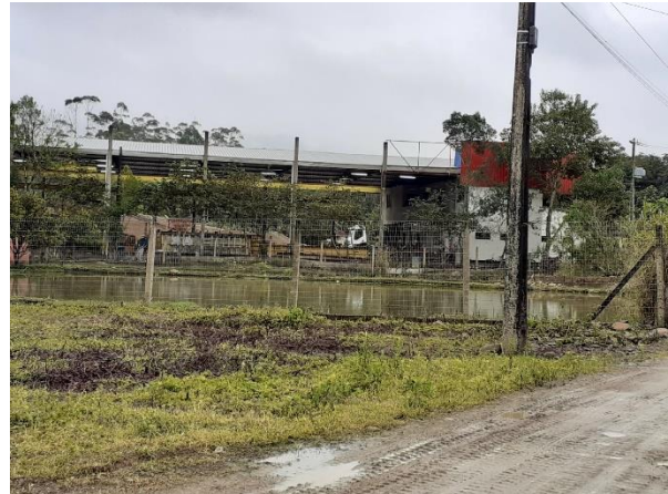
Foto 5.5.4-87: Benfeitorias em Schroeder III.
