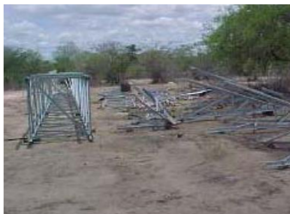
Fotos I14 e I15 – Processo de montagem das torres.
