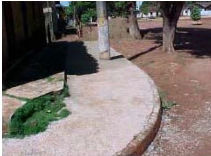
Foto I9 – Disposição apropriada de restos de concreto.
