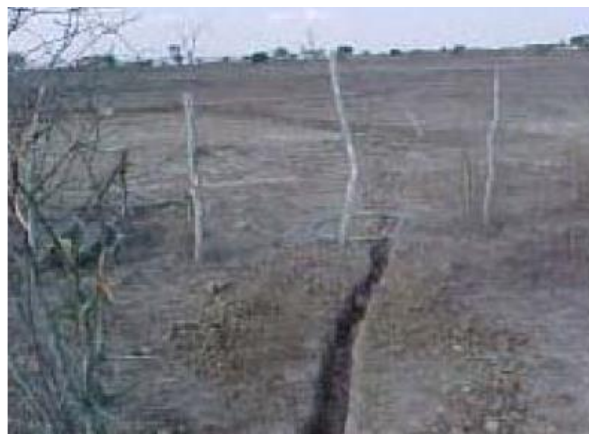
Foto I21 – Vala para instalação de aterramento.
