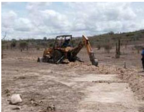
Foto I20 – Uso de retroscavadeira para instalação de aterramento.
