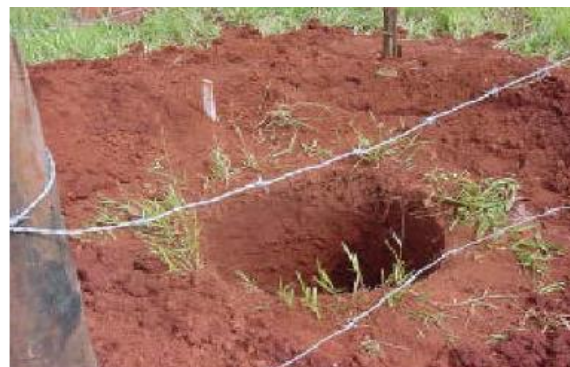
Foto I13 – Detalhe da escavação com broca no mastro central.
