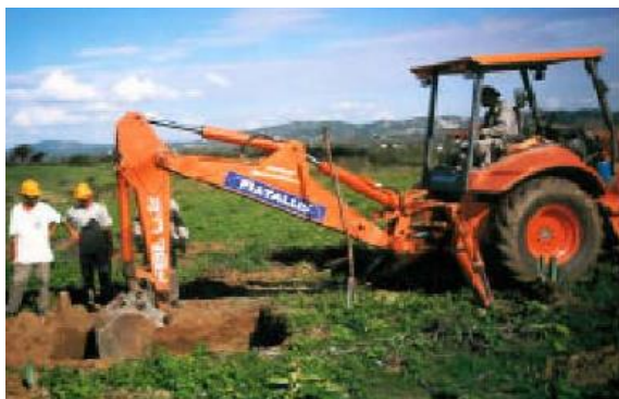
Foto I12 – Escavação de fundação de uma torre.
