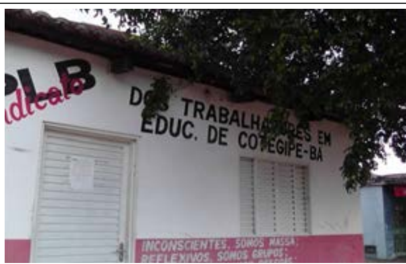
Foto 5.4.2-12 – Sede do Sindicato dos Trabalhadores de Educação do município de Cotegipe (BA).
