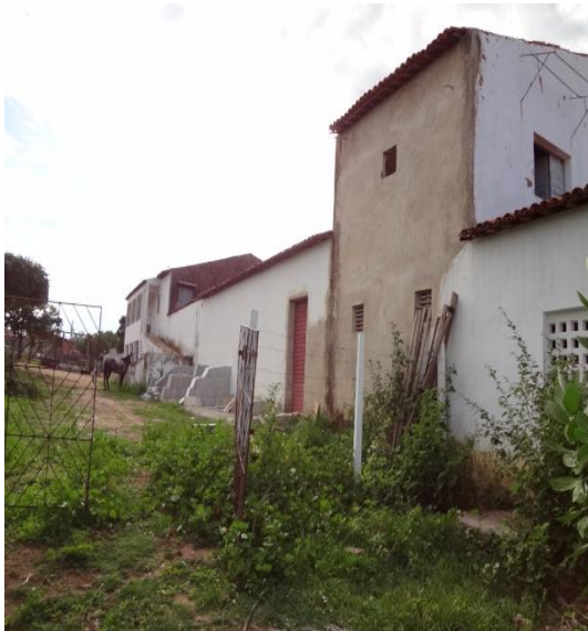
Figura 3 – Área para Canteiro de Obra "Cajazeiras 02" (Fonte: ATE XVII, 2013).
