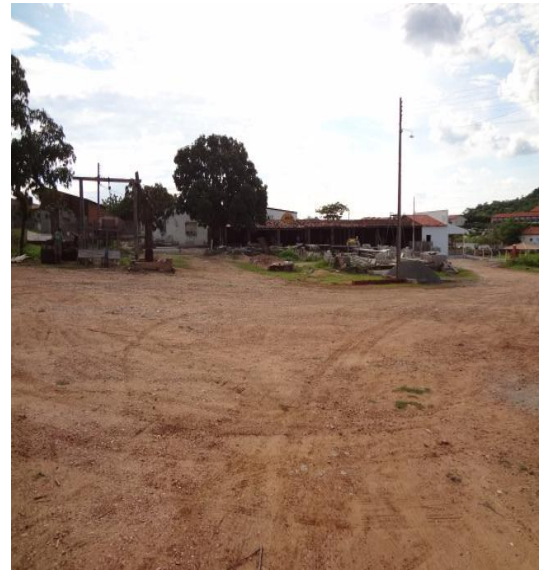
Figura 4 - Área para Canteiro de Obra "Cajazeiras 02" (Fonte: ATE XVII, 2013).
