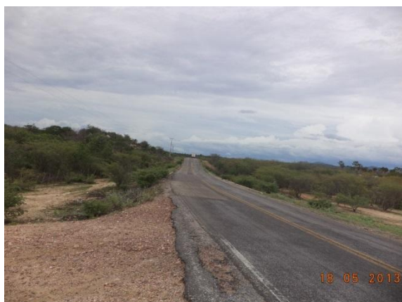
Figura 7.4-39 - Trecho da RN-233 (Coordenadas: 05o46'01,6"S/ 37o05'57,1"W) (Fonte: Bourscheid, maio/2013).
