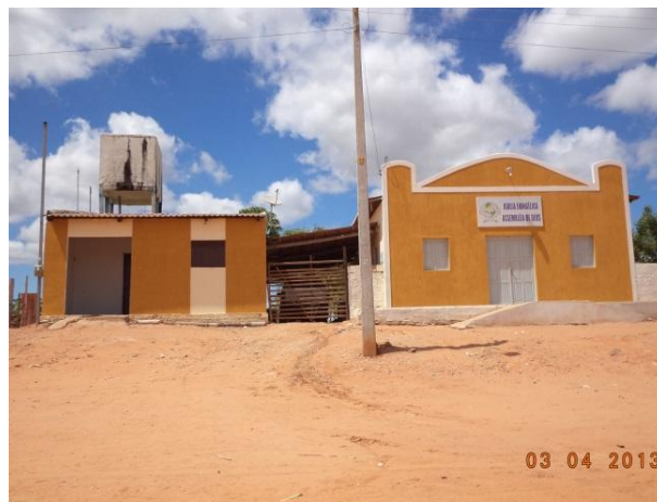
Figura 7.4-73 – Igreja Evangélica da Comunidade Bela Vista do Piató (Coordenadas: S05°31'21.9"/W037°00'16.6") (Fonte: Bourscheid, abril/2013).
