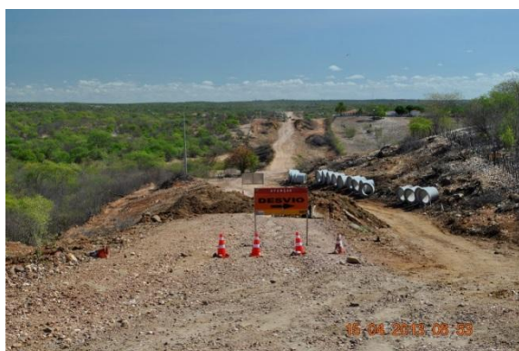
Figura 7.4-37 - Trecho da BR-110 no município de Augusto Severo (Campo Grande) / RN (Coordenadas: 05°49'09,05"S/ 37°18'04,96 W) (Fonte: Bourscheid, abril/2013).
