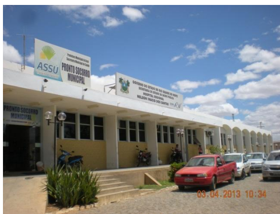
Figura 7.4-14 – Hospital Regional Nelson Inácio dos santos, Assú – RN (Coordenadas: S 05°35'00.6"/ W 036°54'52.0'') (Fonte: Bourscheid, abril/2013).
