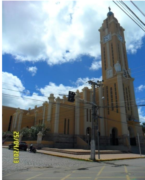
Figura 7.4-103 - Catedral de N. S. da Piedade, Cajazeiras (Coordenadas: S 06° 53' 14"/ W 38° 33' 27.8") (Fonte: Bourscheid, abril/2013).
