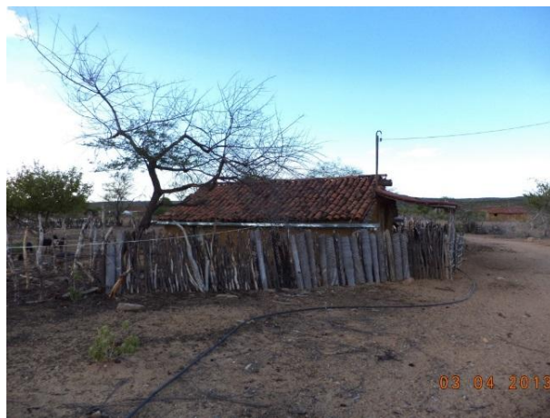
Figura 7.4-64 - Casa de taipa, em Caboclos (Coordenadas: S05°44'01.1"/W037°03'32.9") (Fonte: Bourscheid, abril/2013).
