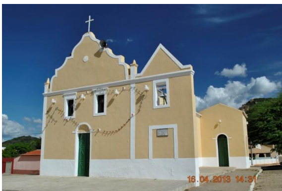
Figura 7.4-113 - Imóvel na Rua Teodoro Benjamim – Igreja Matriz, de 1887, João Dias (Coordenadas: S 06° 16' 32.7" / W 37° 47' 46.4") (Fonte: Bourscheid, abril/2013).
