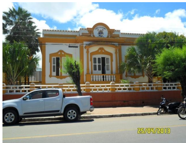
Figura 7.4-104 - Palácio Episcopal, Cajazeiras (Coordenadas: S 06° 53' 14"/ W 38° 33' 27.8") (Fonte: Bourscheid, abril/2013).
