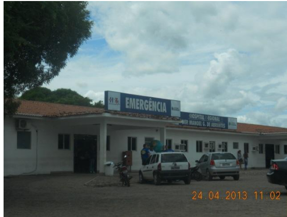
Figura 7.4-15 - Hospital Regional Dep. Manoel Gonçalves de Abrantes – Sousa/PB (Coordenadas: S 06°45'52.4''/ W 038°13'14.8'') (Fonte: Bourscheid, abril/2013).
