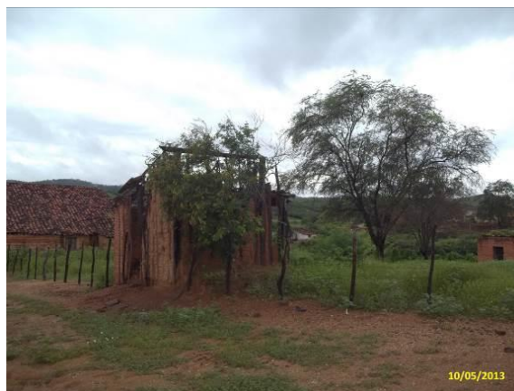
Figura 7.4-159 - Propriedades próximo ao ponto 06 (Coordenada: 0529556/9216230) (Fonte: Bourscheid, maio/2013).
