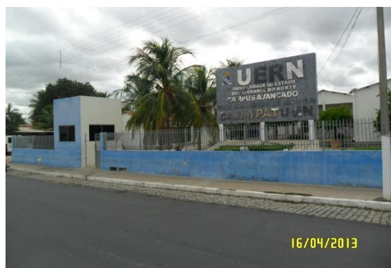
Figura 7.4-26 - Universidade Estadual do Rio Grande do Norte – UERN, Núcleo Patu – RN (Coordenadas: S 06°05'59.4"/W 37°38'14.3") (Fonte: Bourscheid, abril/2013).
