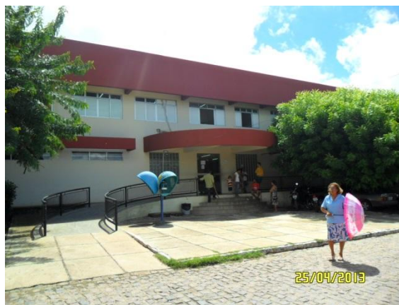
Figura 7.4-16 – Hospital Regional de Cajazeiras, Cajazeiras – PB (Coordenadas: S 06°53'08.9''/ W 038°33'17.4'') (Fonte: Bourscheid, abril/2013).
