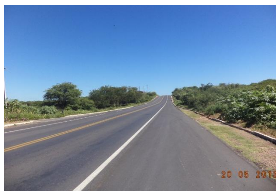
Figura 7.4-38 - Trecho da BR-230 no Município de Cajazeiras/PB (Fonte: Bourscheid, maio/2013).
