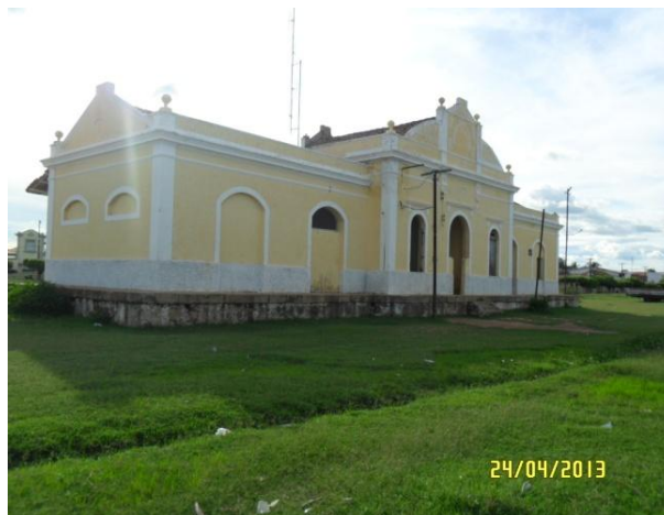
Figura 7.4-105 - Estação Ferroviária, São João do Rio do Peixe (Coordenadas: S 06° 43' 47.7" / W 38° 26' 58.7') (Fonte: Bourscheid, abril/2013).
