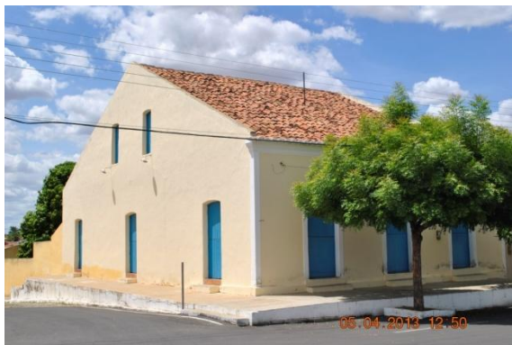
Figura 7.4-111 - Edifício na Rua João Gualberto, Campo Grande (Coordenadas: S 05° 51' 49.8" / W 37° 18' 29.9") (Fonte: Bourscheid, abril/2013).
