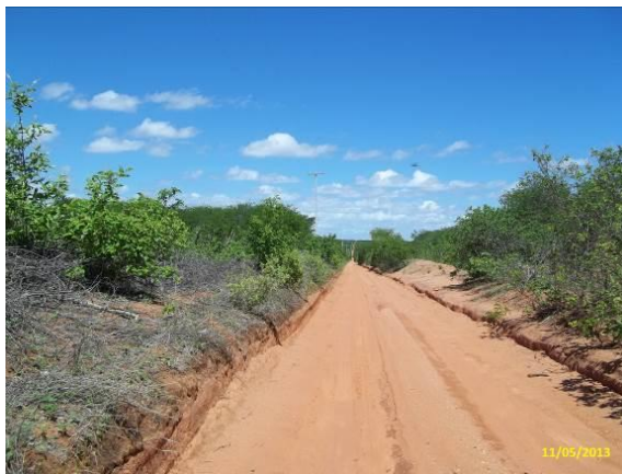
Figura 7.4-139 - Estrada de acesso nas direções paralelas e perpendiculares ao ponto 01. (Coordenada: 0717345 - 9378465) (Fonte: Bourscheid, maio/2013).
