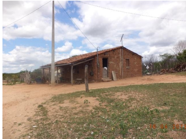
Figura 7.4-78 - Casa de agricultor em Lagoa Rasa (Coordenadas: S06°18'50.6"/W037°39'16.6") (Fonte: Bourscheid, abril/2013).
