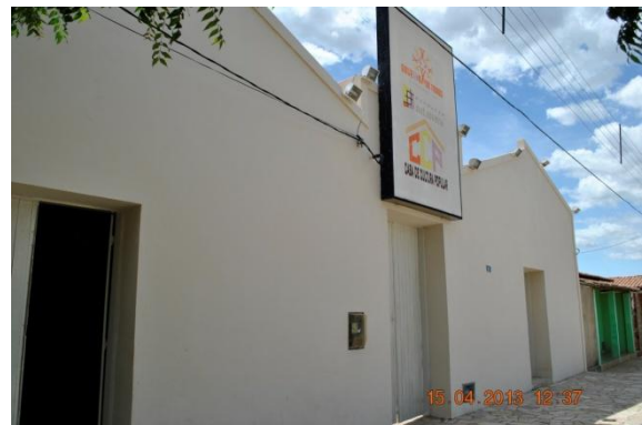
Figura 7.4-112 - Prédio Vaporzão, Janduís (Coordenadas: S 06° 00' 48.4" / W 37° 24' 26.3") (Fonte: Bourscheid, abril/2013).
