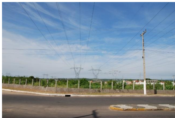
Figura 7.4-59 – Município de Milagres/CE e a coexistência com as Linhas de Transmissão (Fonte: Bourscheid, maio/2013).
