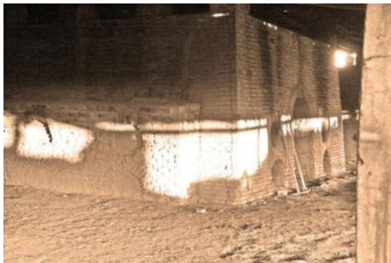
Figura 7.3-228. Olaria abandonada que serve de abrigo para espécies da quiropterofauna na área A2.
