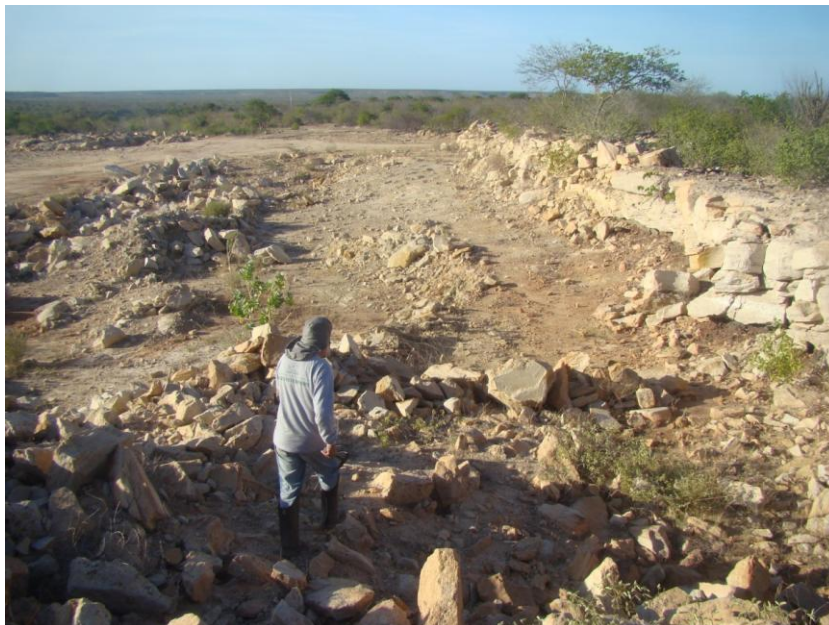
Figura 7.2-122 - Extração de Material de Rochas no ponto ATE 06 (Fonte: Bourscheid, abril/2013).
