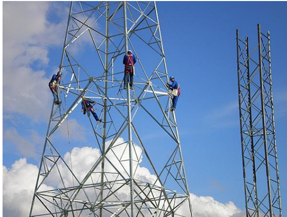
Figura 4.6-3 - Montagem de Torres Autoportantes (Fonte: Eletrosul, 2005).
