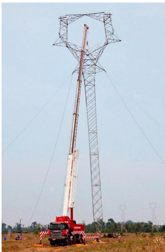
Figura 4.6-2 - Içamento de torres do tipo estaiada (Fonte: Eletrosul, 2005).
