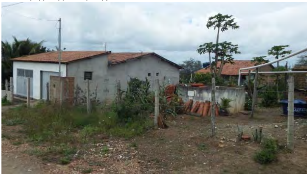
Figura 193. Cisterna para captação de água. Sítio Estreito.
