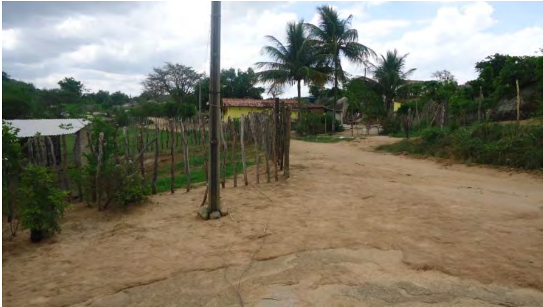
Figura 199. Vista do acesso, padrão construtivo e sistema de distribuição de energia.
