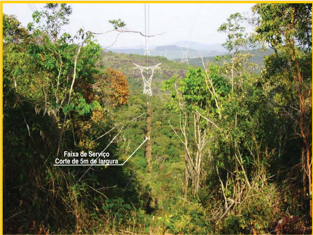
Exemplo da supressão de vegetação necessária para passar os cabos da LT
