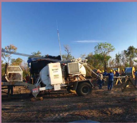
Equipamento para lançamento de cabos condutores
