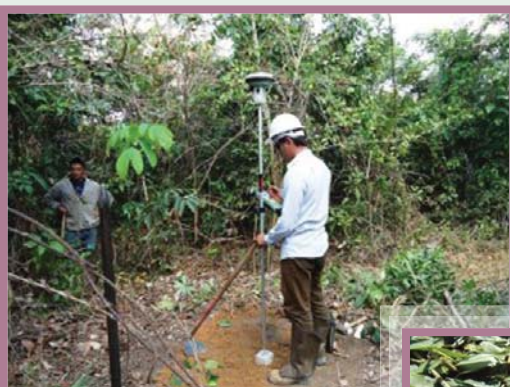
Alinhamento topográfico da LT
