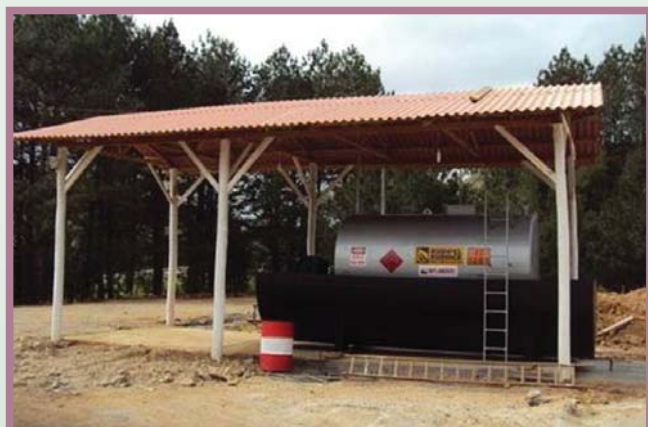
Exemplo de correto armazenamento de combustível nos canteiros de obra
