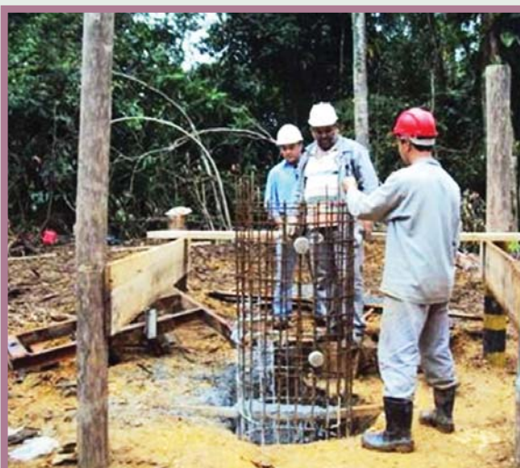
Exemplo de ferragem e concretagem de base de torre
