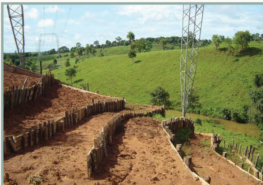
Banquetas preparadas para receber a revegetação, necessária para fins de estabilização de processo erosivo
