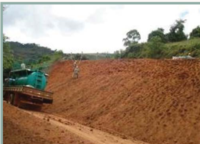
Revegetação de talude com o plantio de grama, para prevenir e controlar processos erosivos e recuperar a área degradada pelas obras, em estrada de acesso
