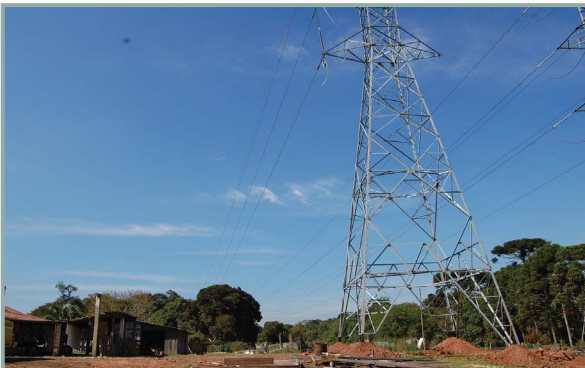
Exmplo de interferência da LT com ocupação humana. Essa benfeitoria, próxima, foi removida após as devidas indenizações para a implantação da faixa de servidão da LT
