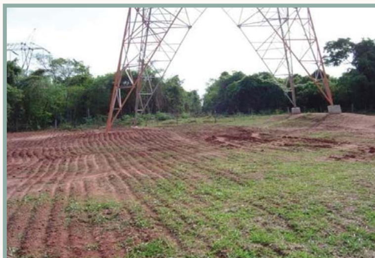
Revegetação, em nível, com gramínea adaptada, de área correspondente à base de torre e ao seu entorno imediato, visando à prevenção contra processos erosivos
