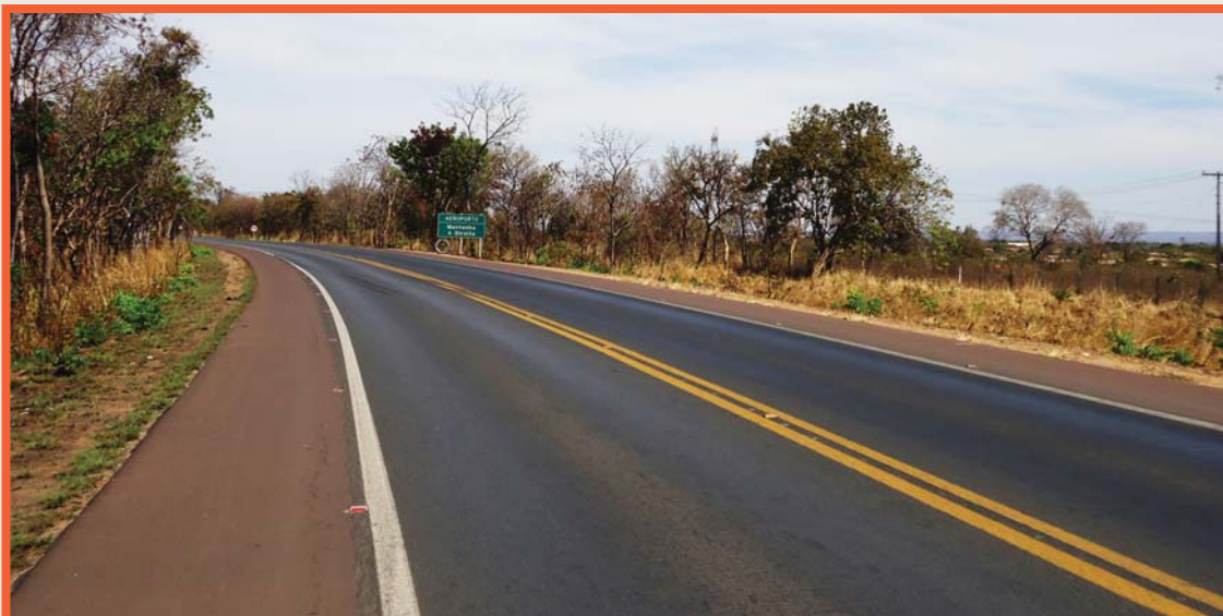
Rodovia BR-365. Município: Pirapora (MG)
