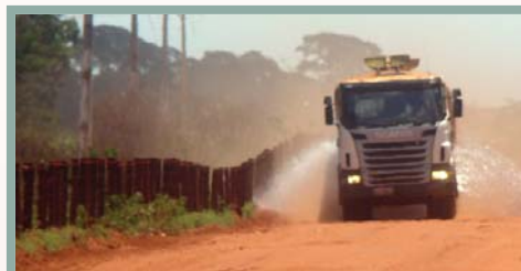
Exemplo de molhagem (umectação) do solo, técnica aplicada para baixar a poeira nos acessos aos locais de obra
