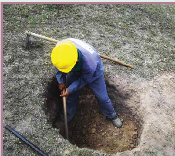
Exemplo de escavação para alguns tipos de torre
