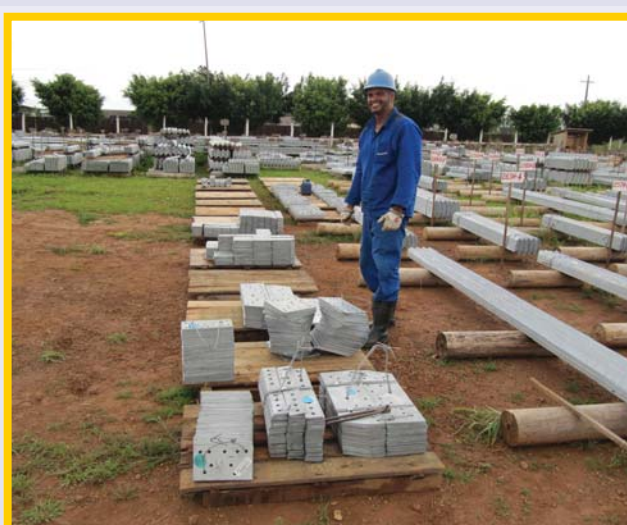
Pátio de um Canteiro de Obras
