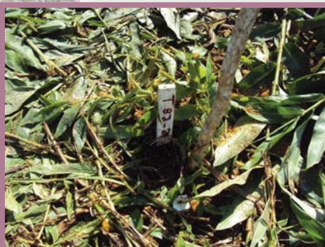
Piquete (indicação do local do centro das torres)
