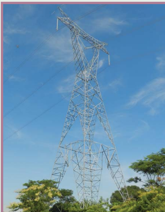
Exemplo de torre autoportante
