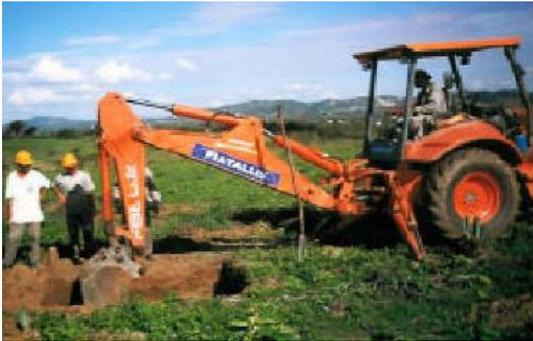
**Foto 16** – Escavação de fundação de uma torre.
