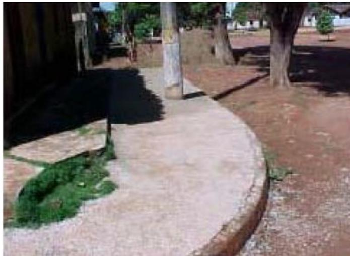
**Foto 13** – Disposição apropriada de restos de concreto.
