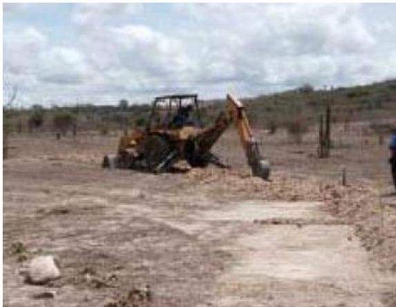
**Foto 24** – Uso de retroescavadeira para instalação de aterramento.
