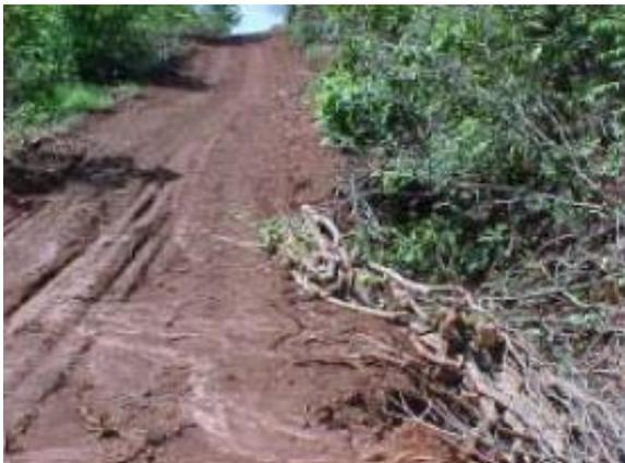
**Foto 7** – Necessidade de colocar contêntes laterais no corte executado para construir acesso.
