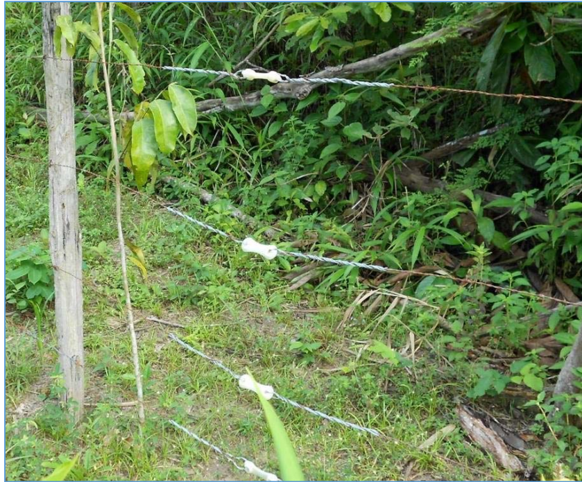
Figura 5.2.4-2 – Exemplo de cerca seccionada e aterrada. Fonte: Biodinâmica, 2017
