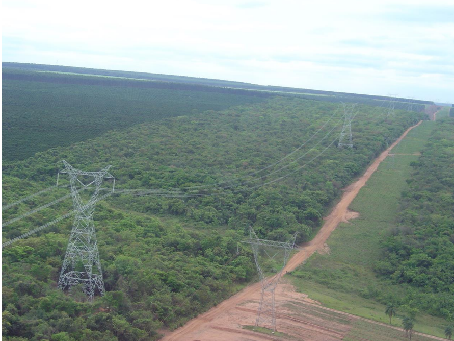
Figura 3-15 – Nota-se que as torres da LT mais recente (à esquerda), foram alteadas, preservando a vegetação nativa existente.
