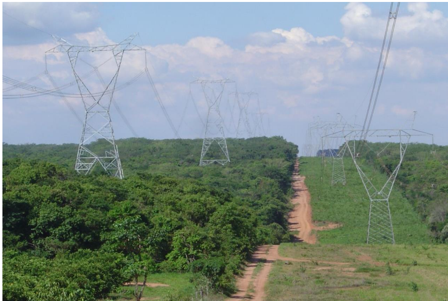
Figura 3-14 – Nota-se que as torres da LT mais recente (à esquerda) foram alteadas, preservando a vegetação nativa existente.
