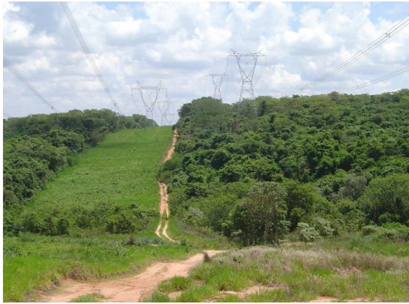
Figura 3-13 – Nota-se que as torres da LT mais recente (à direita), foram alteadas, preservando a vegetação nativa existente.
