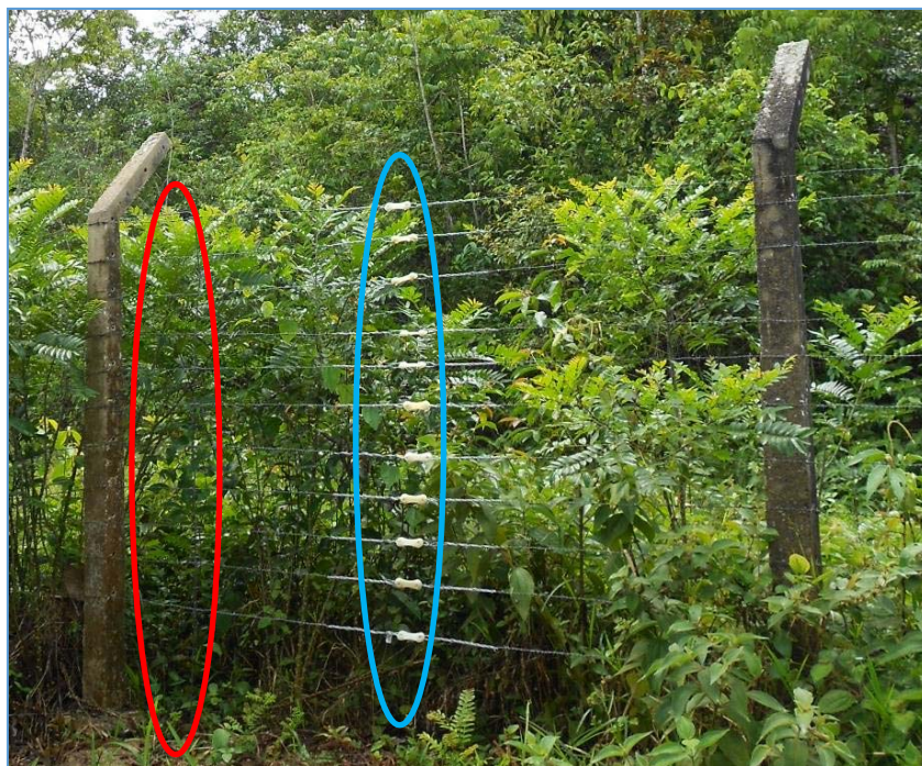
Figura 5.2.4-3 – Exemplo de cerca seccionada e aterrada. Destacam-se, na cor azul, o seccionamento da cerca e, na cor vermelha, o aterramento. Fonte: Biodinâmica, 2017
