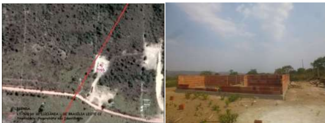
Figura 472 - À esquerda: Localização da propriedade 65 - Circuito 2. À direita: Área em construção
