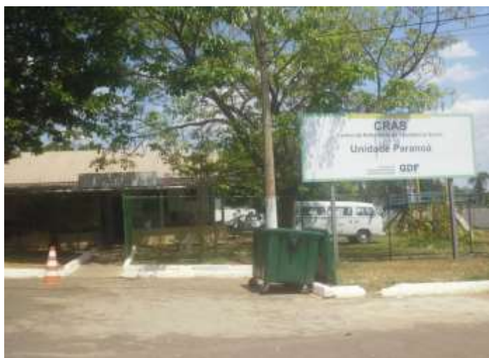
Figura 214 - Centro de Referência de Assistência Social da Regional Administrativa de Paranoá – DF
