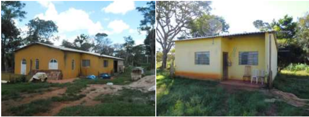
Figura 392 - À esquerda: Sede da propriedade. À direita: Casa do funcionário
