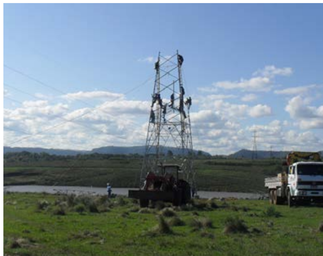
Montagem da Torre. Fonte: Abengoa, 2014
