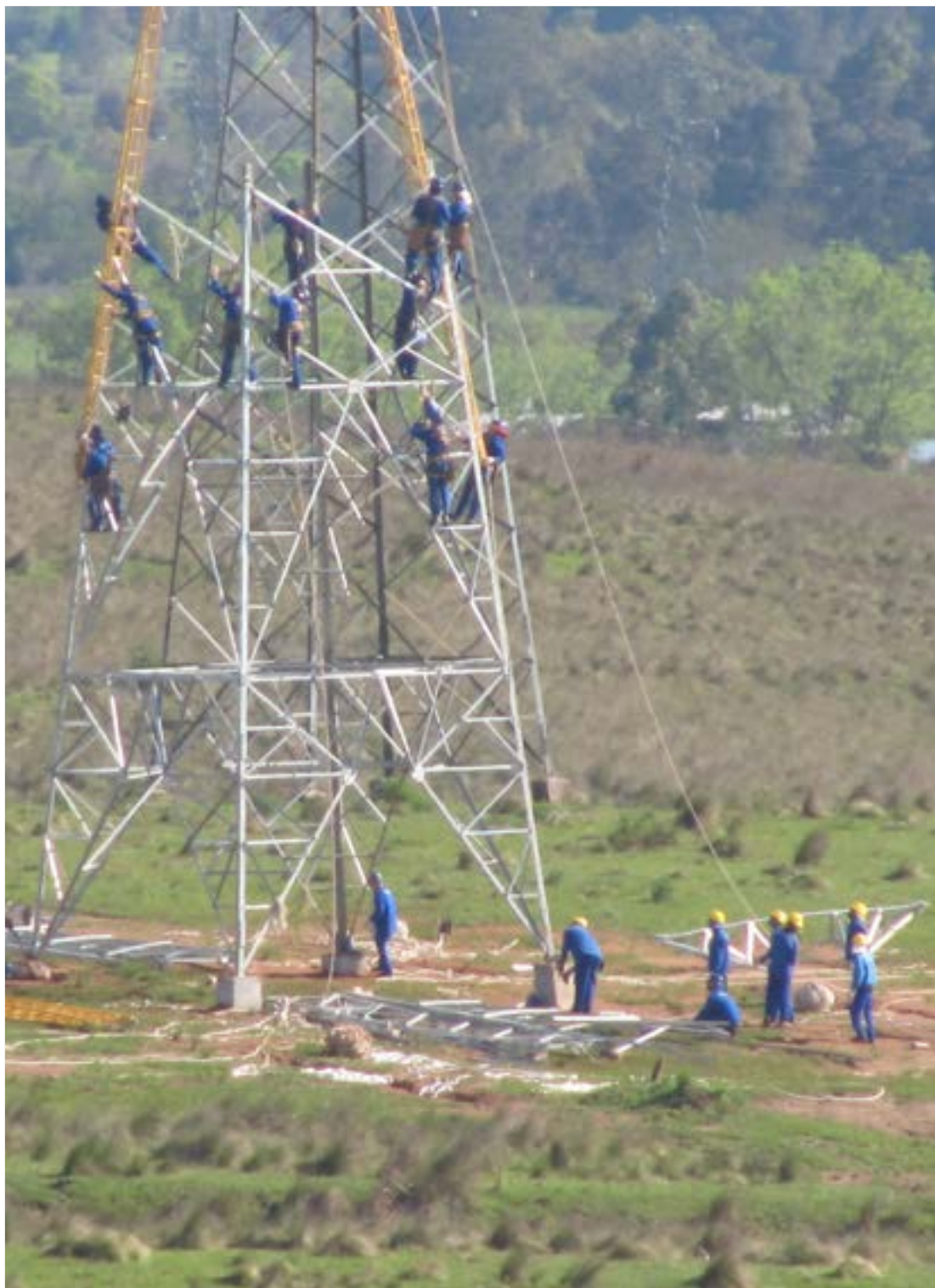
Montagem da Torre. Fonte: Abengoa, 2014.
