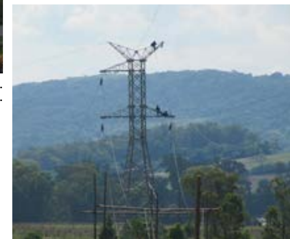
Lançamento de Cabos. Fonte: Abengoa, 2014.
