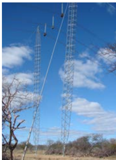
Torre Estaiada. Fonte: Abengoa, 2014.
