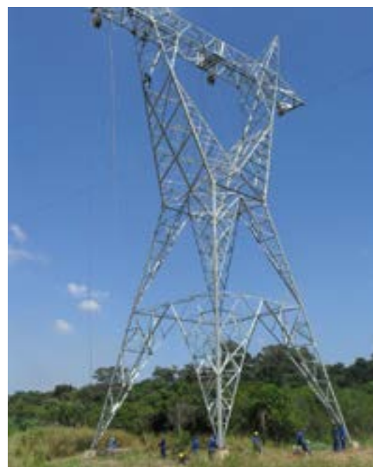
Torre Autoportante. Fonte: Abengoa, 2014.
