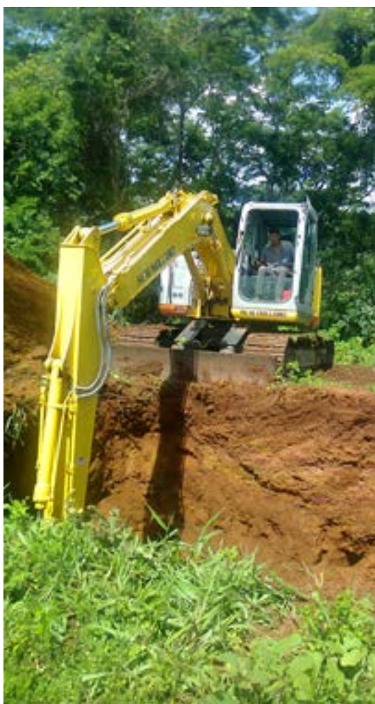
Escavação para construção das fundações das torres. Fonte: Abengoa, 2014.
