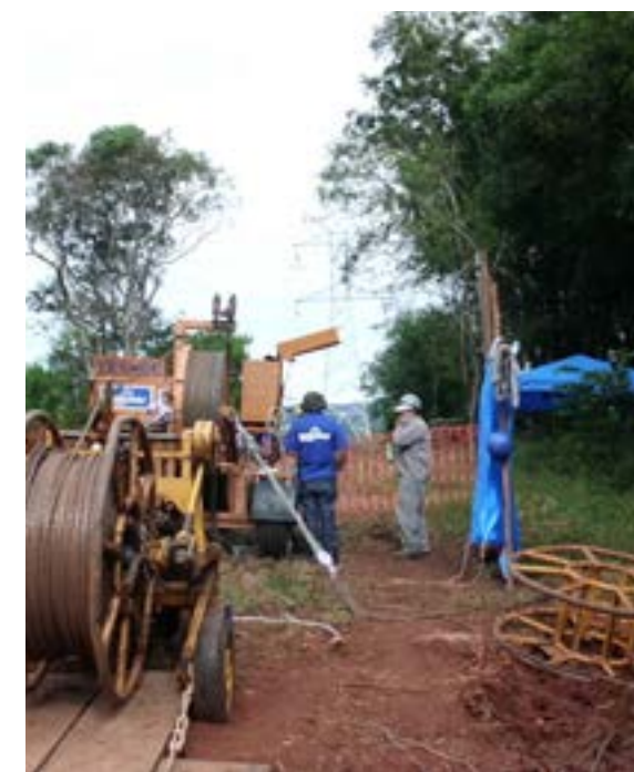
Lançamento de Cabos. Fonte: Abengoa, 2014
