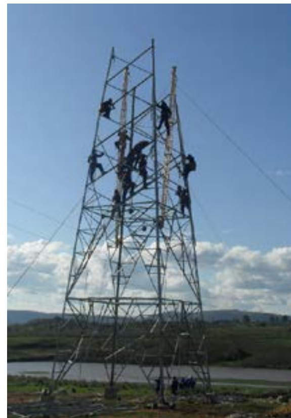
Montagem de torre autoportante. Fonte: Abengoa, 2014.
