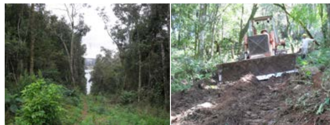
Faixa de serviço, após o desmatamento. Fonte: Abengoa, 2014.
