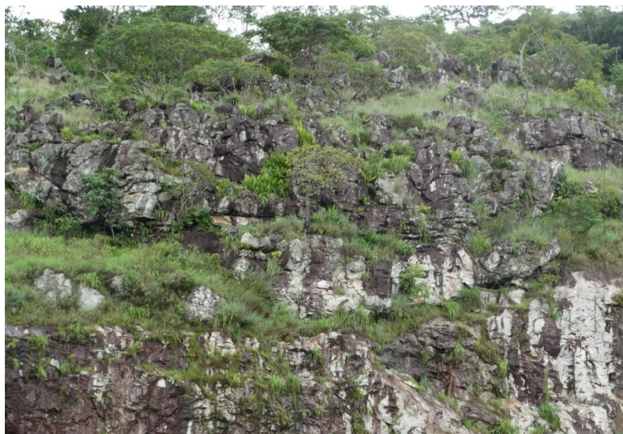
Figura 47 – Área passível a queda de blocos.
