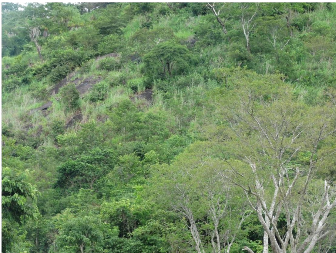
Figura 73 - Risco de queda de blocos.
