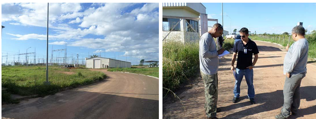
Figura 17 - Vista da SE Itacaiúnas e conversa com responsáveis pela operação.
