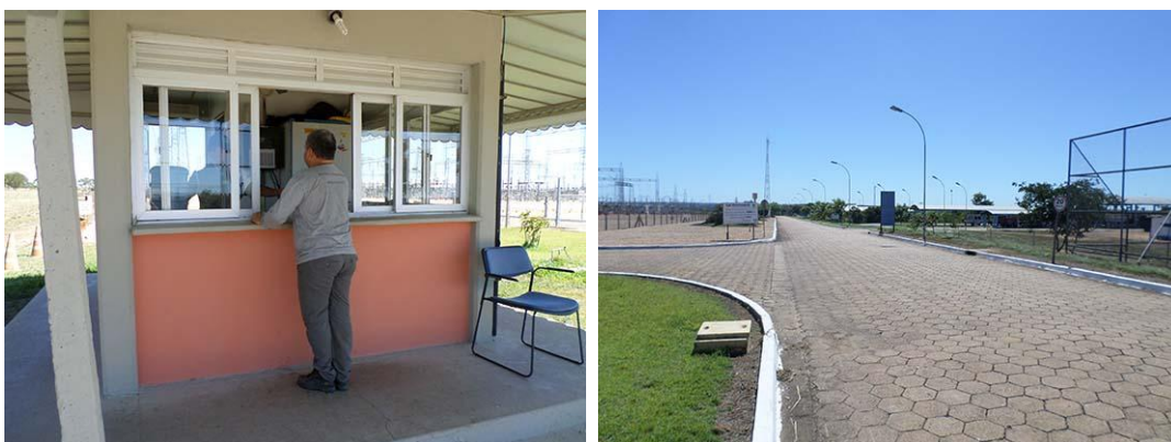
Figura 26 - Vista da portaria no momento da conversa e área interna da subestação.
