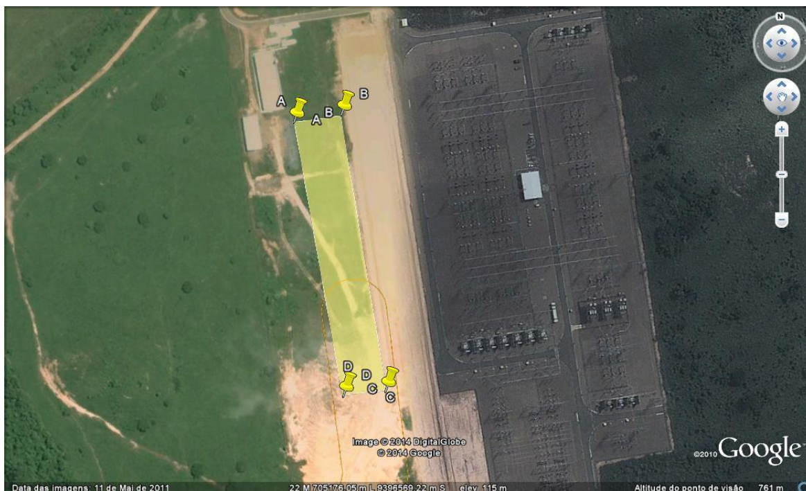
Figura 16 - Imagem de satélite com a localização da SE Itacaiúnas já construída, e em amarelo a área a ser ampliada.
