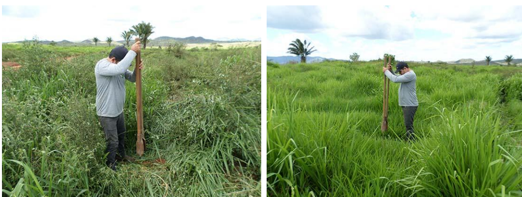
Figura 22 - Abertura de tradagens na área da futura subestação Parauapebas.
