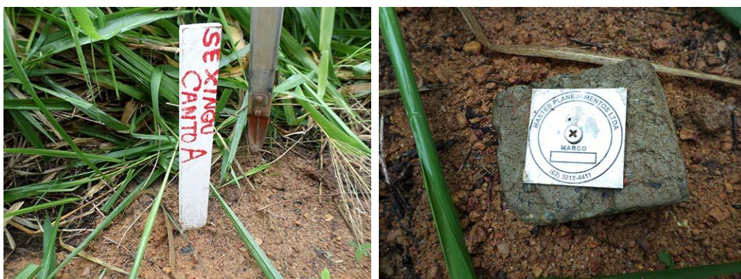
Figura 15 - Estaca e marco geodésico do canto A da futura subestação.
