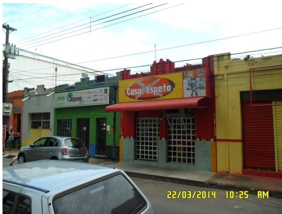
Figura 4.1-39 - Prédios da Rua Barão do Rio Branco (coordenadas: S 05°21'10.5"/ W 049°08'15.5").
