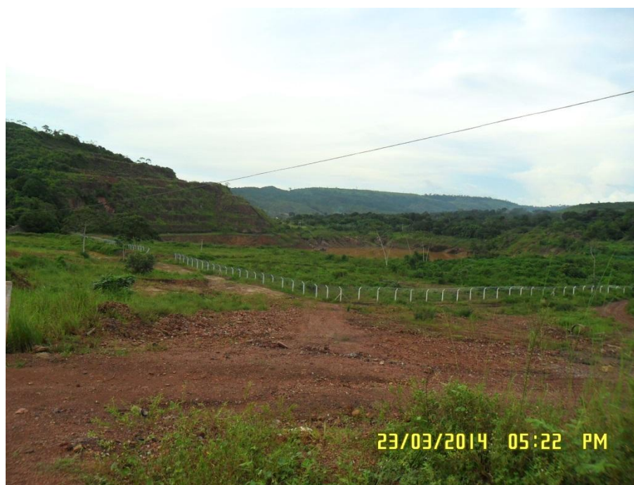
Figura 4.1-63 – Vista geral da área de exploração em Serra Pelada (coordenadas: S 05°56'54.9" W 049°39'53.8").
