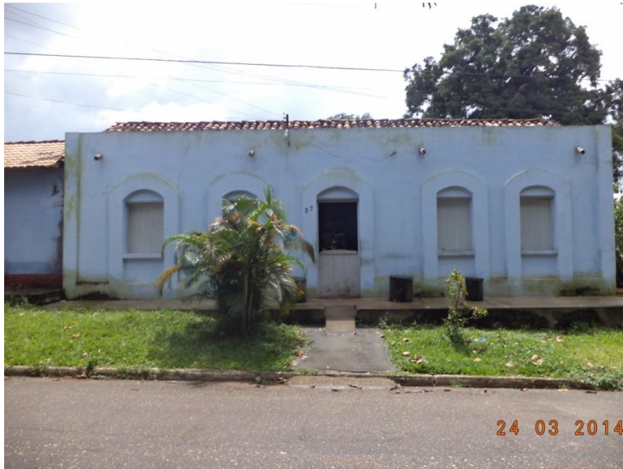
Figura 4.1-12 - Uma das primeiras casas erguidas em Itupiranga (coordenadas: S 05° 01' 58.6'' W 049° 19' 28.6'').
