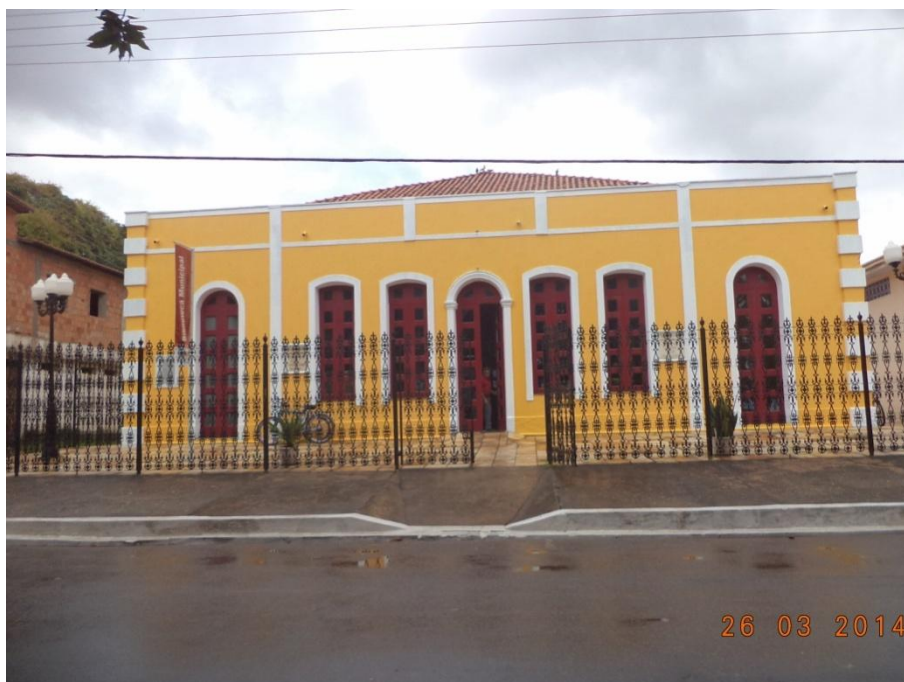
Figura 4.1-22 - Biblioteca Pública Municipal, antigo mercado público de Marabá ((coordenadas: S 05° 21' 00.3" W 049° 08' 20.4").
