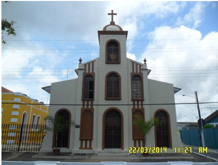
Figura 4.1-21 – A primeira edificação da Igreja de São Félix de Valois data de 1922, mas com a grande enchente de 1926 que atingiu o município, a mesma foi reconstruída no mesmo ano e é mantida até os dias de hoje (coordenadas: S 05° 21' 00.3" W 049° 08' 20.4").
