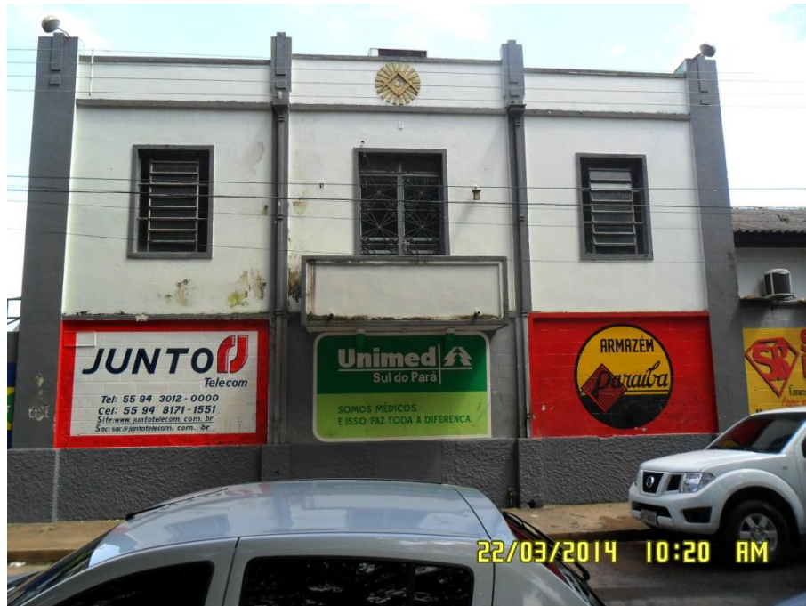
Figura 4.1-38 - Loja Maçônica (coordenadas: S 05° 21' 00.3" W 049° 08' 13.2").
