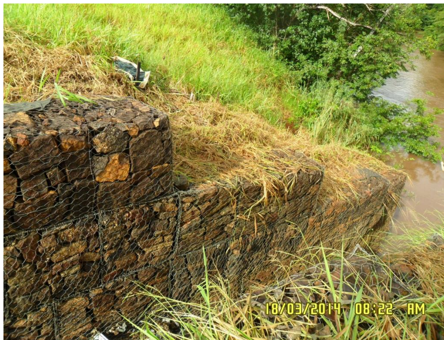
Figura 4.1-123 - Represa na Margem do Rio Providência. (coordenadas: S 09° 31' 30.0" W 048° 35' 36.8").
