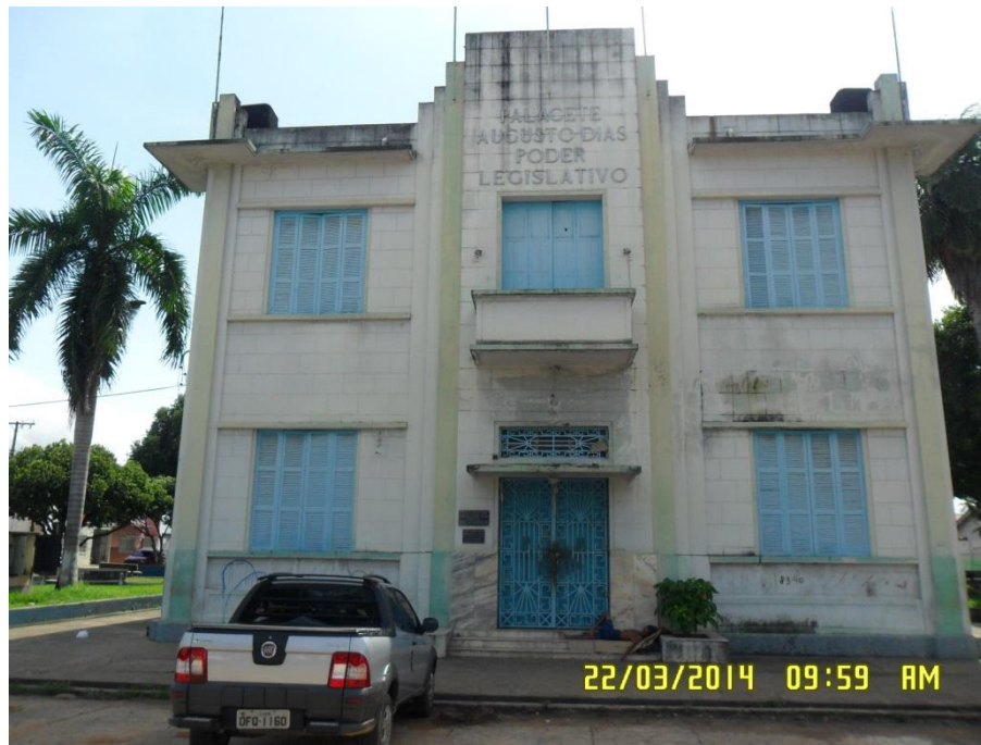
Figura 4.1-32 - Palacete Augusto Dias (coordenadas: S 05° 20' 57.0" W 049° 08' 08.5").
