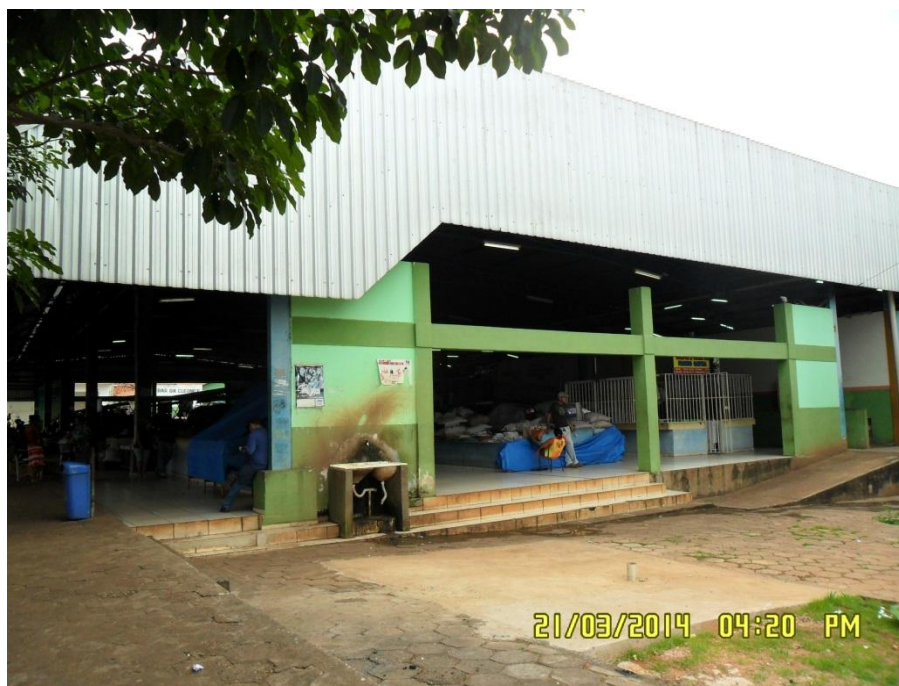
Figura 4.1-70 - Prédio do Mercado Público de Araguaína.
