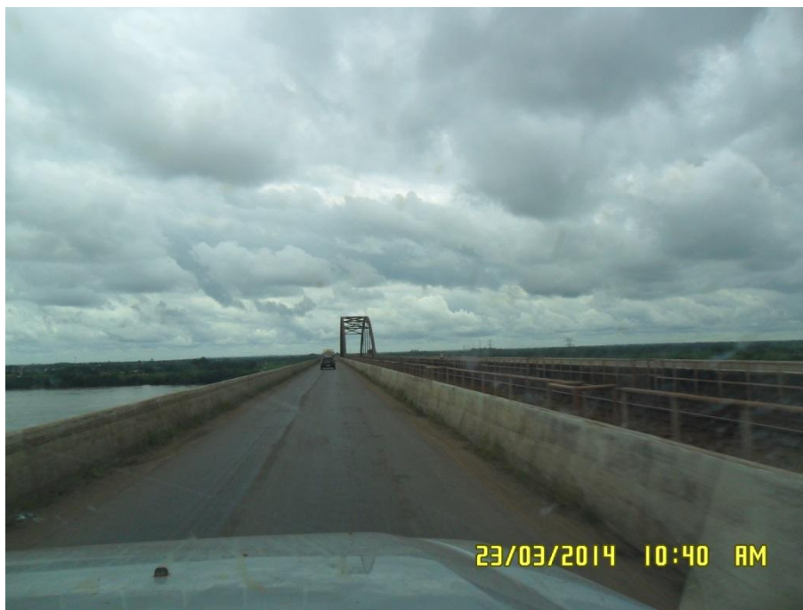
Figura 4.1-48 - Ponte construída pela Empresa Vale do Rio Doce, entre as pistas encontra-se a linha férrea (coordenadas: S 05° 18' 07.8" W 049° 04' 20.7").
