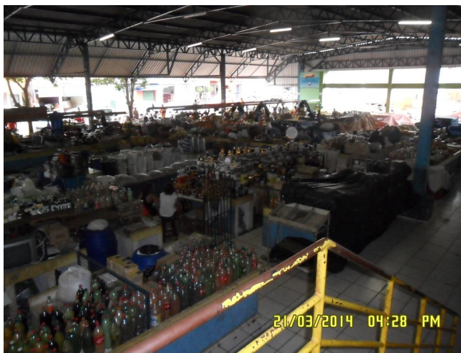
Figura 4.1-73 - Vista de parte do Prédio do Mercado Público de Araguaína.
