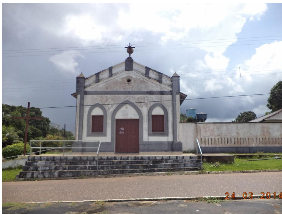
Figura 4.1-13 - Igreja de Santo Antônio edificada em 1940 (coordenadas: S 05° 01' 58.6'' W 049° 19' 28.6'').
