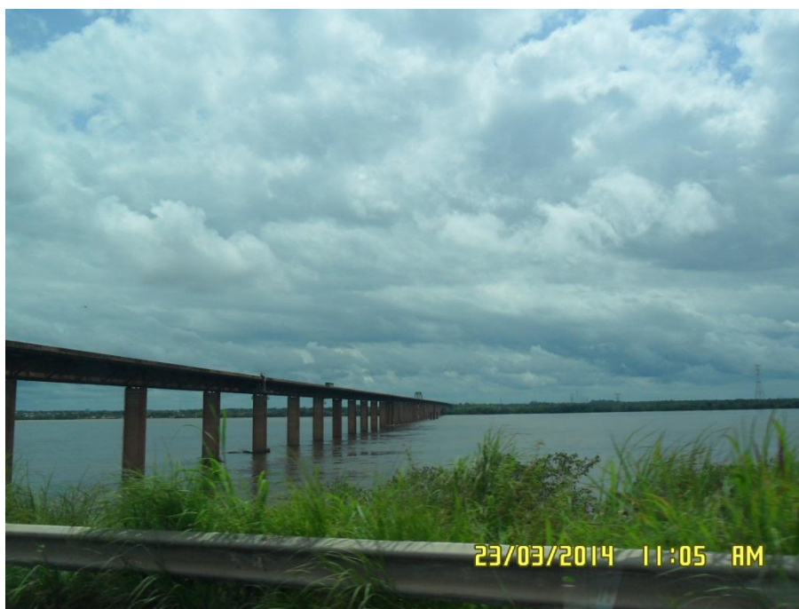
Figura 4.1-50 - Ponte construída pela Empresa Vale do Rio Doce. (coordenadas: S 05° 18' 07.8'' W 049° 04' 20.7'').
