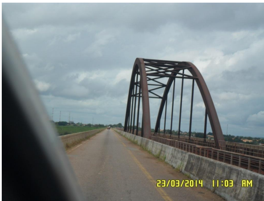
Figura 4.1-49 - Ponte construída pela Empresa Vale do Rio Doce (coordenadas: S 05° 18' 07.8'' W 049° 04' 20.7'').
