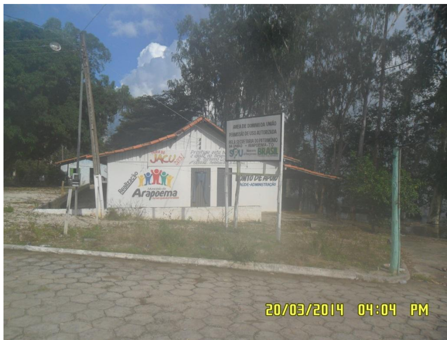
Figura 4.1-79 - Ponto de Apoio da Prefeitura de Arapoema na Praia do Jacu (coordenadas: S 07° 42' 43.4" W 049° 15' 52.8").
