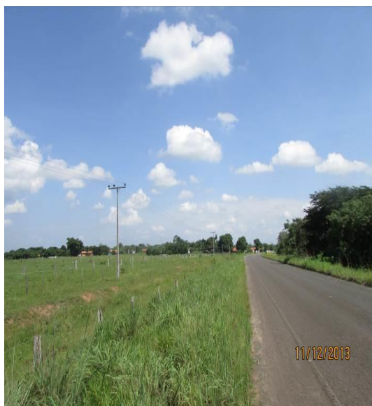
Figura 9 – Vista de entrada Área em análise: Bernardo Sayão – Área 01
