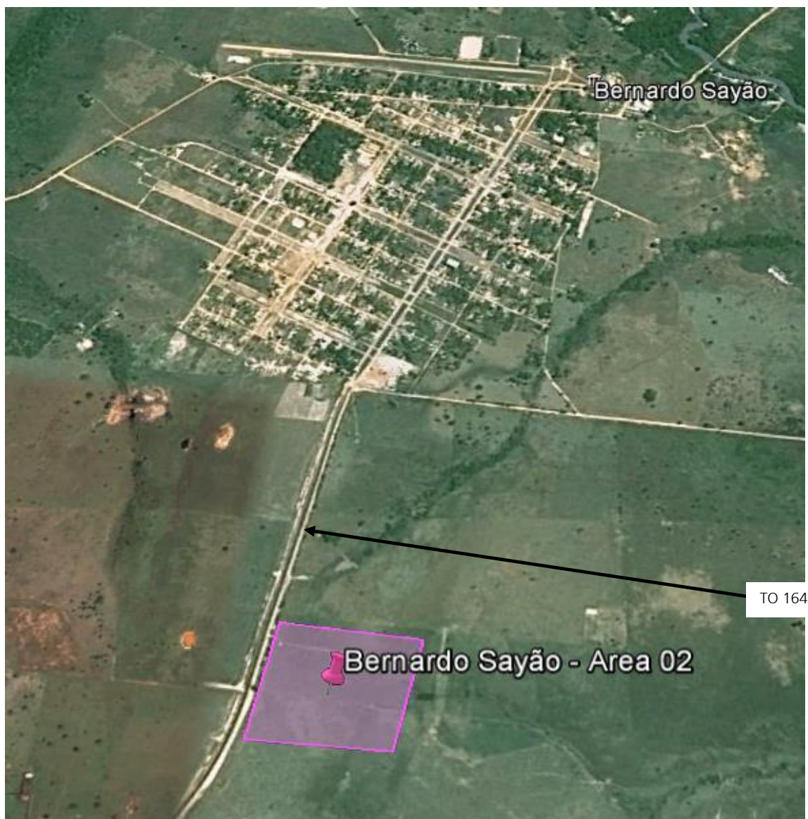
Figura 6 - Acesso ao canteiro de Obra “Bernardo Sayão – Área 02”
