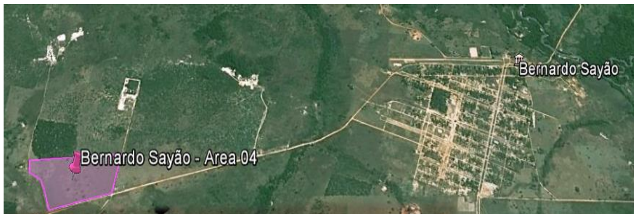
Figura 4 - Localização do canteiro de Obra "Bernardo Sayão – Área 04".
