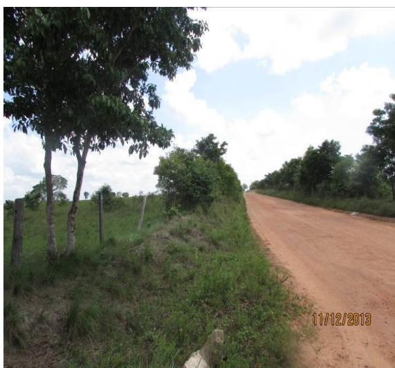
Figura 15 – Vista de entrada Área em análise: Bernardo Sayão – Área 04
