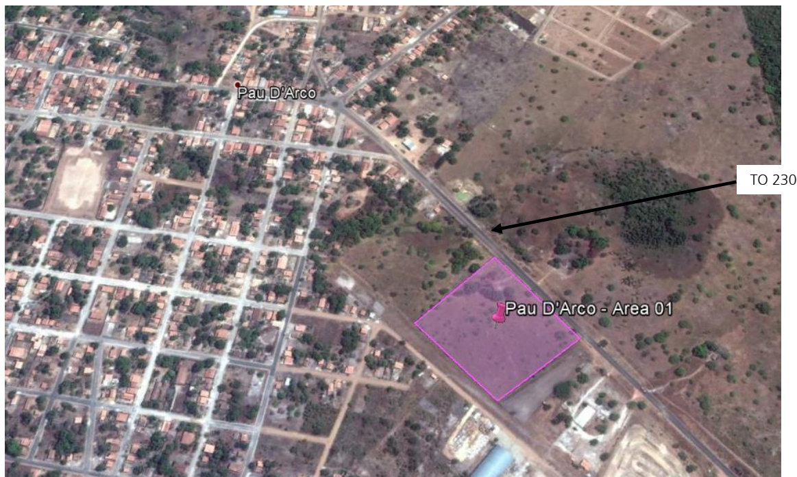
Figura 5 - Acesso ao canteiro de Obra "Pau D'Arco – Área 01"
