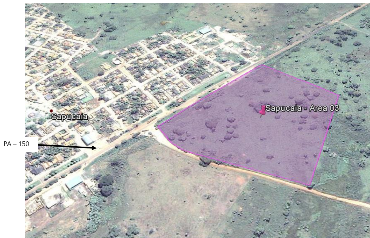
Figura 4 - Acesso ao canteiro de Obra "Sapucaia – Área 03"
