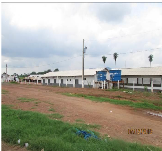
Figura 9 – Vista da via de acesso Área em análise: Curionópolis – Área 01
