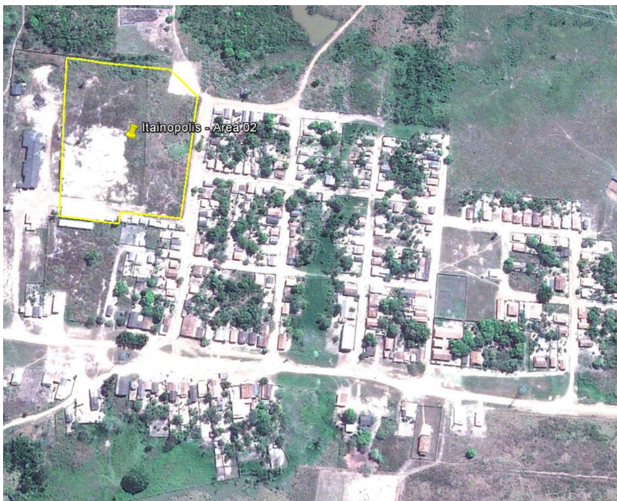
Figura 10 - Localização do canteiro de Obra "Itainópolis – Área 02".
