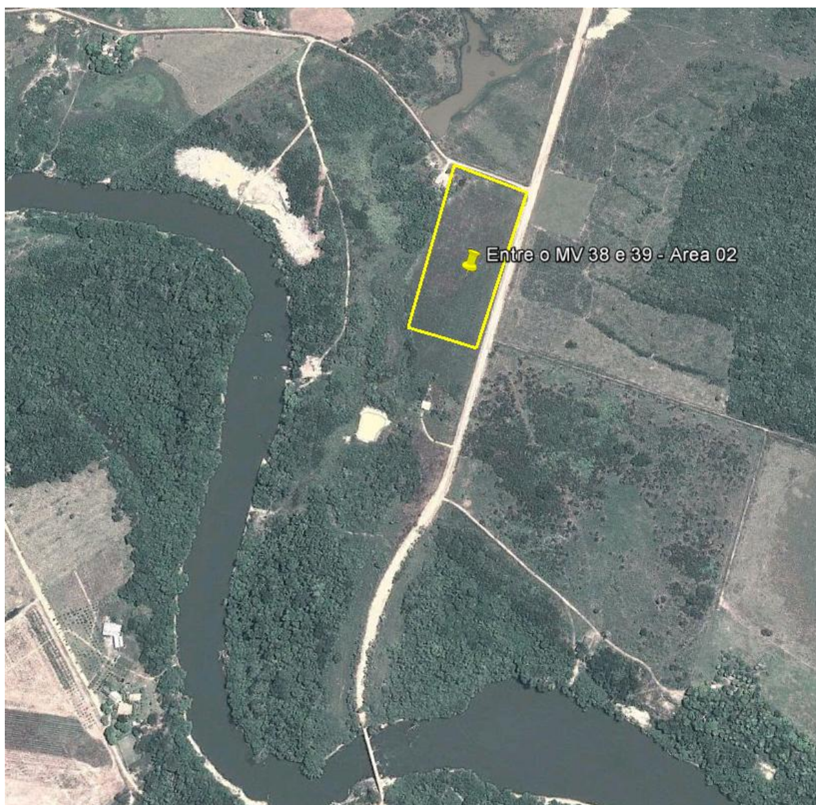
Figura 12 - Localização do canteiro de Obra "Entre o MV 38 e 39 – Área 02".
