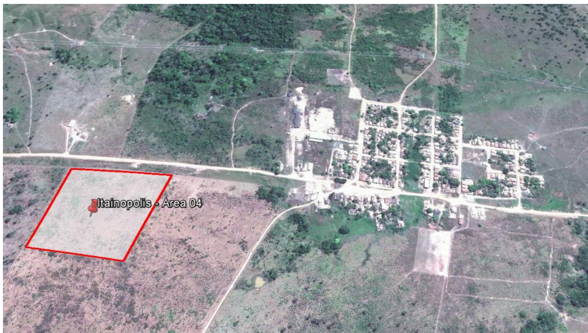
Figura 11 - Localização do canteiro de Obra "Itainópolis – Área 04". Fonte: Google Earth, 2014.
