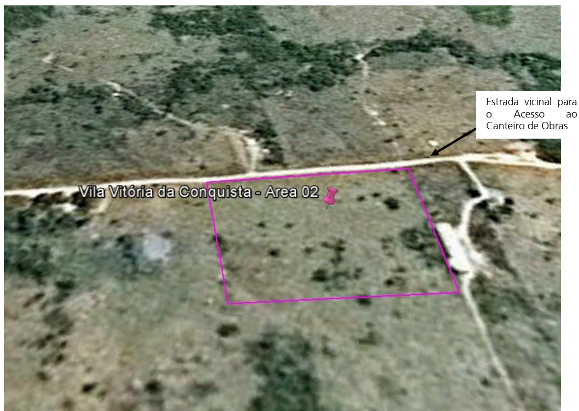
Figura 11 - Acesso ao canteiro de Obra “Vila Vitória da Conquista – Área 02”
