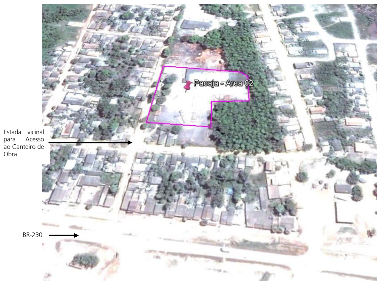
Figura 6 - Acesso ao canteiro de Obra “Pacaja – Área 02”
