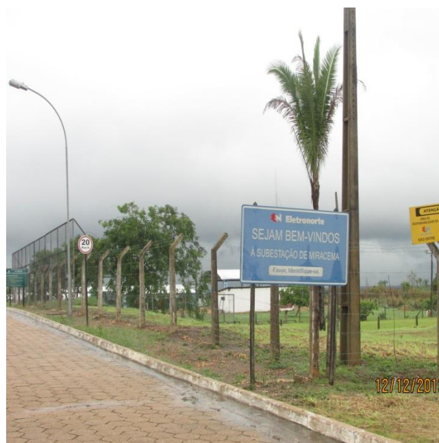
Figura 4 – Entrada de acesso para a SE Miracema - TO
