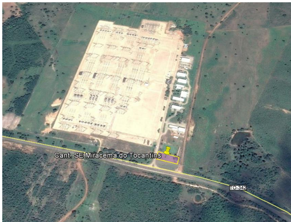
Figura 1 - Localização do canteiro de Obra na SE Miracema do Tocantins.
