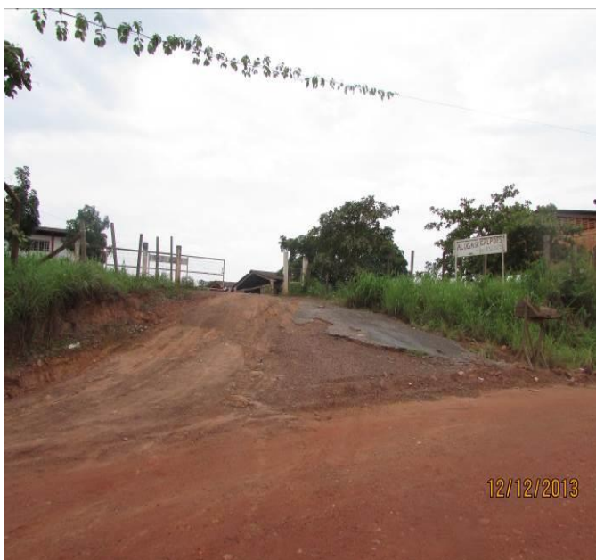
Figura 7 – Vista de entrada Área em análise: Guarai – Área 01 Fonte: ATE XXI, 2014.
