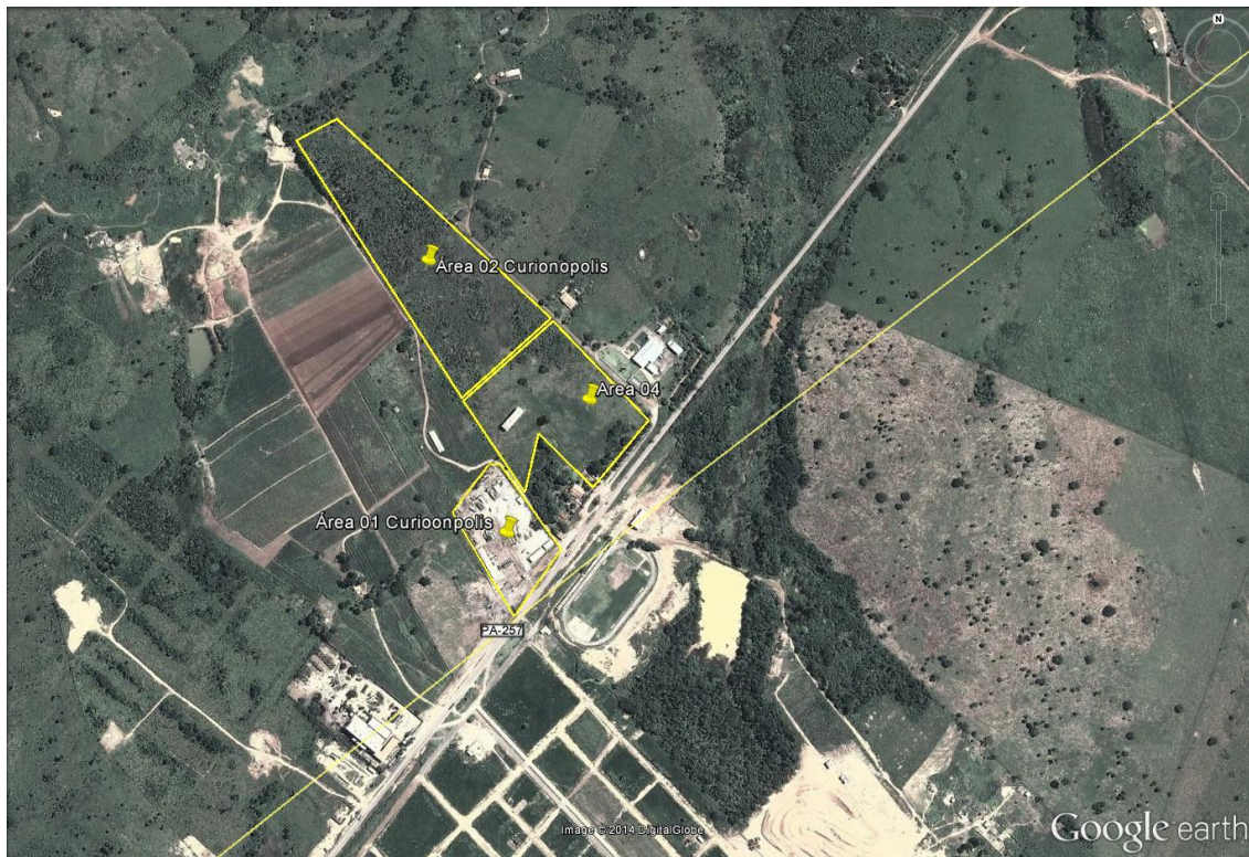
Figura 6.4-100 – Áreas 01, 02 e 04 para implantação de Canteiro de Obras em Curionópolis/PA.
