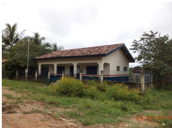
Figura 6.4-37 – Posto de saúde de Novo Planalto, Novo Repartimento/PA (Coordenadas: S 04°27'31.4"/ W 050°28'39.4").
