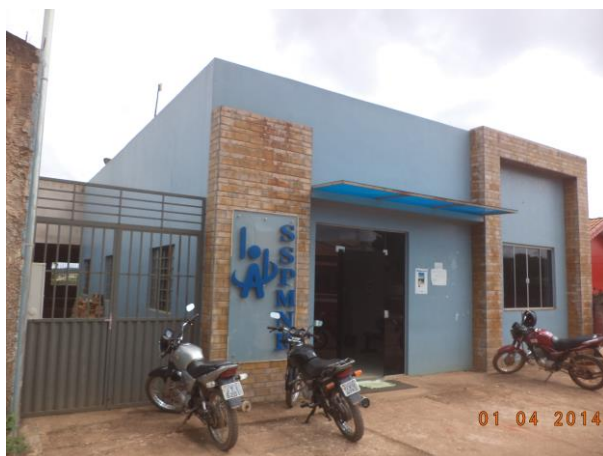
Figura 6.4-169 – Sindicato dos Funcionários Públicos, Novo Repartimento/PA (Coordenadas: S 04°15'02.9"/ W 049°57'02.1")
