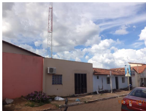
Figura 6.4-143 – Rádio Ativa, Guaraí/TO (Coordenadas: S 08°49'49,8" / W 048°30'41.9")
