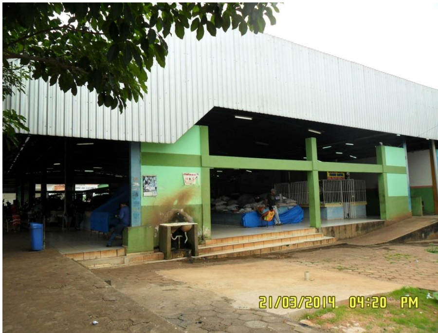
Figura 6.4-258 - Prédio do Mercado Público de Araguaína.
