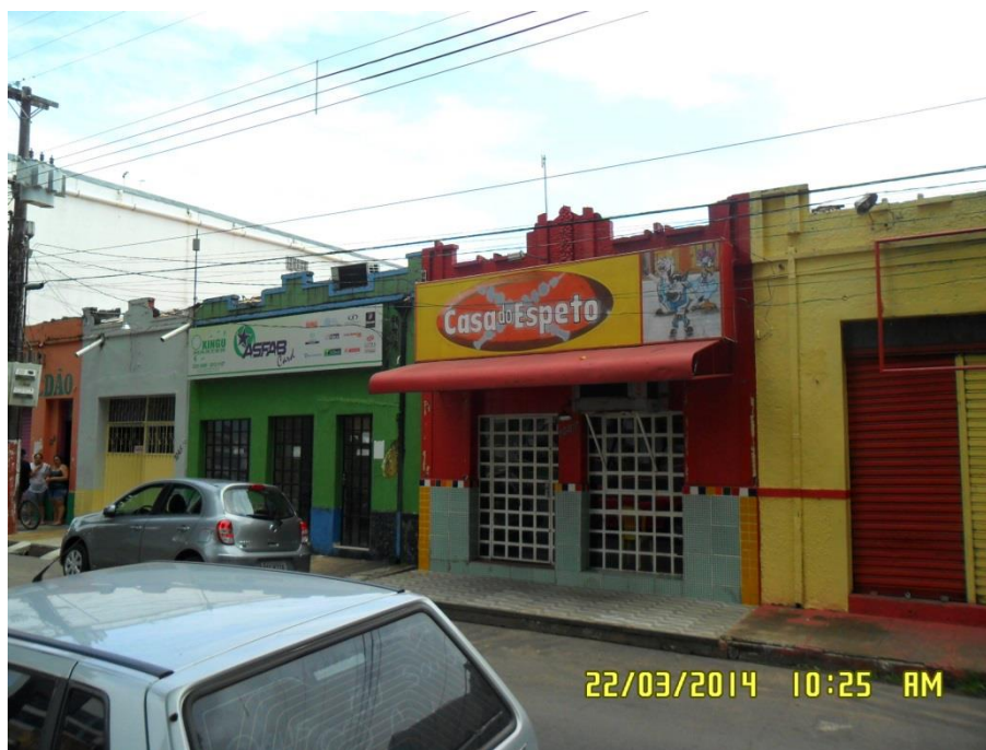
Figura 6.4-227 - Prédios da Rua Barão do Rio Branco (coordenadas: S 05°21'10.5" / W 049°08'15.5").
