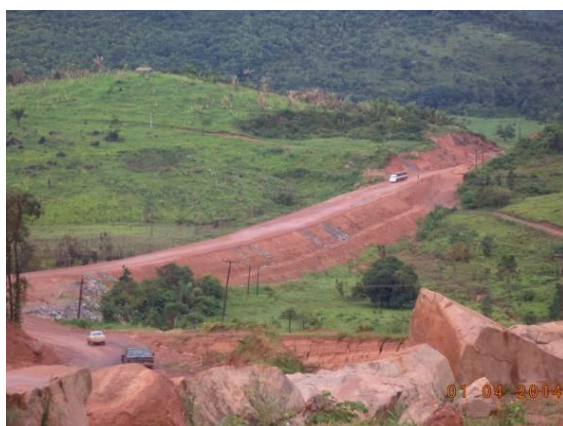
Figura 6.4-111 - Trecho da BR-230 (Rodovia Transamazônica) entre Novo Repartimento e Pacajá/PA, popularmente conhecido como "Ladeira da Velha" (Coordenadas: 3°50'47.5"S / 050°31'23.1"O).
