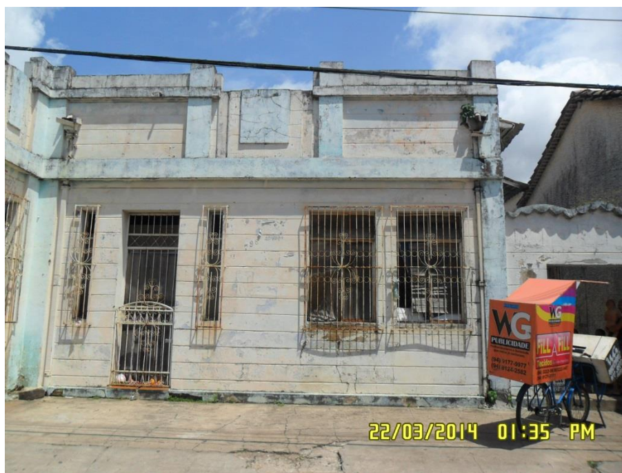
Figura 6.4-216 - Casa da Rua Barão do Rio Branco (coordenadas: S 05°21'10.5"/W 049°08'10.5"). Fonte: Bourscheid, março / 2014.
