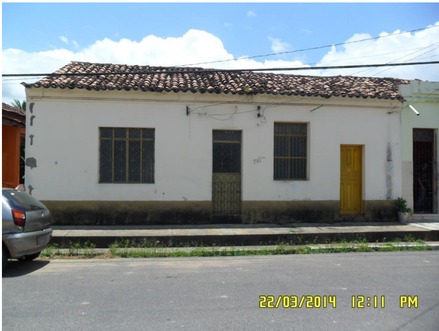
Figura 6.4-214 - Casa da Rua Barão do Rio Branco (coordenadas: S 05°21'10.5"/ W 049°08'10.5"). Fonte: Bourscheid, março / 2014.
