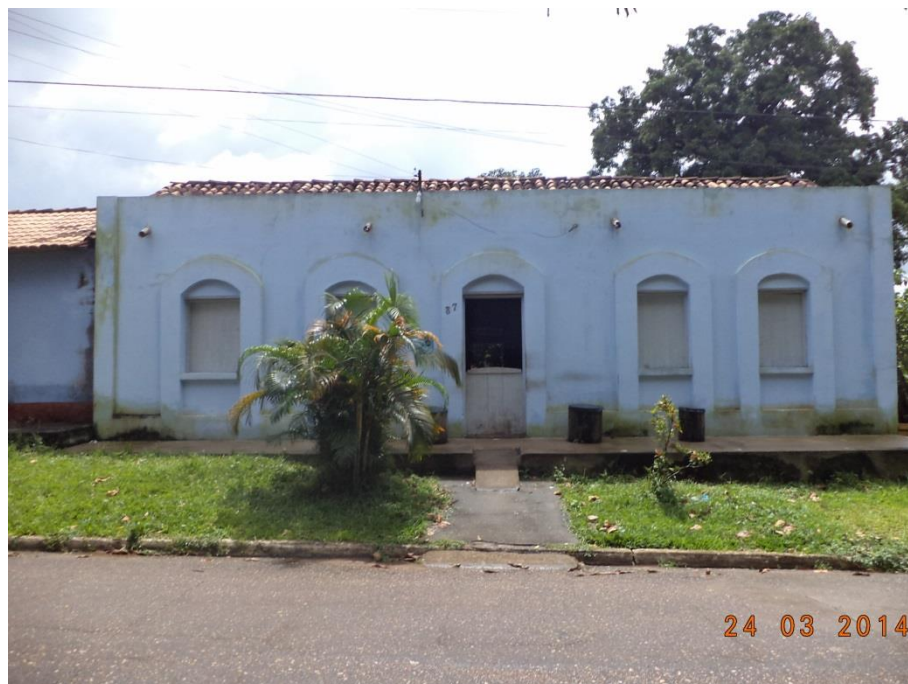
Figura 6.4-200 - Uma das primeiras casas erguidas em Itupiranga (coordenadas: S 05° 01' 58.6'' W 049° 19' 28.6'').
