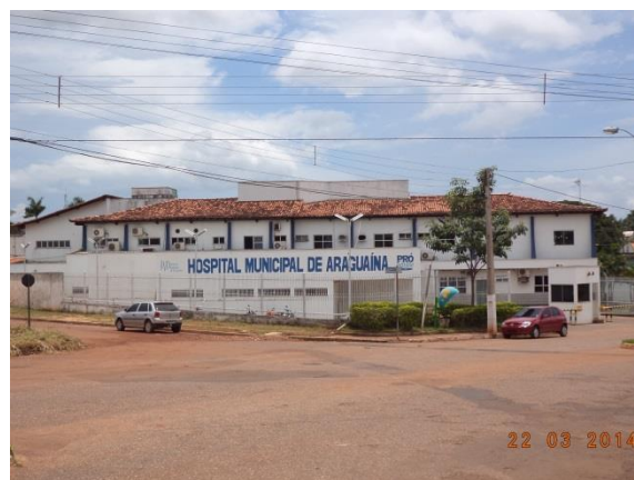
Figura 6.4-46 – Hospital Municipal de Araguaína/TO (Coordenadas: S 07°11'18.7"/ W 048°13'24.6").
