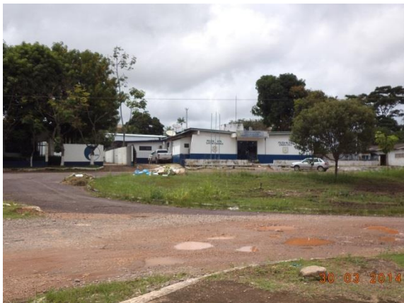
Figura 6.4-134 – Comando de Policiamento Regional de Marabá/PA (Coordenadas: 05°21'13.8" S / 049°05' 08.0" O).
