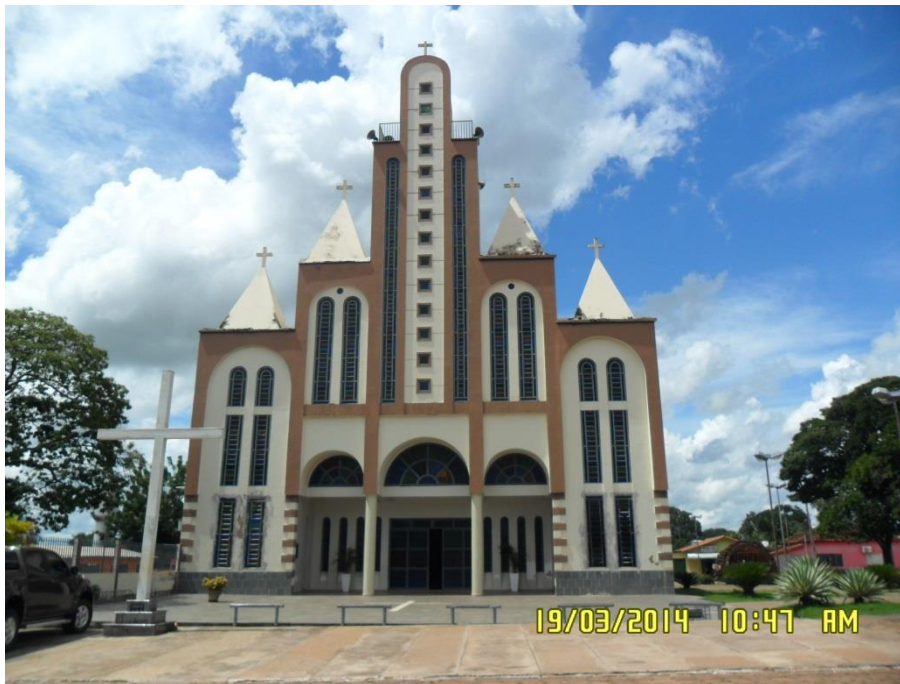
Figura 6.4-295 - Capela de São Pedro. (coordenadas: S 08° 50' 00.9" W 048° 30' 29.1"). Fonte: Bourscheid, março / 2014.
