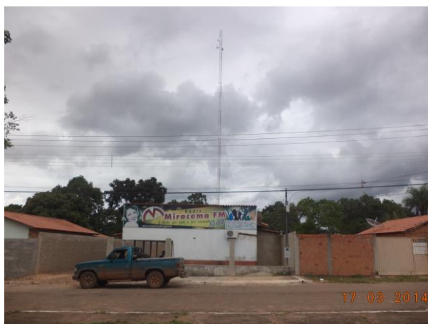
Figura 6.4-142 – Rádio Miracema do Tocantins/TO (Coordenadas: S 09°33'39.2" / W 048° 24'42.3")
