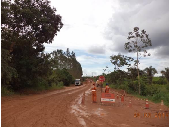
Figura 6.4-112 - - Trecho da BR-230 (Rodovia Transamazônica) entre Marabá e Itupiranga/PA (Coordenadas: 05°21'35.3"S / 049°07'23.5"O)
