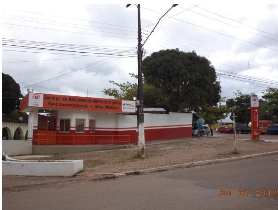
Figura 6.4-55 – Unidade do SAMU (Base descentralizada), Marabá/PA (Coordenadas: S 05°20'30.0"/ W 049° 05'14.4").
