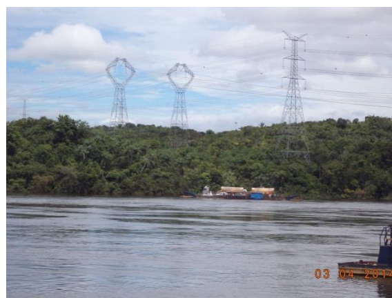
Figura 6.4-30 – Linhas de transmissão de energia já implantadas atravessando o Rio Xingu entre Vitória do Xingu e Anapu/PA (Coordenadas: S 03°07'16.4"/ W 051°41'57.6").
