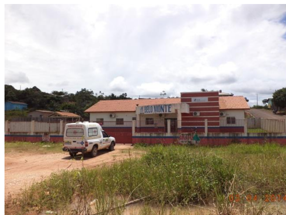
Figura 6.4-32 – Posto de saúde do povoado de Belo Monte do Pontal, Anapu/PA (Coordenadas: S 03°22'19.1''/ W 051°19'15.9'').
