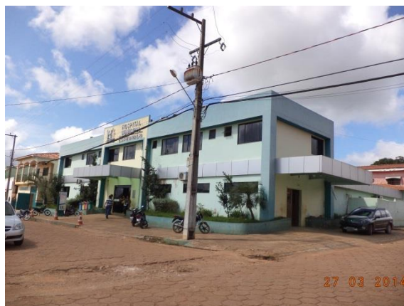
Figura 6.4-42 – Hospital Municipal Elcione Barbalho, Curionópolis/PA (Coordenadas: S 06°05'45.8"/ W 049°35'54.8").
