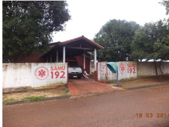
Figura 6.4-59 – Unidade do SAMU, Miranorte/TO (Coordenadas: S 09°32'20.5"/ W 048°35'35.1").
