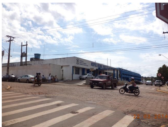
Figura 6.4-45 – Hospital Regional Público de Araguaína/TO (Coordenadas: S 07°11'37.9"/ W 048°12'38.6").
