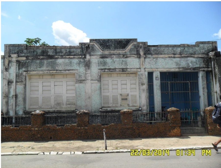
Figura 6.4-217 - Casa da Rua Barão do Rio Branco (coordenadas: S 05°21'10.5"/W 049°08'10.5"). Fonte: Bourscheid, março / 2014.
