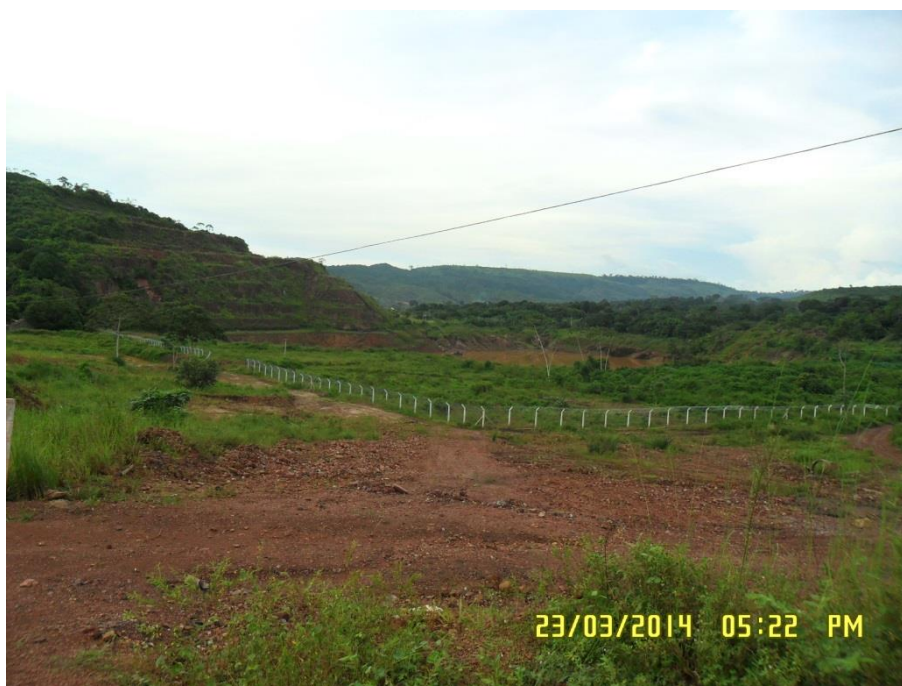
Figura 6.4-251 – Vista geral da área de exploração em Serra Pelada (coordenadas: S 05°56'54.9'' W 049°39'53.8'').
