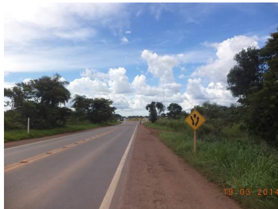
Figura 6.4-117 – Acesso a Guaraí/TO vindo de Fortaleza do Tabocão/TO pela BR-153 (Coordenadas: 08°51’44.1”S / 048°30’29.9”O)
