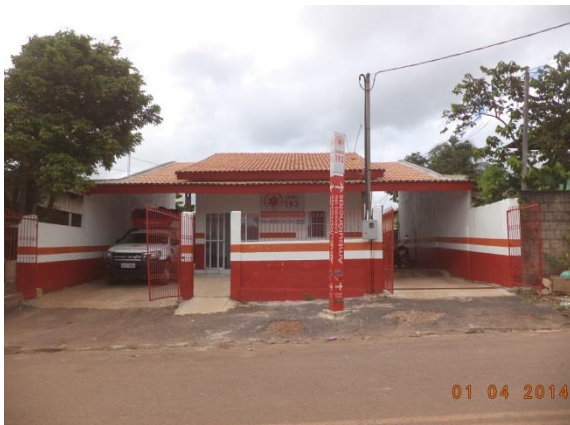
Figura 6.4-53 – Unidade do SAMU, Novo Repartimento/PA (Coordenadas: S 04°15'03.0"/ W 049° 57'01.6").
