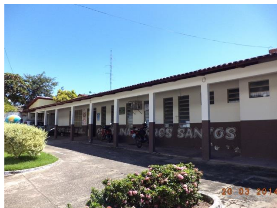
Figura 6.4-48 – Hospital Municipal de Itaporã do Tocantins/TO (Coordenadas: S 08°34'24.3"/ W 048°41'23.3").
