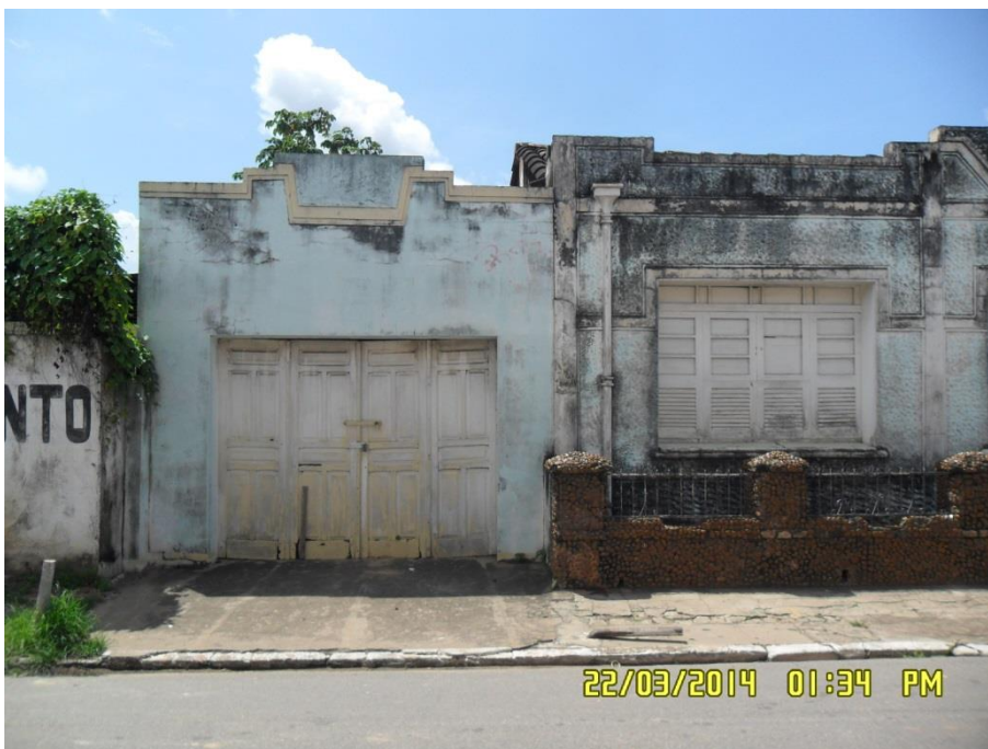
Figura 6.4-218 - Casa da Rua Barão do Rio Branco (coordenadas: S 05°21'10.5"/ W 049°08'10.5"). Fonte: Bourscheid, março / 2014).
