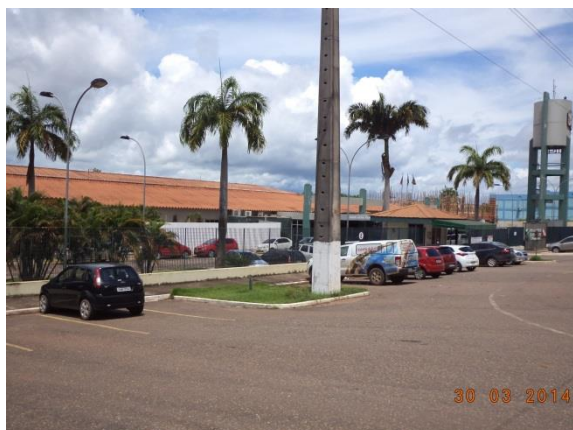
Figura 6.4-41 – Hospital Regional de Marabá/PA (Coordenadas: S 05°21'28.3"/ W 049° 04'45.3").
