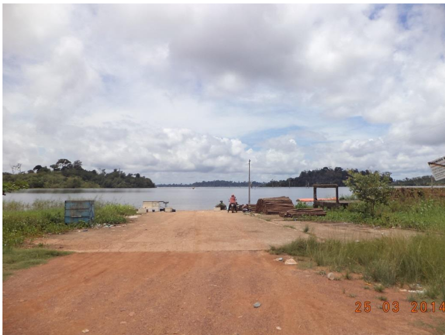
Figura 6.4-196 - Polo Pesqueiro de Novo Repartimento (coordenadas: S 04°19'53"/ W 49°47'47").
