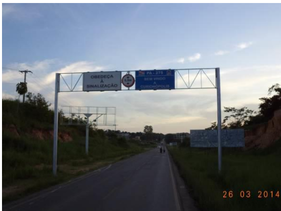
Figura 6.4-114 – Acesso a Curionópolis pela PA-275 vindo de Eldorado dos Carajás/PA (Coordenadas: 06°05'28.5"S / 049° 35'28.7"O)
