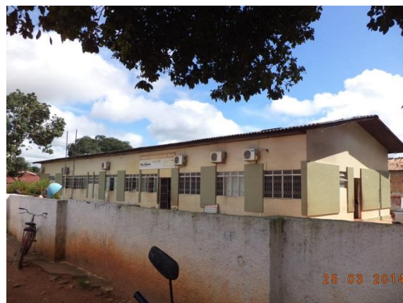
Figura 6.4-44 – Hospital Municipal de Rio Maria/PA (Coordenadas: S 07°18'37.6"/ W 050° 02'57.5").
