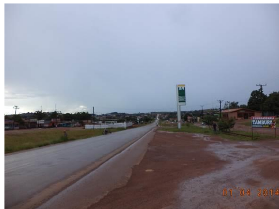
Figura 6.4-110 - Trecho da BR-230 (Rodovia Transamazônica) na entrada de Pacajá vindo de Novo Repartimento/PA (Coordenada: 03°50'10.7"S / 050°37'35.6"O).
