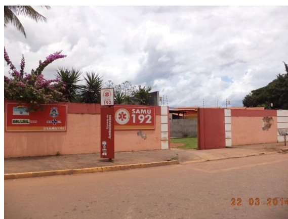
Figura 6.4-58 – Unidade do SAMU, Araguaína/TO (Coordenadas: S 07°11'05.8"/ W 048°13'15.7").
