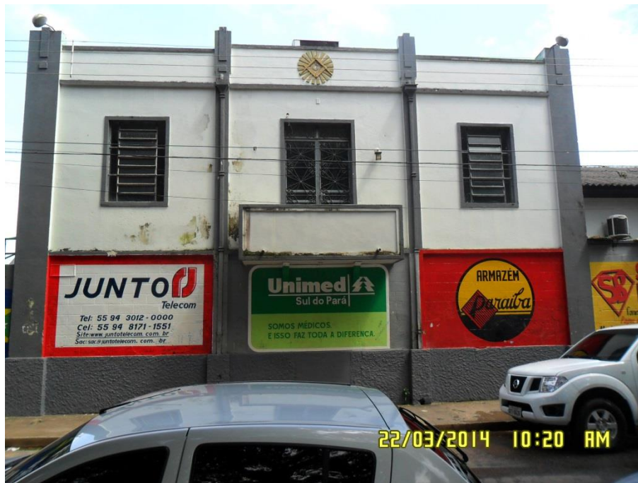
Figura 6.4-226 - Loja Maçônica (coordenadas: S 05° 21' 00.3" W 049° 08' 13.2").
