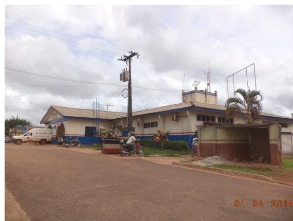
Figura 6.4-34 – Hospital municipal São Francisco, Novo Repartimento/PA (Coordenadas: S 05°22'14.0''/ W 049°07'55.7'').
