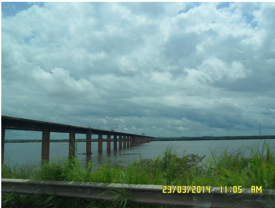
Figura 6.4-238 - Ponte construída pela Empresa Vale do Rio Doce. (coordenadas: S 05° 18' 07.8'' W 049° 04' 20.7'').
