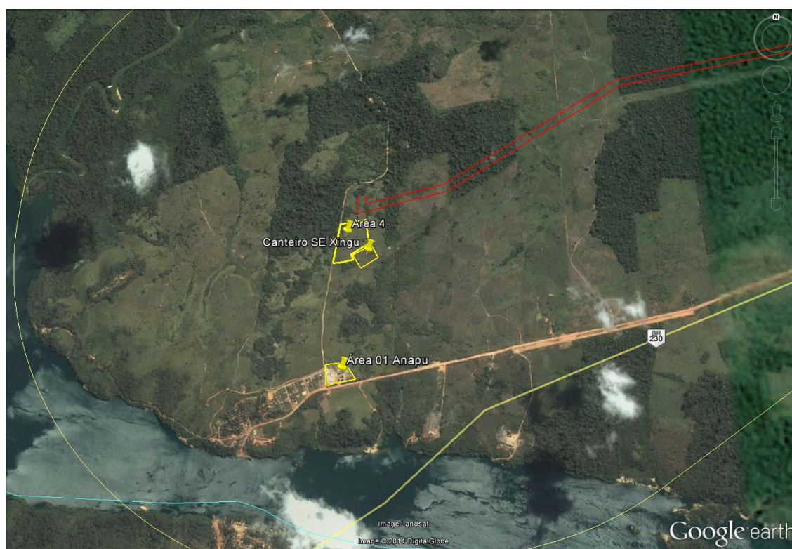
Figura 6.4-81– Áreas 1 e 4 para implantação de Canteiro de Obras em Anapu/PA.
