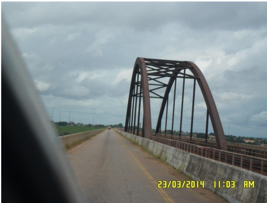
Figura 6.4-237 - Ponte construída pela Empresa Vale do Rio Doce (coordenadas: S 05° 18' 07.8'' W 049° 04' 20.7'').
