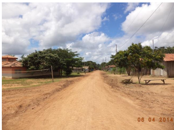
Figura 6.4-15- Assentamento Rio Preto Malha II, Marabá/PA (Coordenadas: S 05°32'51.7"/W 050°02'28.6").
