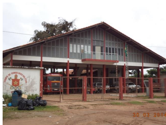
Figura 6.4-56 – 5º Grupamento Bombeiro Militar, Marabá/PA (Coordenadas: S 05°22'14.0"/ W 049°07'55.7").
