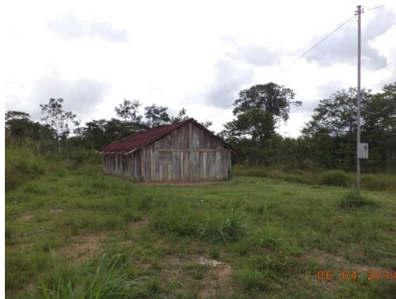
Figura 6.4-16 – Escola Monteiro Lobato, Assentamento Pouso Alegre, Marabá/PA (Coordenadas: S 05°25'09.4"/W 050°09'16.6").
