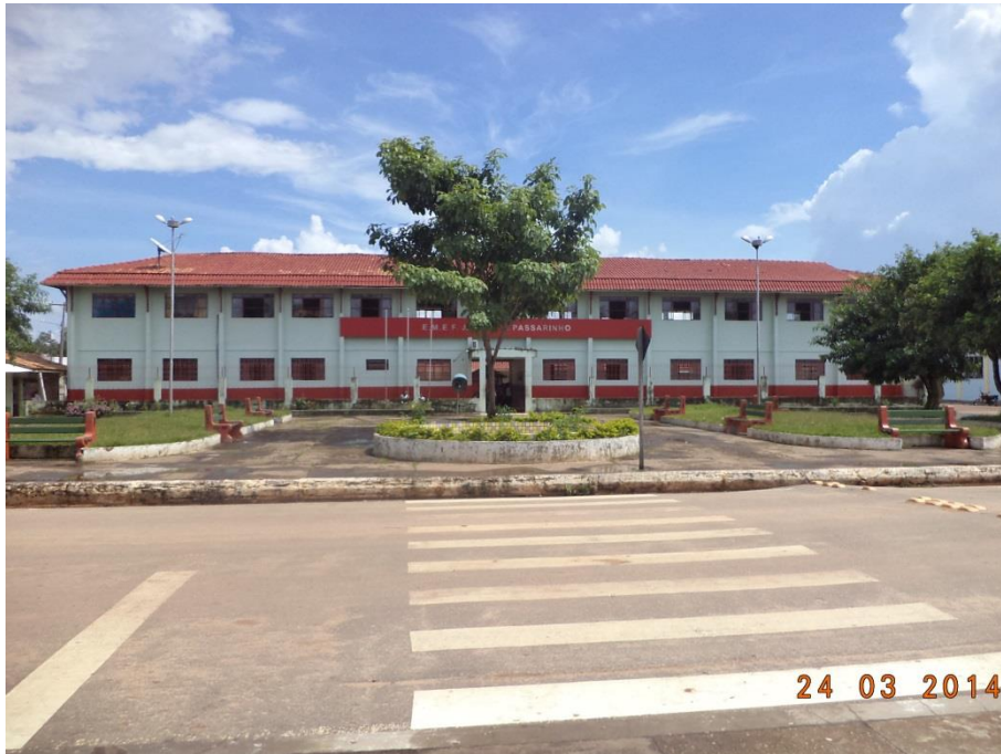
Figura 6.4-203 - Escola Jarbas Passarinho (coordenadas: S 05° 08' 05.9" W 049° 19' 40.8").
