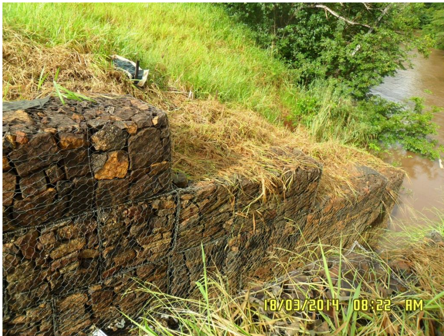
Figura 6.4-311 - Represa na Margem do Rio Providência. (coordenadas: S 09° 31' 30.0'' W 048° 35' 36.8'').
