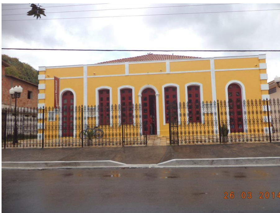
Figura 6.4-210 - Biblioteca Pública Municipal, antigo mercado público de Marabá ((coordenadas: S 05° 21' 00.3" W 049° 08' 20.4").
