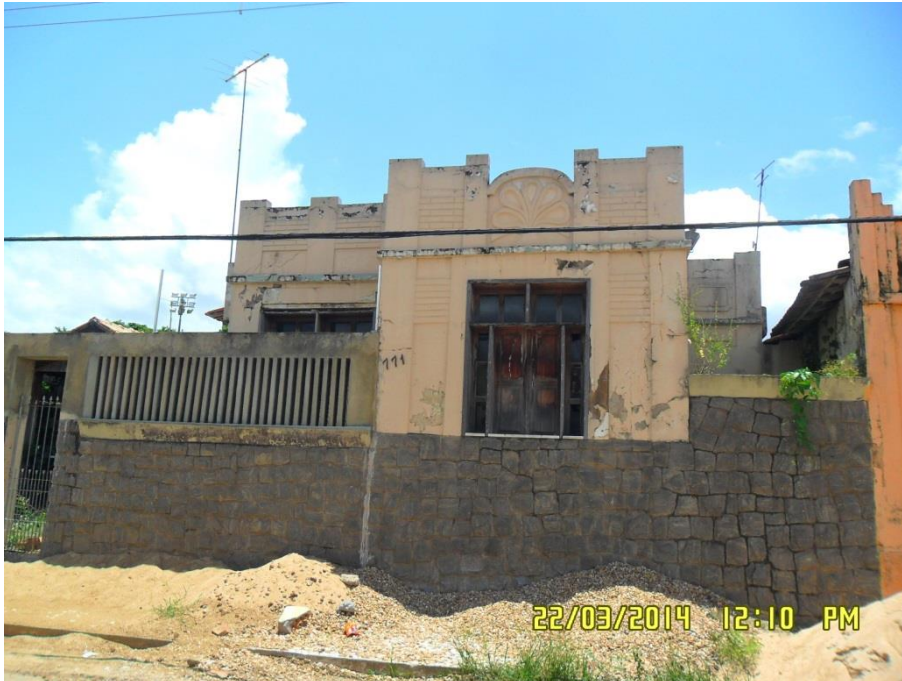
Figura 6.4-213 - Casa da Rua Barão do Rio Branco (coordenadas: S 05°21'10.5"/ W 049°08'10.5"). Fonte: Bourscheid, março / 2014.
