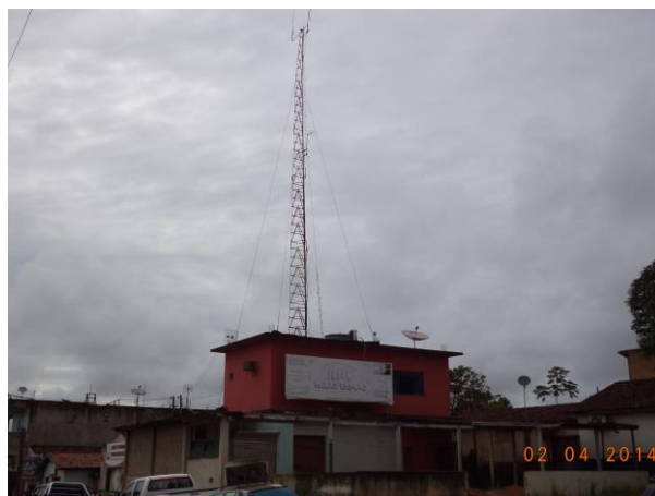
Figura 6.4-156 – Rádio Novo Tempo, Pacajá/PA (Coordenadas: S 03°50'10.8" / W 050° 38'14.5")
