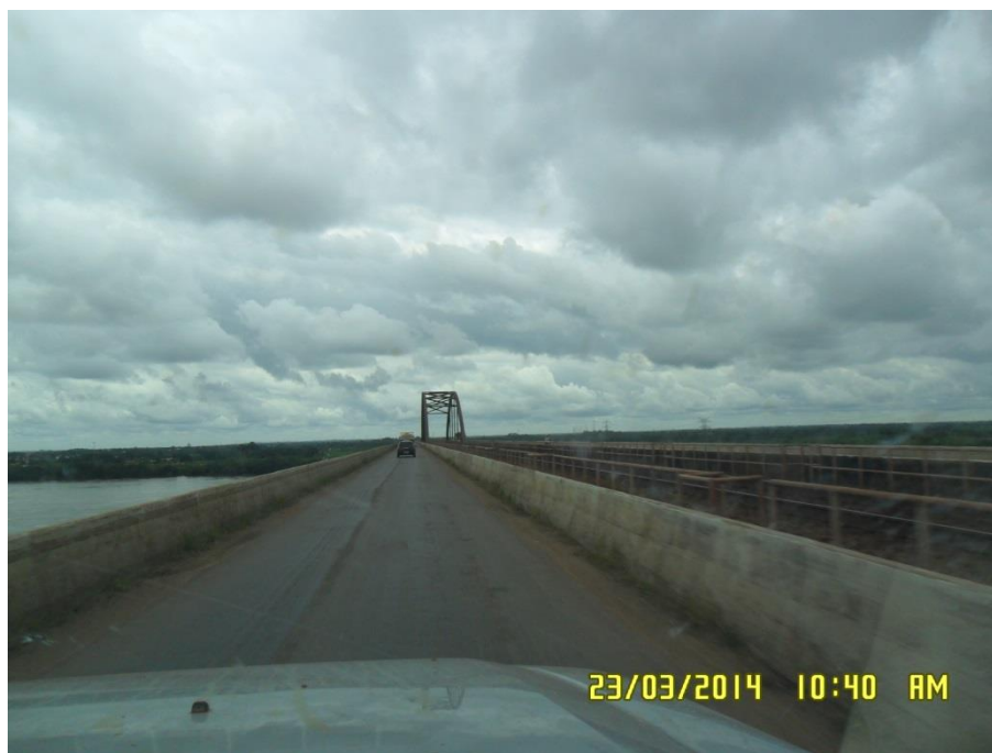
Figura 6.4-236 - Ponte construída pela Empresa Vale do Rio Doce, entre as pistas encontra-se a linha férrea (coordenadas: S 05° 18' 07.8" W 049° 04' 20.7").
