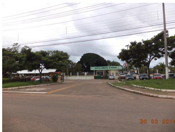
Figura 6.4-40 – Hospital Municipal de Marabá/PA (Coordenadas: S 05°20'29.2"/ W 049°05'11.6").
