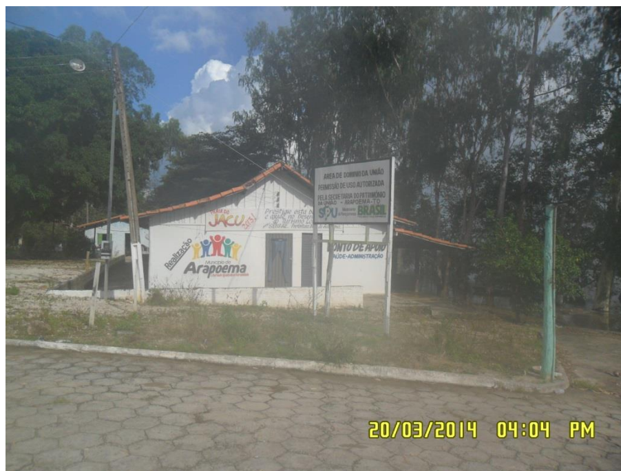
Figura 6.4-267 - Ponto de Apoio da Prefeitura de Arapoema na Praia do Jacu (coordenadas: S 07° 42' 43.4" W 049° 15' 52.8").
