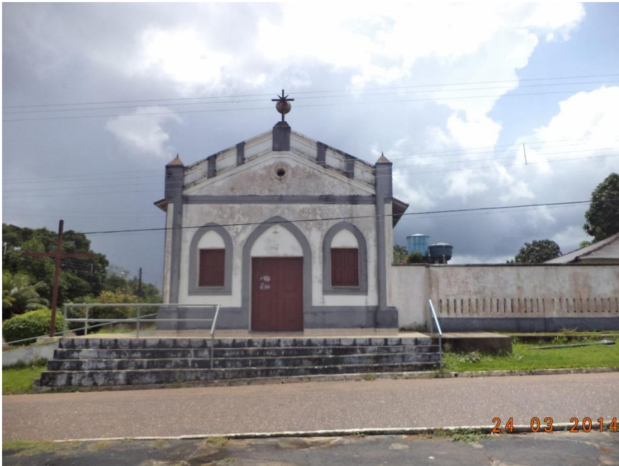
Figura 6.4-201 - Igreja de Santo Antônio edificada em 1940 (coordenadas: S 05° 01' 58.6" W 049° 19' 28.6").
