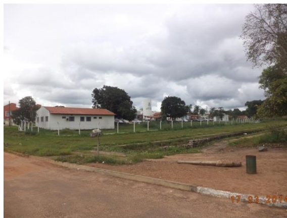
Figura 6.4-50 – Hospital Regional de Miracema do Tocantins/TO (Coordenadas: S 09°34'07.1"/ W 048°24'43.2").
