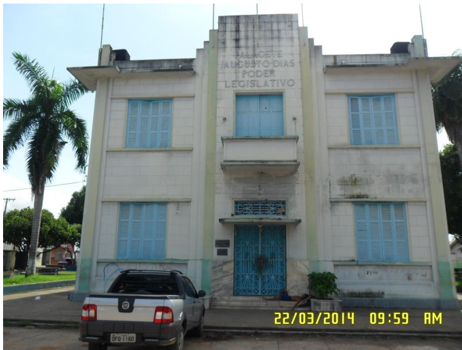
Figura 6.4-220 - Palacete Augusto Dias (coordenadas: S 05° 20' 57.0" W 049° 08' 08.5").
